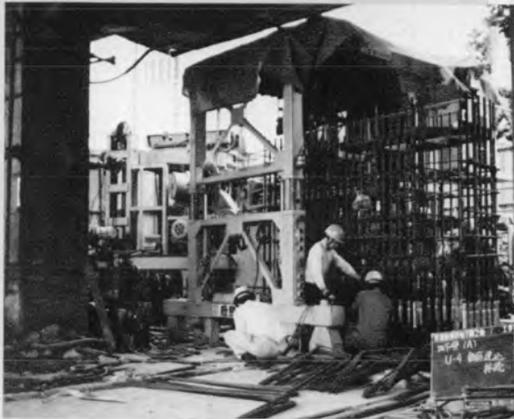
⇨新幹線高架下での連壁作業
