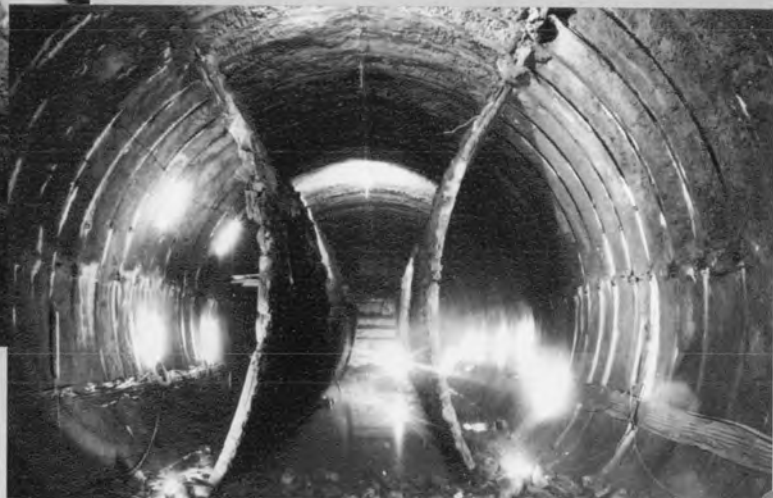
⇨ NATMを使った サイロット工法 駅部トンネル掘 削完了
