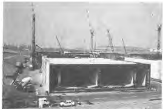
写真-4 多摩川沈埋トンネル函体製作
