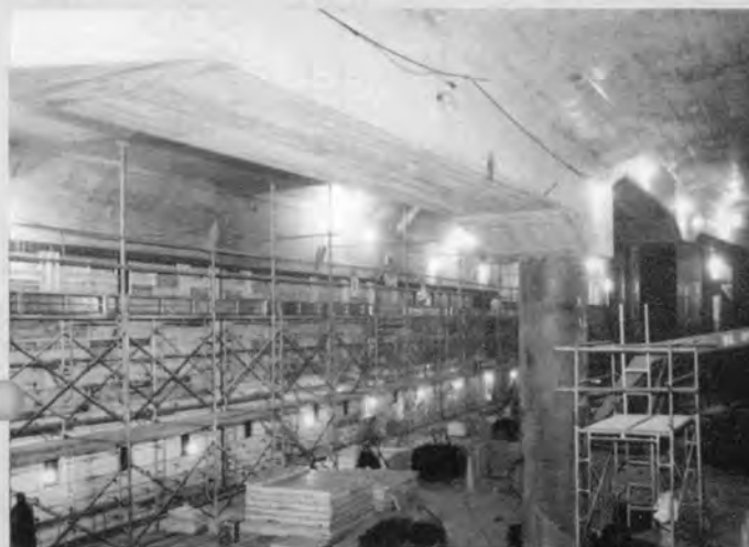
⇨ B0, B1躯体 地下1階の躯体が完成
