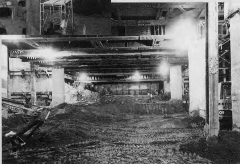
地下鉄丸ノ内線の⇨ アンダーピニング 完了, その下の掘削
