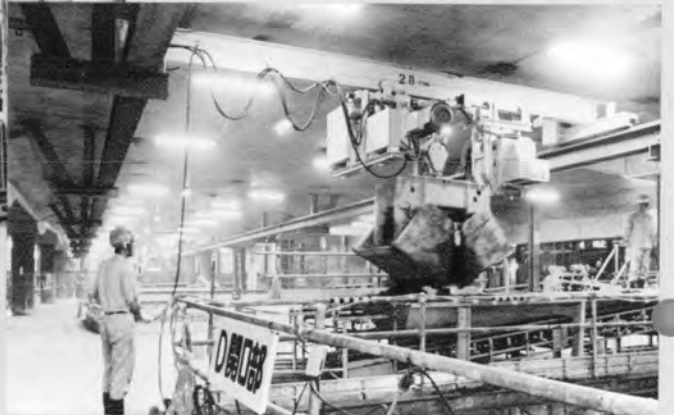
⇨掘削土砂搬出用のテルファークレーン B1階躯体が完成
