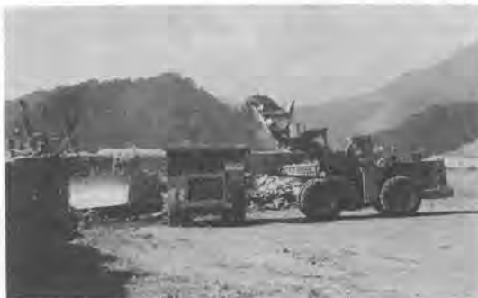
写真-1 切土工, 積込状況 D11, 992C, 777
