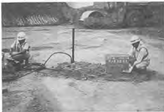
写真-3 盛土管理工、層別沈下計設置状況
