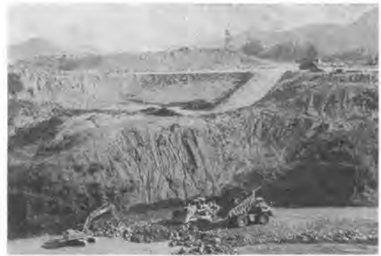
写真-2 盛土工, 敷ならし・転圧状況 D9, 0.9m³ ブレーカ, 77t DT
