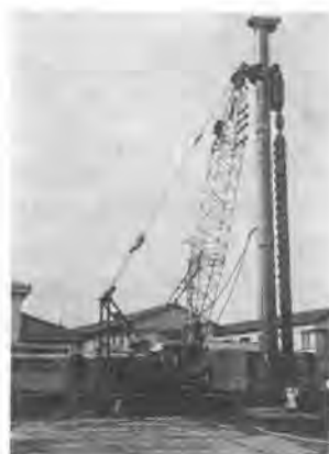
写真-1 施工機械
