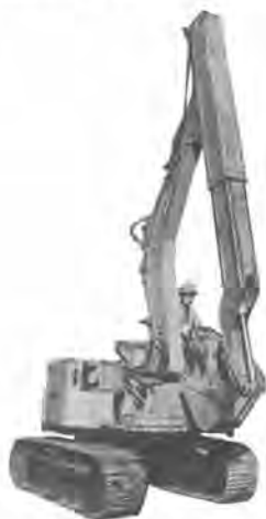
写真—4 レンタルのニッケン CBH-21-T 油圧ショベル
