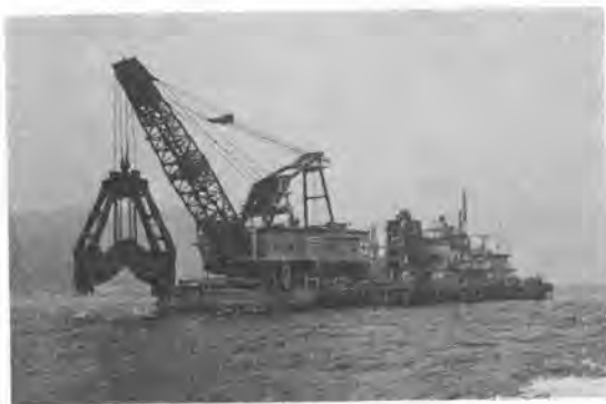
写真-1 大型グラブ船“関門”
