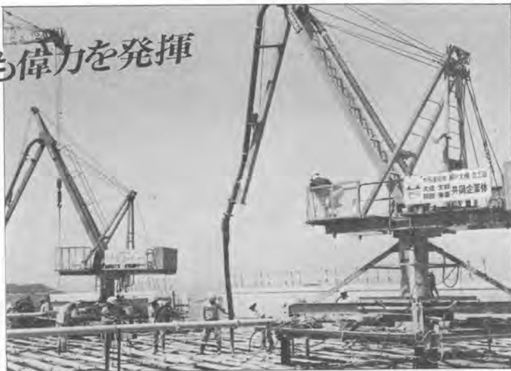
(本四架橋現場設置例)
