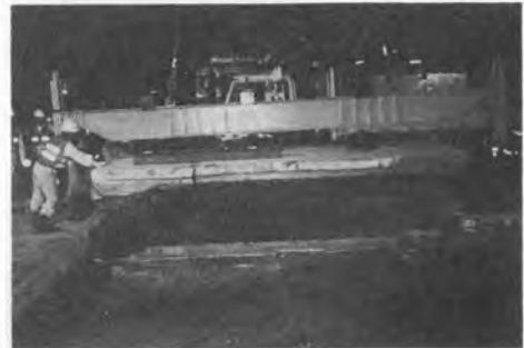
写真-2 既設舗装版撤去
