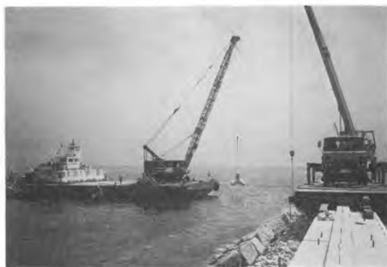
写真-11 緩傾斜石積護岸の消波ブロックの据付
