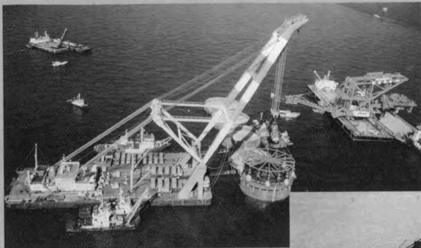
⇨ 鋼板セル打設状況
