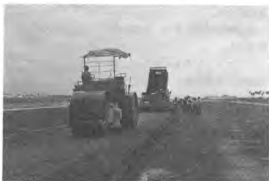
写真-5 アスファルト舗装工事
