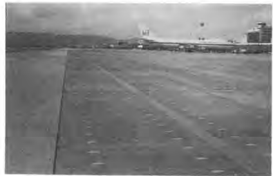
写真-6 PC版舗装完成
