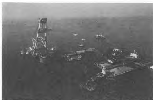
写真-9 鋼製セルの打設，中詰の施工
