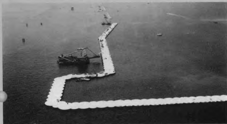
⇨ ミキサ船によるコンクリート打設状況
