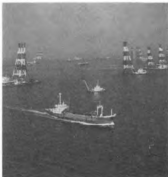
写真-7 地盤改良工事
