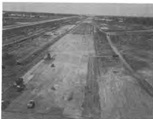
写真-2 粒調碎石路盤施工状況
