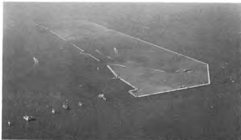
写真-12 空港島の護岸概成状況（昭和63年12月）
