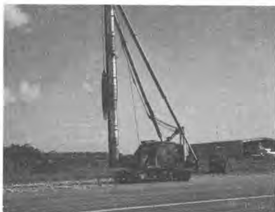
写真-3 既設コンクリート舗装滑走路壊し
