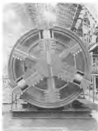
写真—1 正面，掘進中
