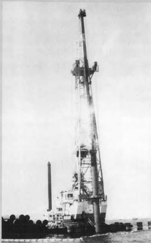
⇨ 杭打船による鋼管杭打設状況
