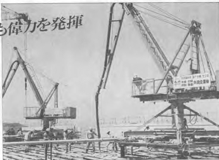
(本四架橋現場設置例)
