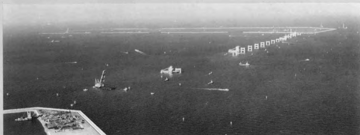
⇨ 陸岸からみた連絡橋 (1988.12)
