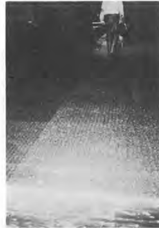
写真-8 ゴム除去作業状況
