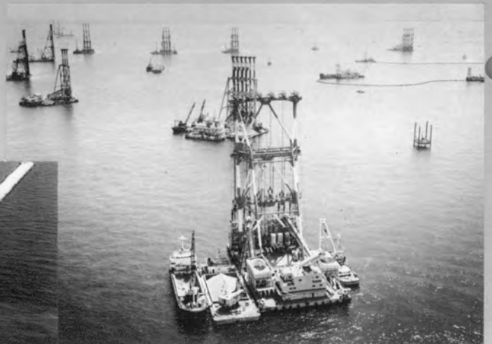
⇨ 地盤改良船による施工状況
