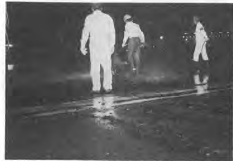
写真-7 ゴム除去作業状況
