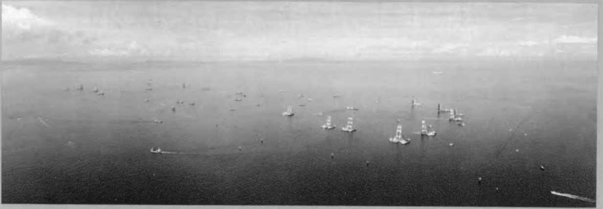
⇨ 空港島地盤改良最盛期 (1987. 8)
