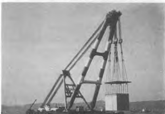
写真-8 ケーソンの据付
