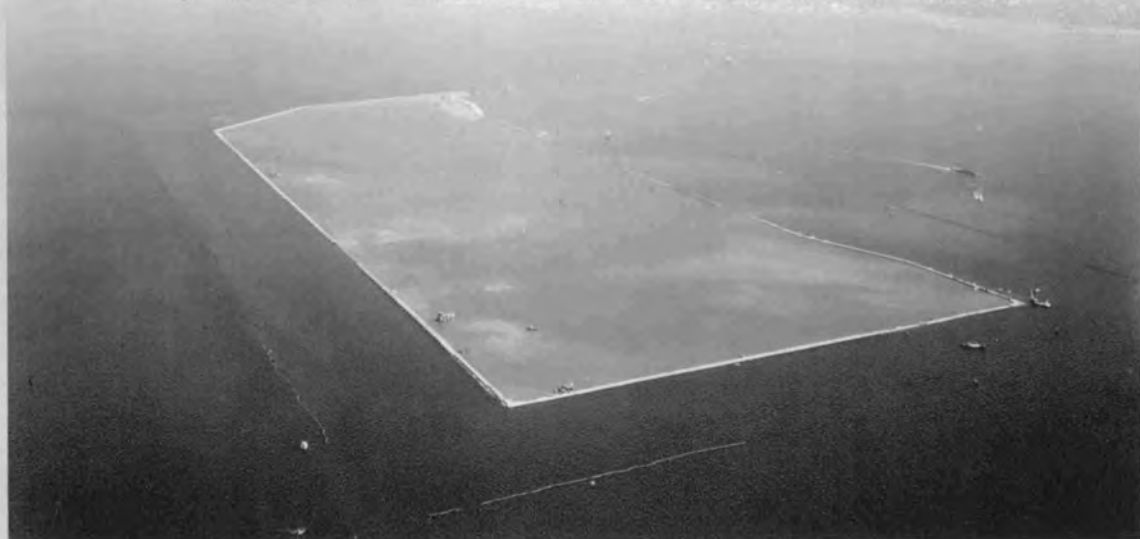
⇨ 西側からみた空港島および連絡橋 (1989. 1)
