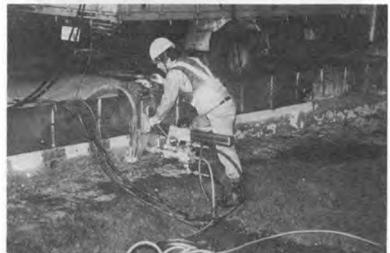
写真-3 水平コアボーリング
