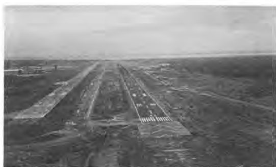
写真-1 既設滑走路と新設滑走路
