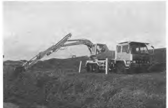
写真-2 レンタルのニックン TBHS-11 トラック式油圧ショベル
