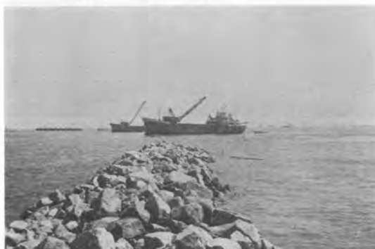
写真-10 緩傾斜石積護岸の捨石の施工
