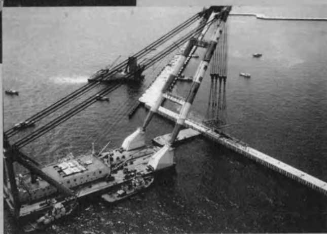
⇨ 直立消波ケーソン据付状況
