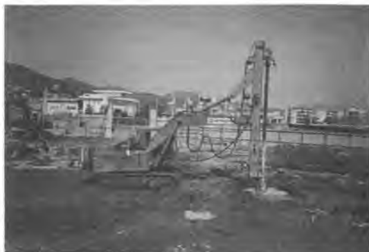
写真-1 攪拌処理機施工状況
