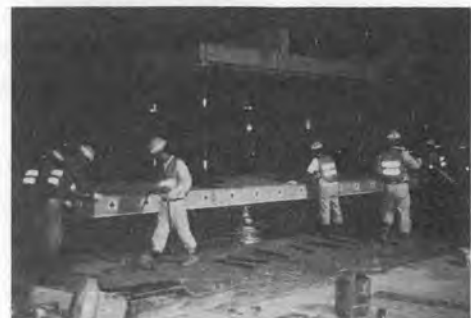
写真-4 PC版敷設
