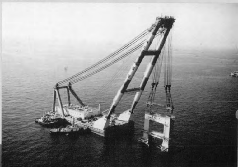
⇨ 鋼製橋脚設置状況
