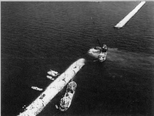
⇨ ガット船による捨石投入状況
