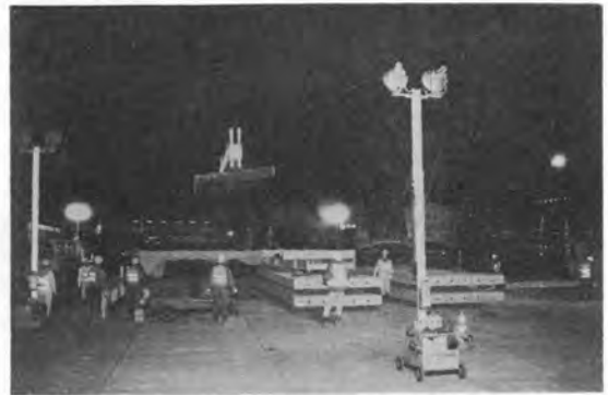
写真-1 施工状況
