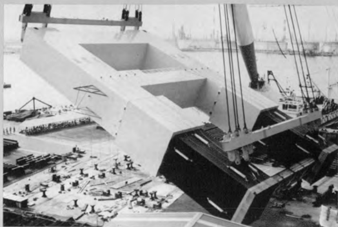
⇨ 工場での鋼製橋脚脚柱部建起し状況
