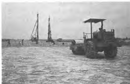
写真-4 コンクリート舗装壊しおよび転圧
