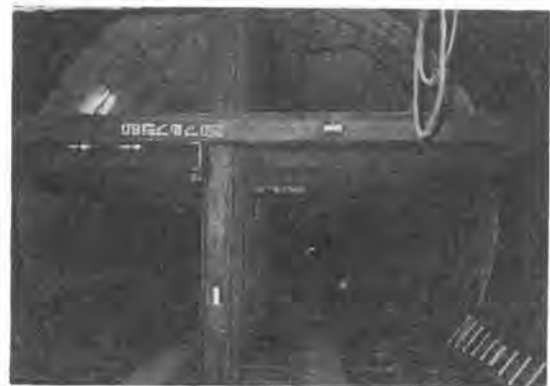
写真-1 変形防止工施工後の先行トンネル
