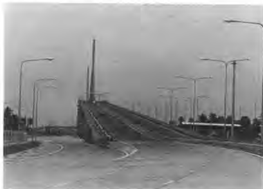
写真—1 橋梁全景
