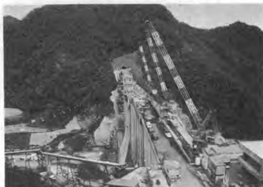
写真-2 シブクライミングクレーンによる施工 (昭和62年8月18日右岸より全景)
