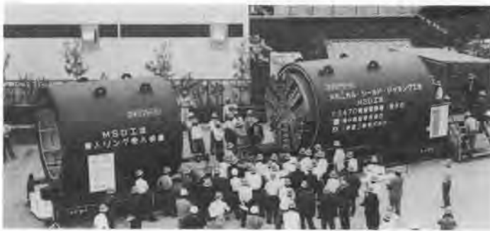
写真-2 シールド機と受入装置の外観
