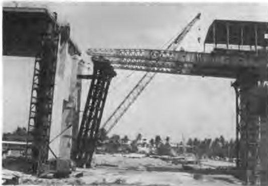
写真-3 傾斜タワー
