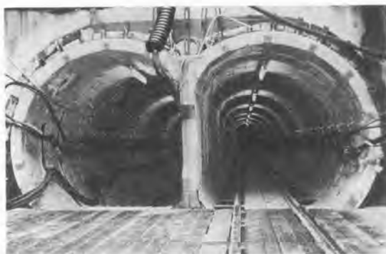
写真-1 横二連型トンネル
