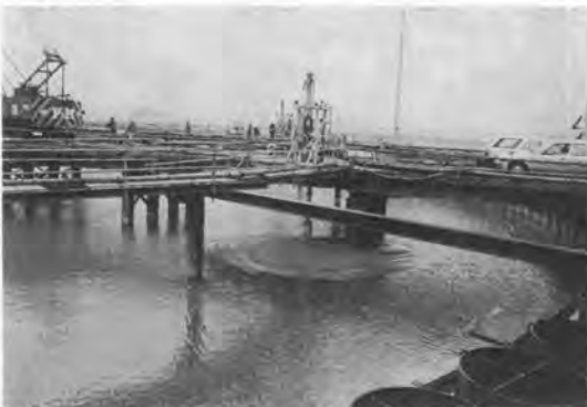
写真-2 石炭灰スラリー打設状況
