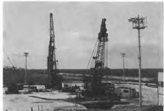
写真-3 地中連続壁掘削状況
