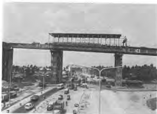
写真-2 移動支保工
