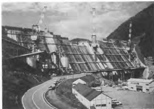
写真-1 シブクライミングクレーンによる施工 (昭和62年8月18日下流側全景)
