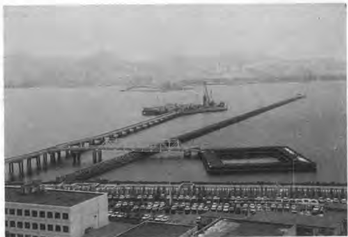
写真-4 各基礎の進捗状況（手前から 1A 二重締切り、3P・4P 築島）
