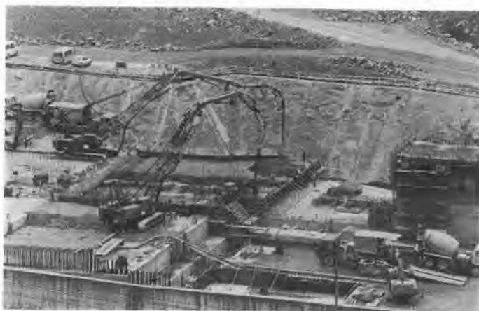
写真-3 PCD 工法打設状況
