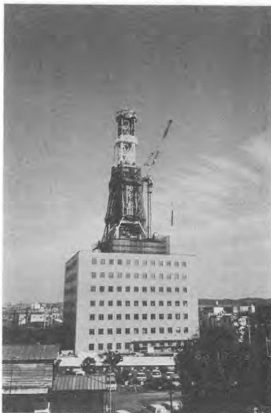
写真-1 東京電力多摩支店通信鉄塔
