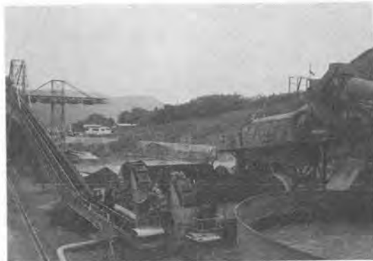
写真-4 山砂水洗プラントの一部
