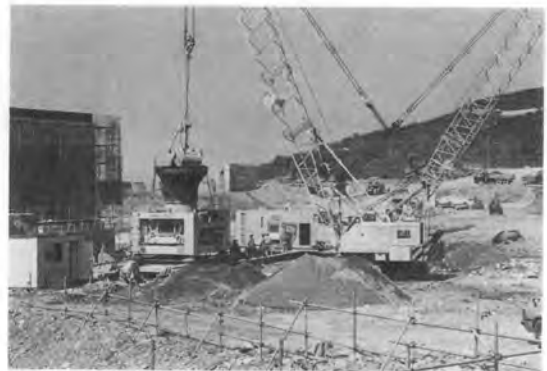
写真-5 砕石・砂投状況
