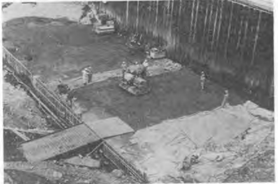
写真-7 総合試験状況（自動締固め作業）
