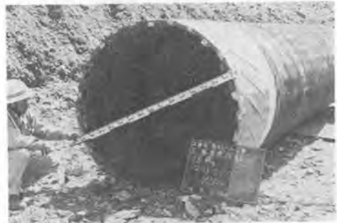
写真-2 ケーシング先端ビット
