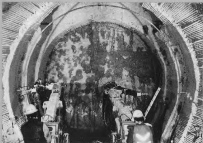
⇨SDジャンボによる スロット削孔状況
