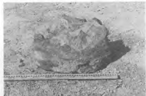
写真-3 転石削孔状況
