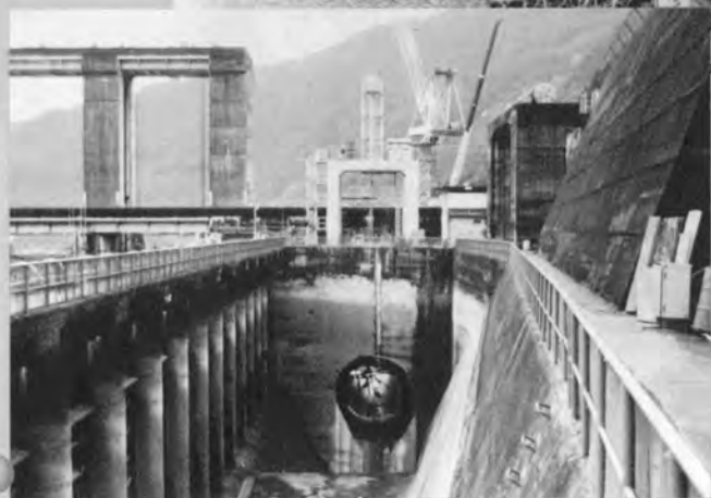
⇨取水口穴あけ完了後 (ゲート等据付後)の状況
