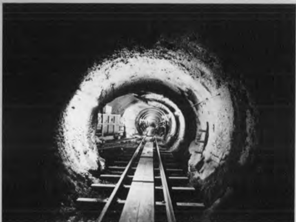
⇨TBM で掘削された トンネルの状況
