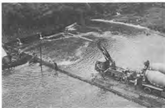
写真2 砂防ダム減勢池水叩き部改修工事
