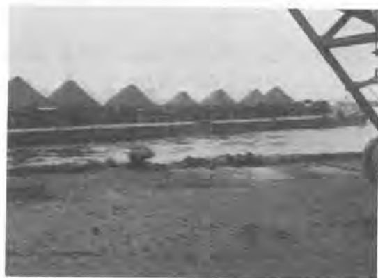
写真一 木更津新港で積込を持つ砂パイル群
