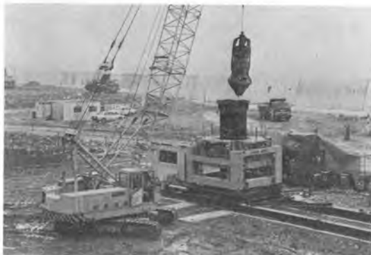
写真-4 削孔・排土状況
