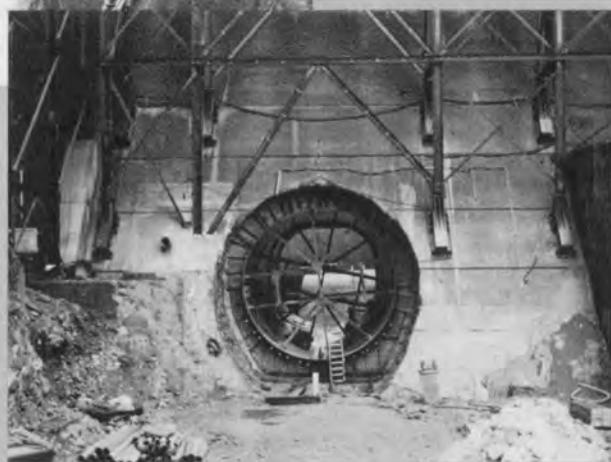
⇨堤体穴あけ後の鉄管据付状況⇨
