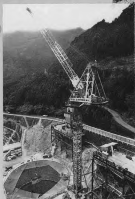
⇨発電所立坑とタワークレーン
