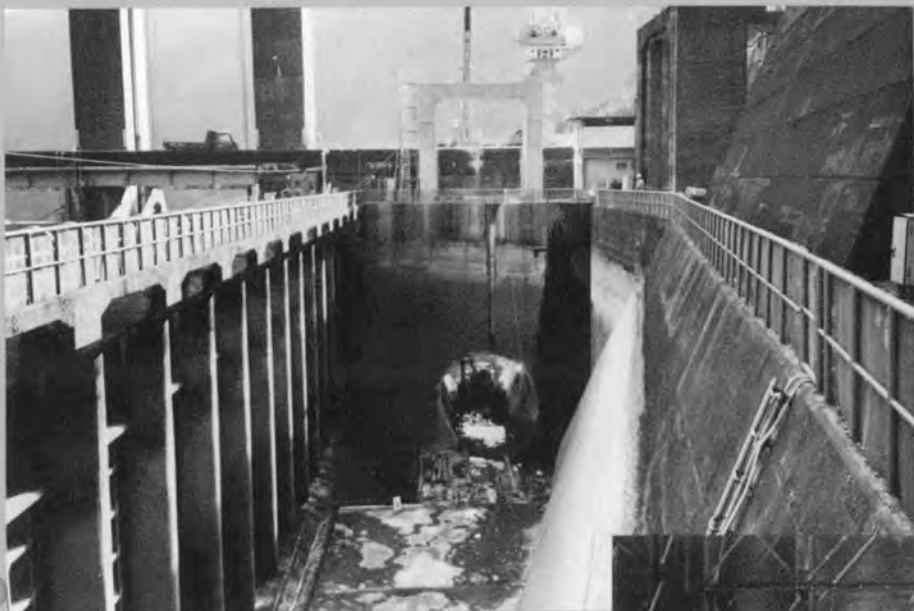
⇨取水庭より見た穴あけ部の状況
