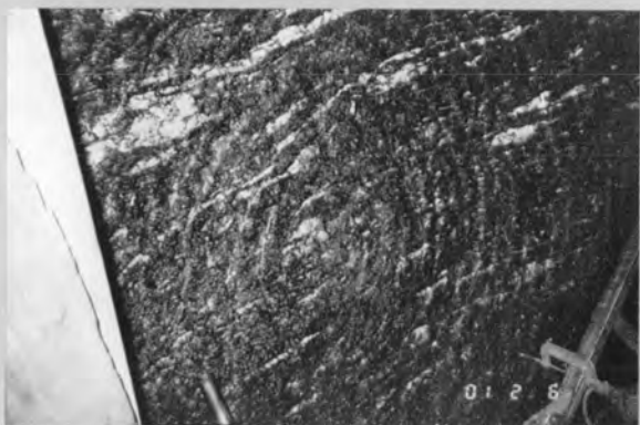
⇨TBM の切羽面
