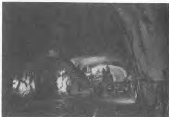
写真-2 B断面掘削
