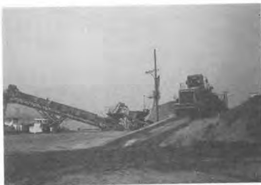
写真-2 港内で稼働中のホイールローダと移動式ベルトコンベヤ
