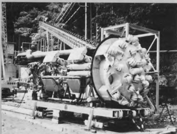
⇨TBM パイロット機本体
