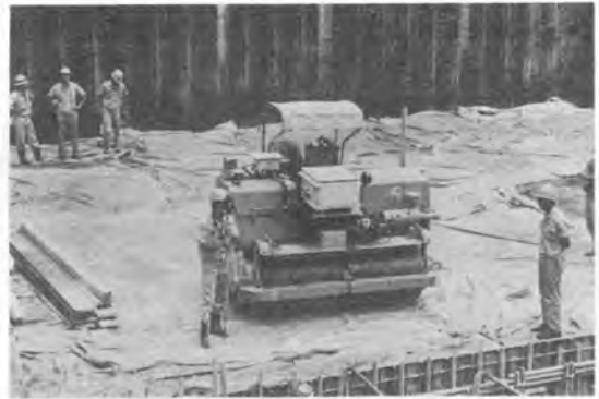
写真-6 総合試験状況（作業エリア設定）
