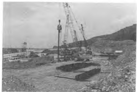
写真-6 鋼矢板打設状況
