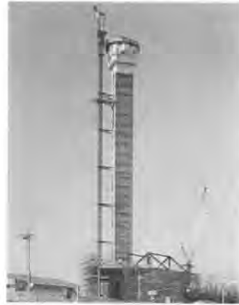
写真-1 施工中の TTS 工法
