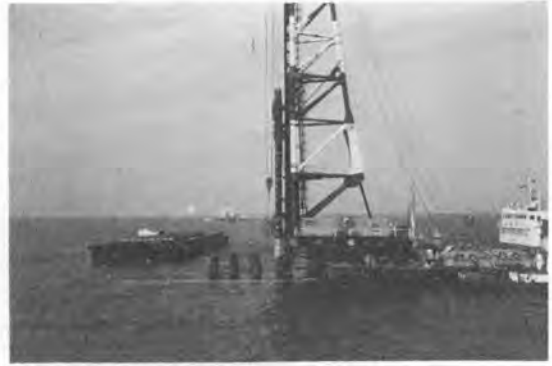
写真-3 一般杭打設状況
