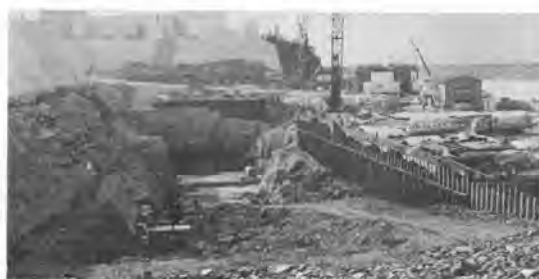
写真-7 締切工全景
