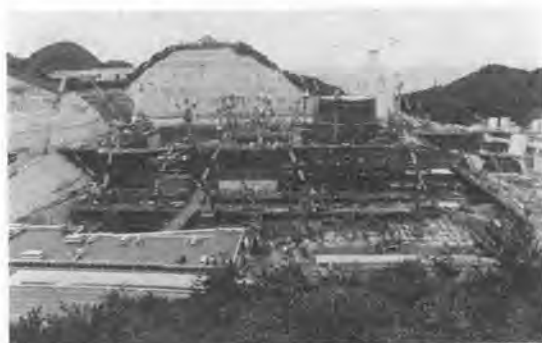
写真-1 冷却を行った原子炉格納容器
