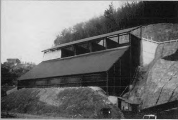
⇨ 骨材貯蔵設備
