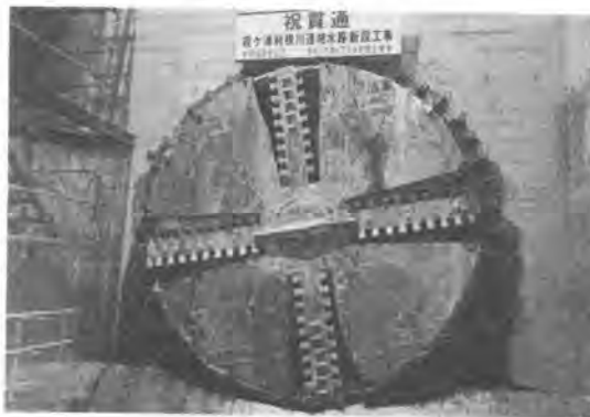
写真-2 シールド機貫通
