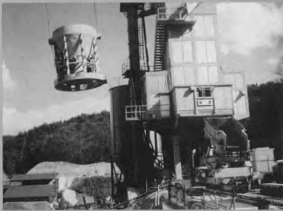
◆ ◆ 3 m 3 コンクリートバケット による打設状況
