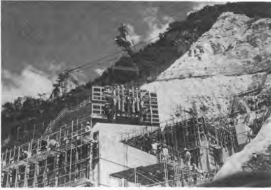
写真-2 型枠の据付け
