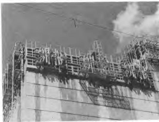
写真-1 安全作業台 (中央)
