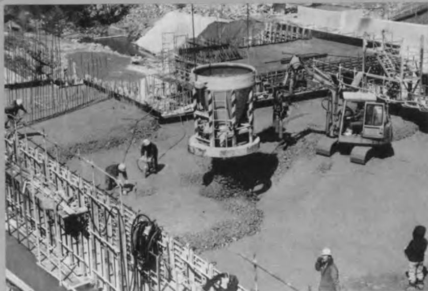
◆ ◆ 3 m 3 コンクリートバケット による打設状況
