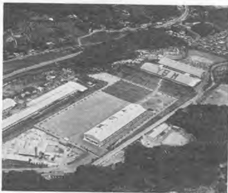
岸山工場全景
