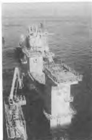
写真-1 橋梁基礎施工状況
