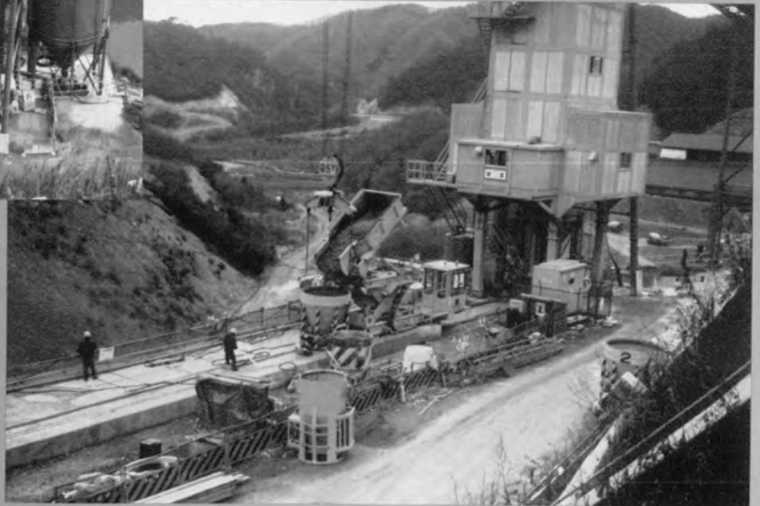
⇨ ダンプ式トランスファーカーによる骨材運搬
