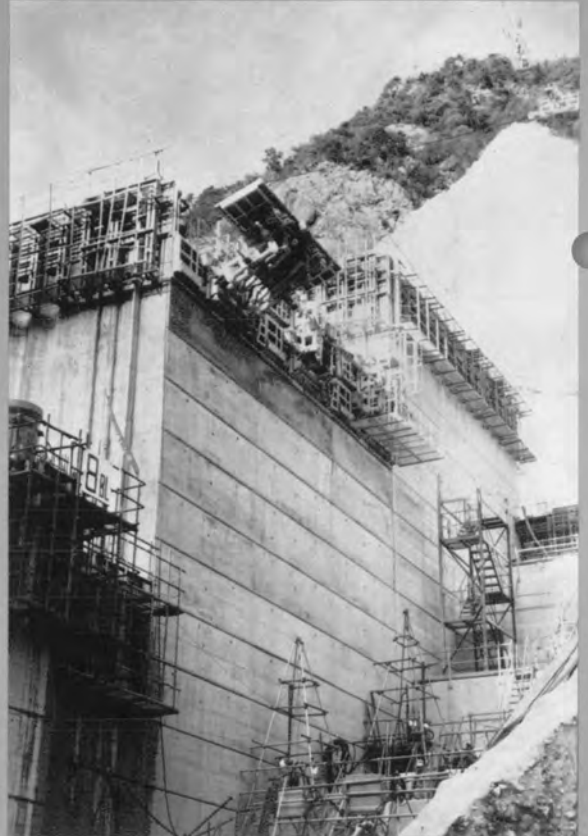
自動上昇型枠回転状況⇨
