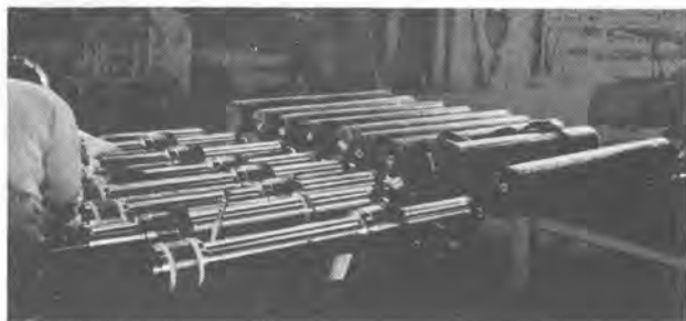
▲シールドジャッキの整備工場
