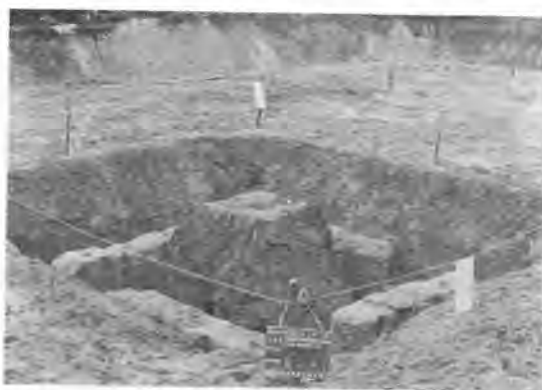
写真-1 No. 3 試験掘削完了状況
