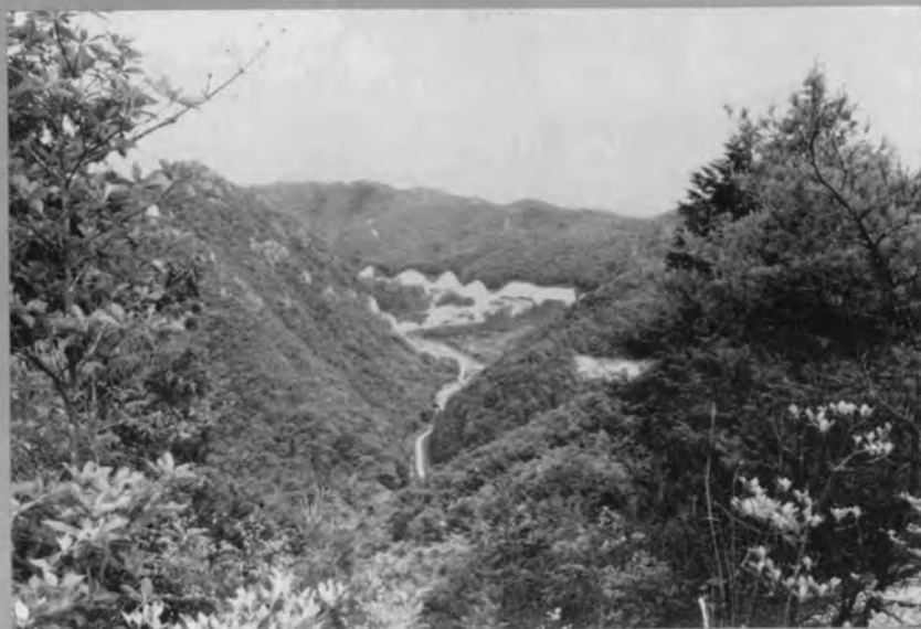
工事着手前の現場全景⇨ (下流より望む)
