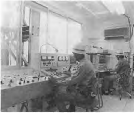
写真-2 運転管理室状況
