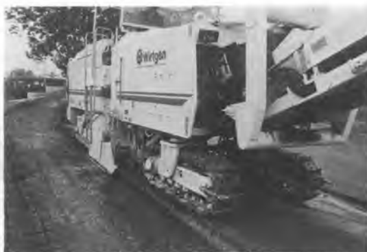
写真-3 一度に 30 cm のアスファルトコンクリートを切削作業中の 2100 VC
