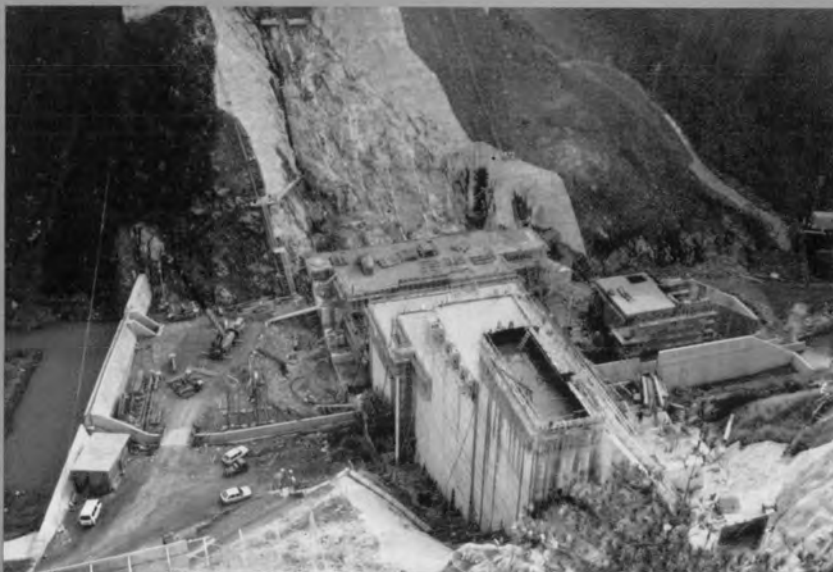
⇨型枠据付状況全景
