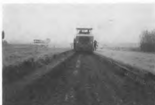
写真-2 アスファルト舗装を切削除去後、路盤のグレーディング作業中の 2100 VC
