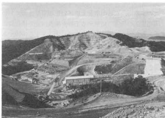
写真-1 本工事準備工 (仮設道路)
