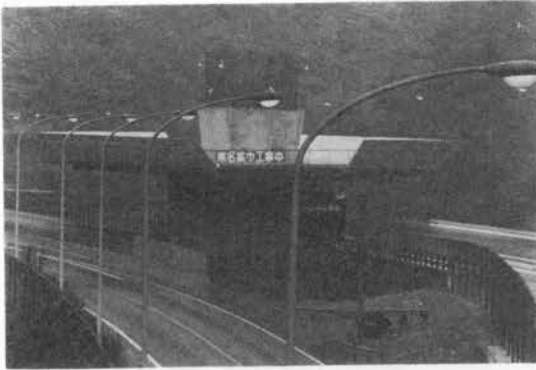
写真—1 柱頭部施工時の防護工全影（支保工兼用）
