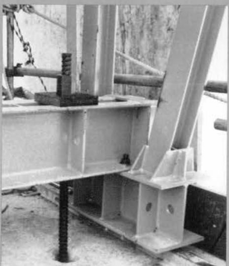
⇨PC ネジコンによる主桁への固定
