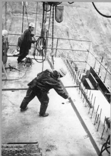
⇨テルハ、支保工桁移動のためのレール敷設
