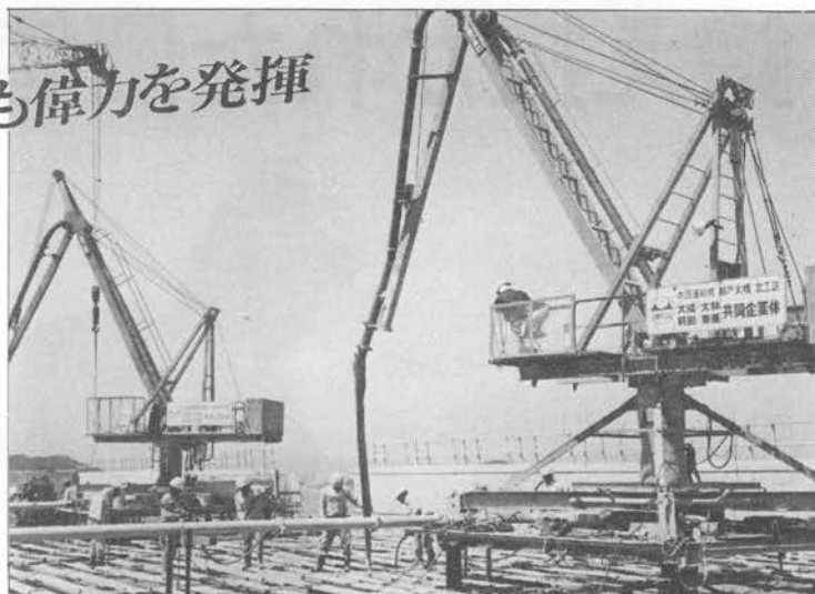
(本四架橋現場設置例)
