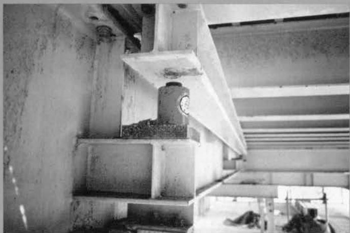
⇨型枠の高さ調整のためのジャッキと構造
