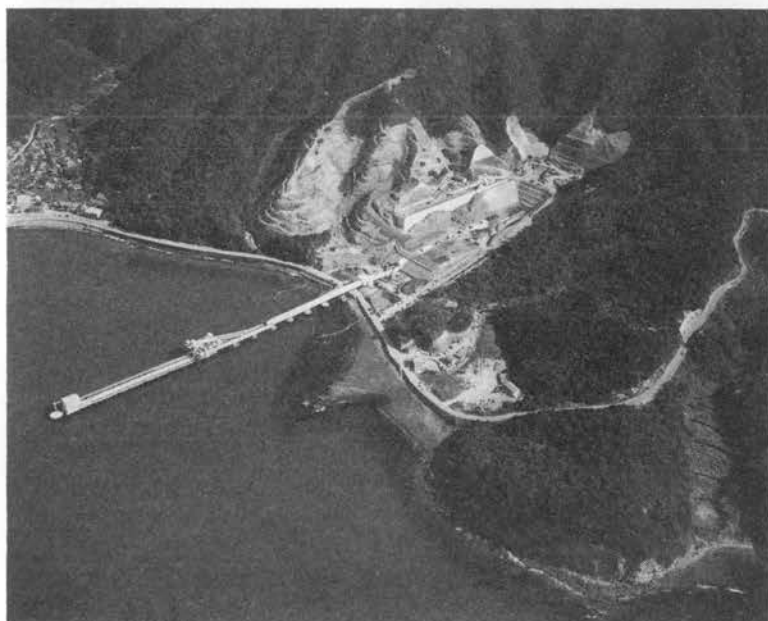
写真-2 ストックパイル施設と積出栈橋
