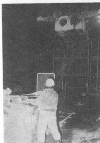
写真-4 ワイヤソーイングマシンによる鉛直材切断
