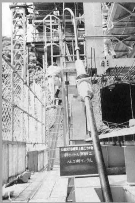
⇨ 斜材の架設（カップラを介して支保工桁と連結する）
