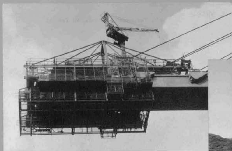
⇨ SLT工法用トラベラ側面 テルハ上に簡易クレーン（C-10）を装備
