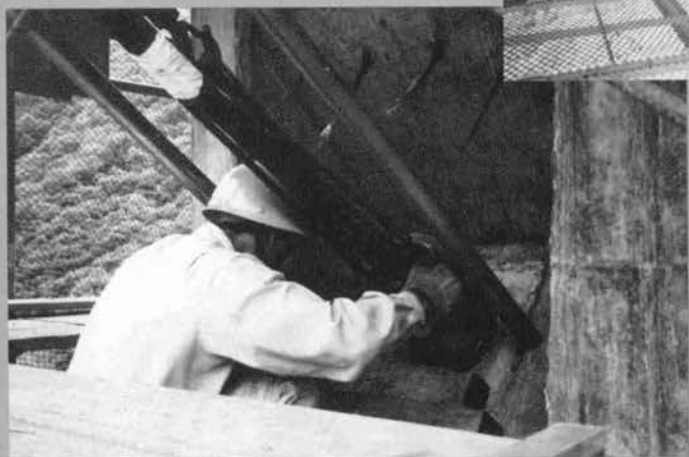
⇨ ウインチによる斜材の主塔側引込み架設
