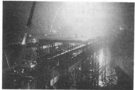
写真一 上部工鉄骨（屋根部材）架設状況
