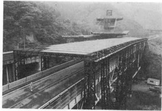
写真-2 本線防護工の全形
