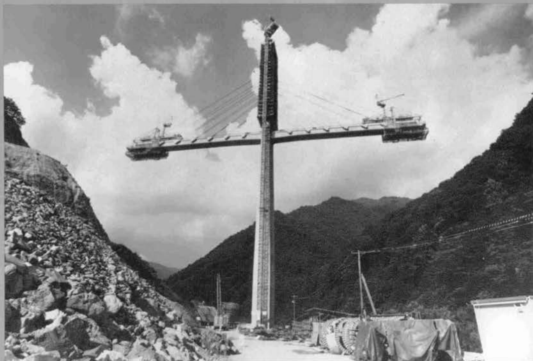
⇨ カンチレバー施工中の日中大橋
