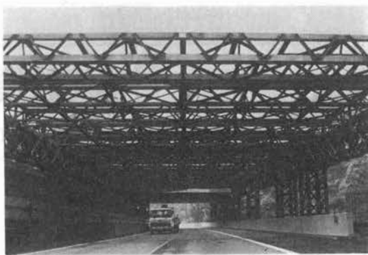
写真-4 本線防護工完成状況
