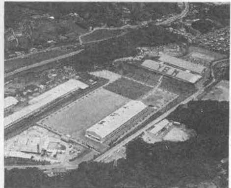
岸山工場全景
