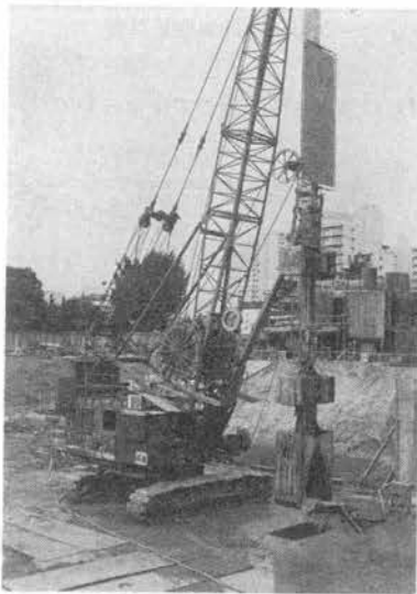
写真-5 OWS 拡底掘削機
