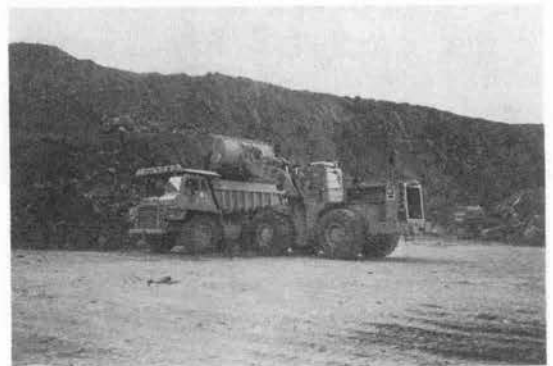
写真—1 ロック材積込み状況
