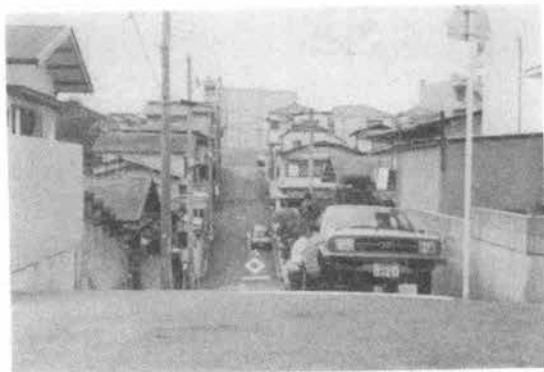
写真-1 150 m 付近より見た発進基地
