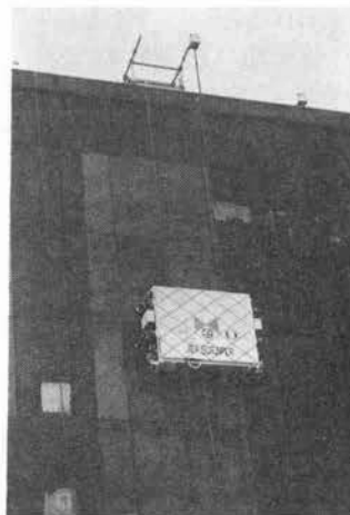
写真-51 外壁塗膜剥離ロボット
