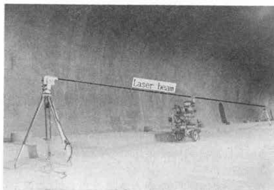
写真-3 ユニット台車システムによる測定状況
