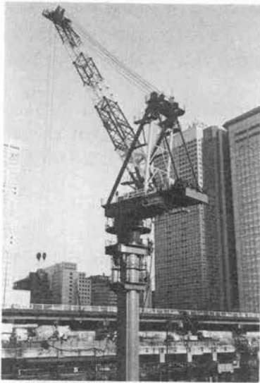
写真-3 クライミングクレーン
