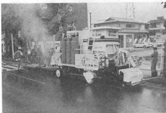
写真—38 ミニリミキサ施工状況
