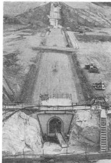
写真-4 監査廊の施工
