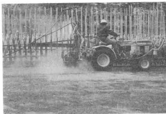
写真-24 レイタンスリムバによるレイタンス除去作業
