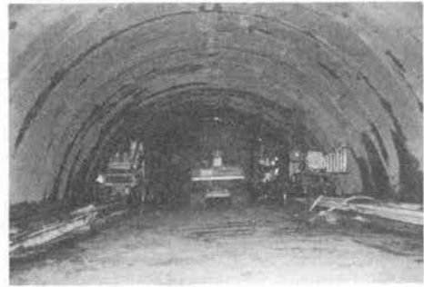
写真-1 試験施工における1次覆工
