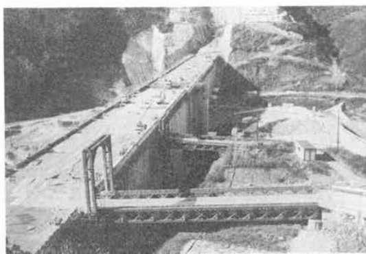
写真-25 リフトアップ栈橋
