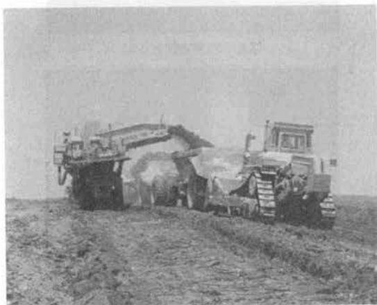
写真-1 ベルトローダによる積込状況
