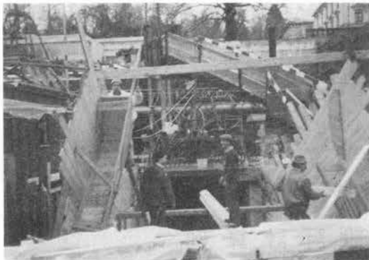
写真-4 駅舎への入口
