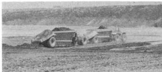
写真-2 連結型の大型土石運搬車
