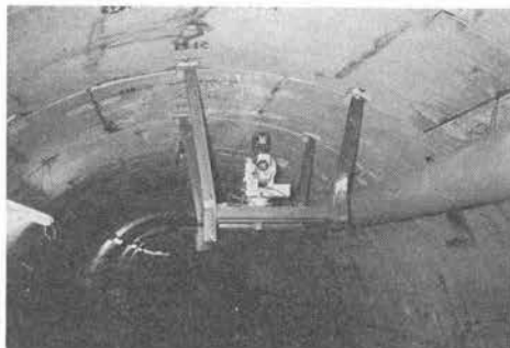
写真-10 発光部の据付状況
