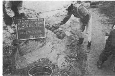
写真-3 スラリー処理・コンタクトクレイ施工状況
