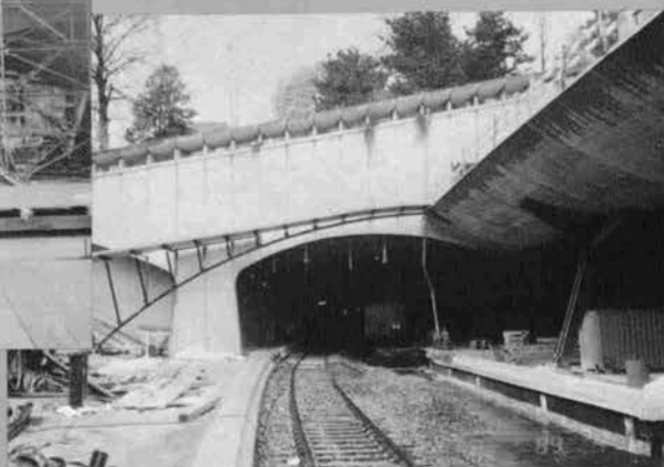
◆地下鉄の状況
