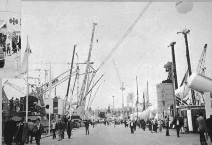
♡各社のクレーン
