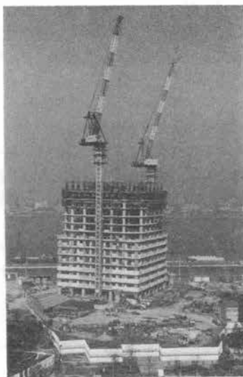
写真-4 タワークレーン
