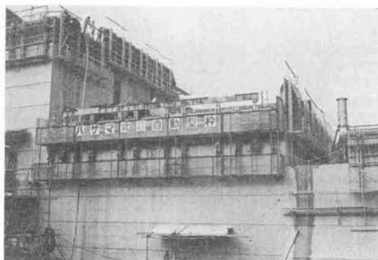
写真-31 ダム用自動型枠
