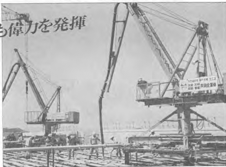
(本四架橋現場設置例)
