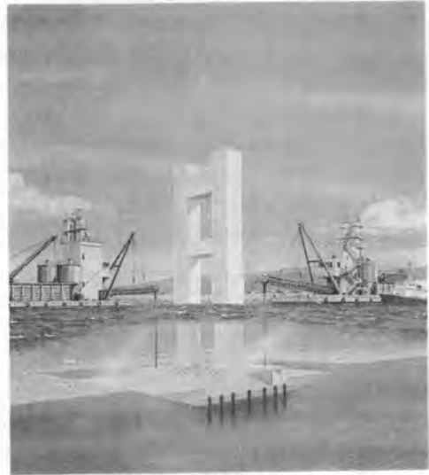
図-15 プーティングコンクリート打設
