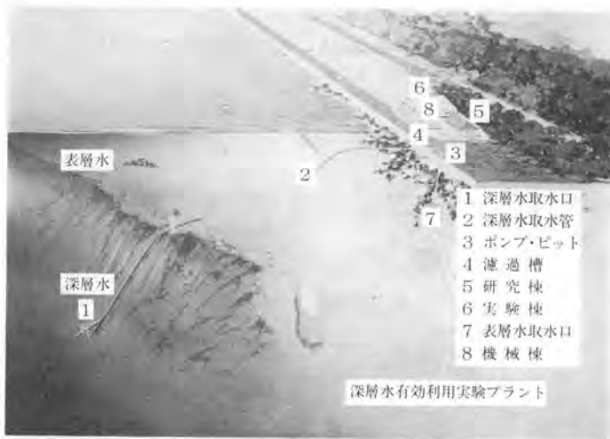
写真-2 深層水有効利用実験プラント
