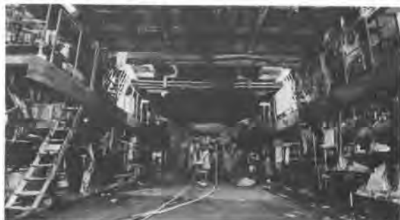
●マイペース急速施工で貫通間近～関越トンネル2期、水上
