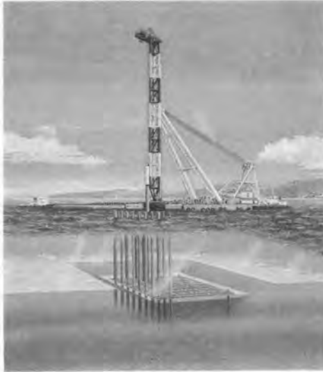
図-14 鋼管杭打設
