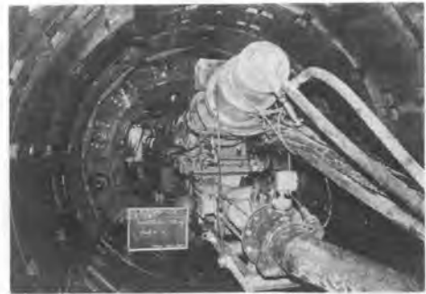
写真-2 スクリューコンベヤと一軸スクリーポンプ
