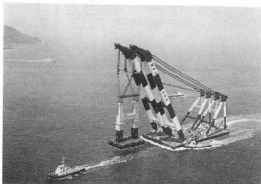
写真-2 鋼製橋脚運搬
