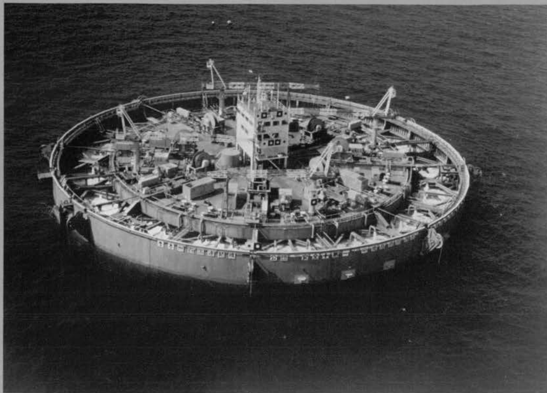
◆着底後の鋼ケーソン
