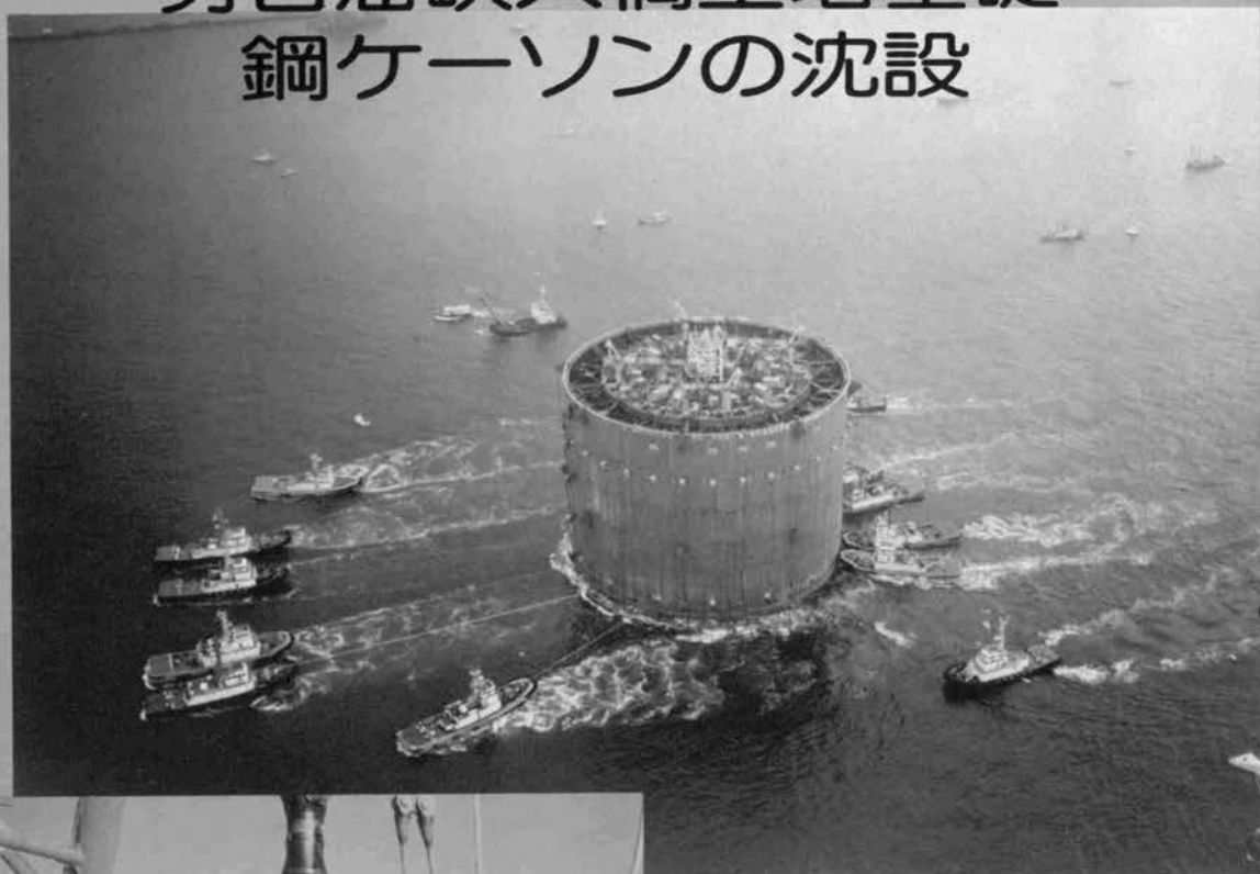
◆鋼ケーソンの曳航
