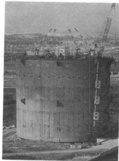
写真-2 艀装架台搭載後の鋼ケーソン (2P)
