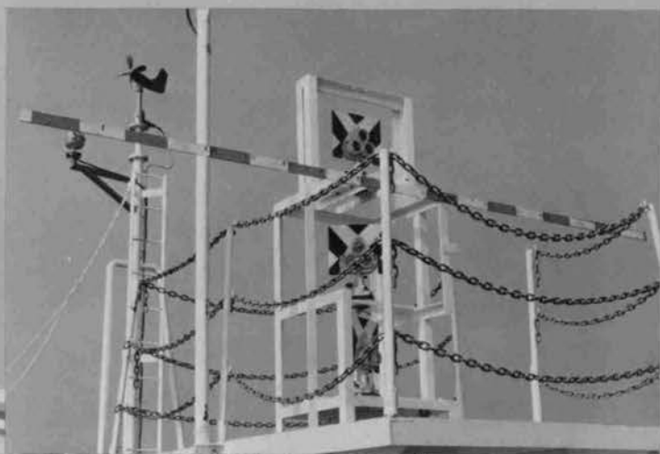
監視室屋上の測量用反射プリズム⇨
