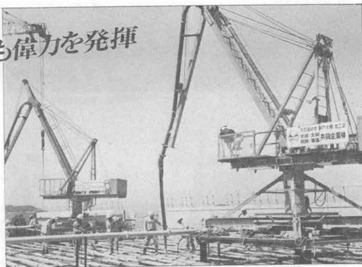
(本四架橋現場設置例)
