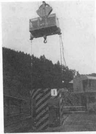
写真-3 自動給気・遠隔開閉システム
