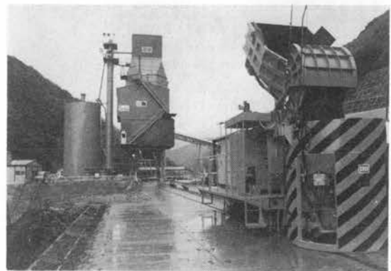
写真-2 無人運転状況
