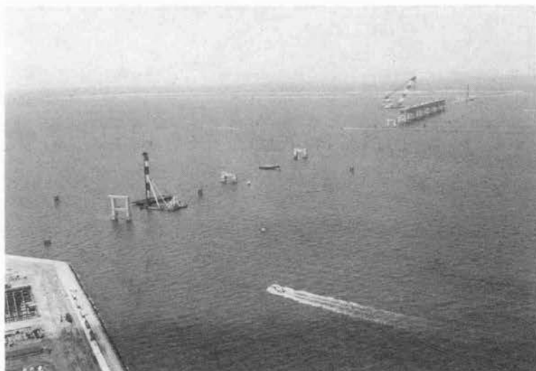
写真-5 工事海域全景（前島側より空港島側を望む）
