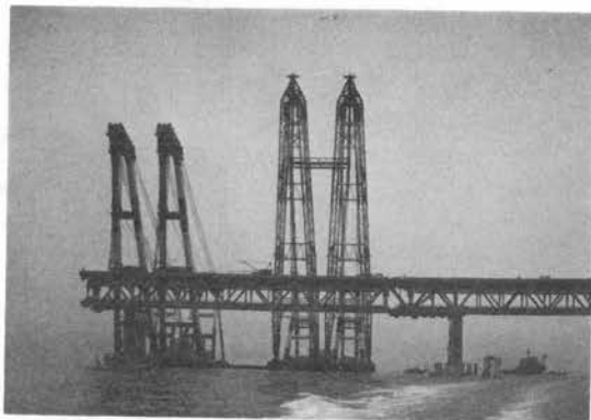
写真-4 上部工架設
