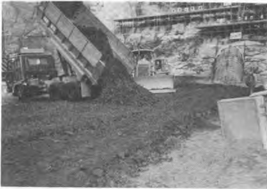
写真-4 ダンプ敷ならし状況
