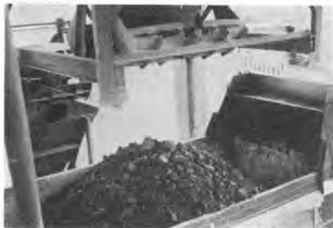
写真-2 バッチャプラントでのダンプ積込
