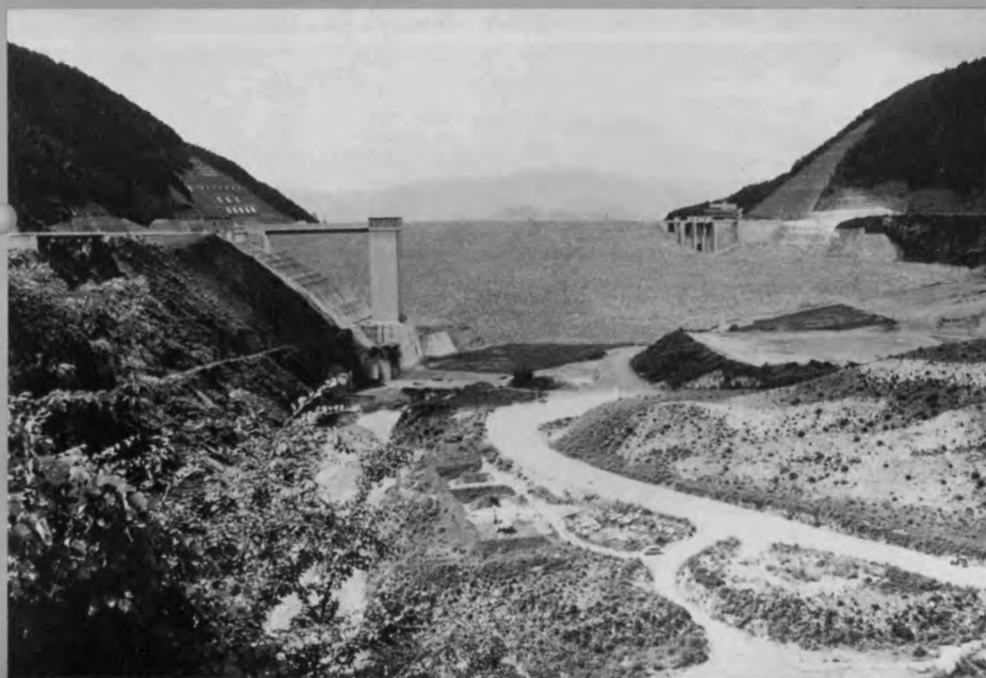
◆堤体完成（上流より）
