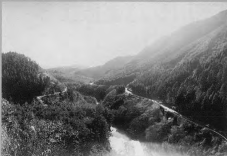
⇨ 工事前の現場（下流より）
