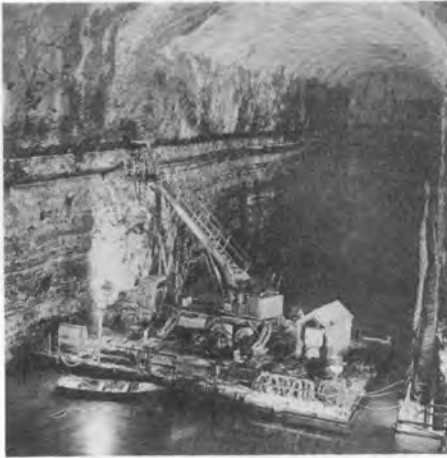
写真-1 改修工専用浮足場
