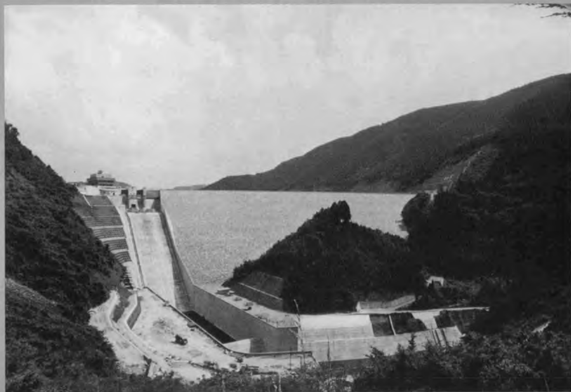
◆堤体完成（下流より）
