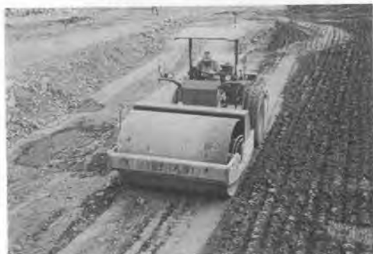
写真-6 振動ローラによるフィルタ部締め
