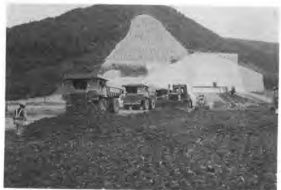
写真-4 コア材運搬・搬出し
