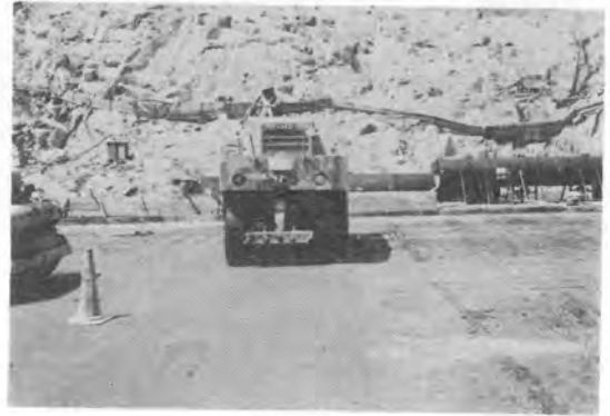
写真-8 タイヤローラによる締固め
