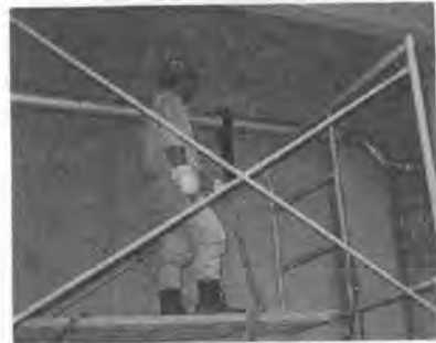
写真-8 建築プラントの現地自動溶接
