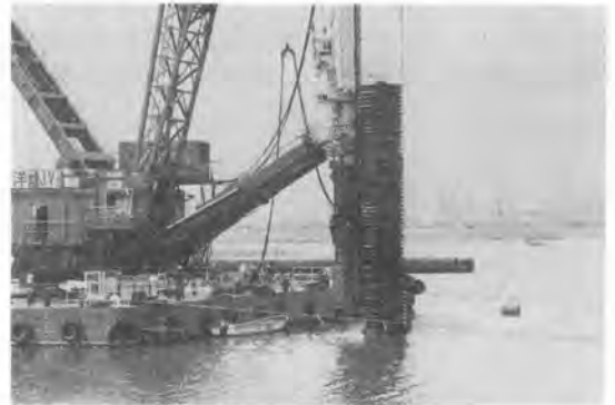
写真-5 油圧ハンマによる打設状況
