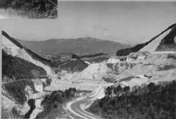
⇨ 施工中の現場（上流より）
