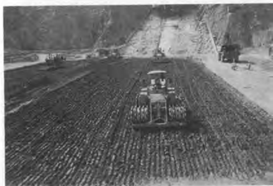
写真-7 タンピングローラによるコア部締め
