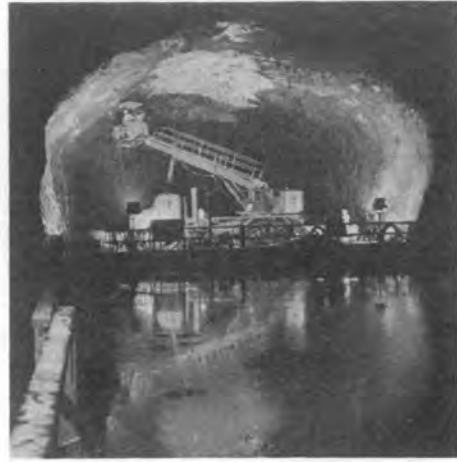
写真-2 浮足場上の高所作業車
