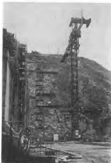
写真-3 減勢部施工の水平タワークレーン
