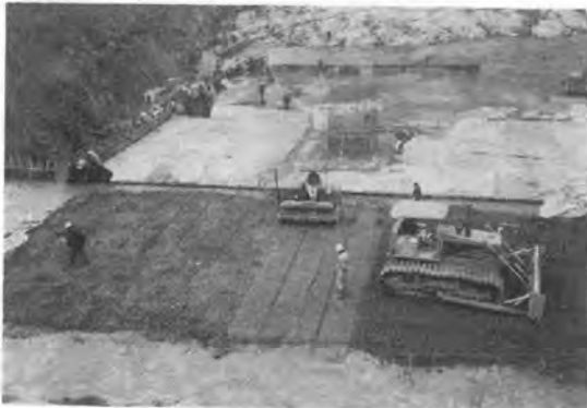
写真-5 敷ならしおよび締固め
