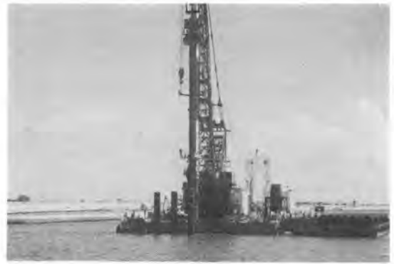
写真-4 振動パイルドライバによる打設状況
