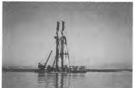
写真-2 地盤改良施工状況
