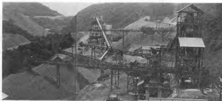
写真-2 骨材・バッチャプラント
