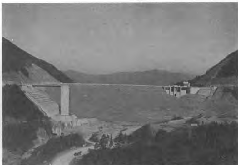
写真-1 盛立完了のダムを上流より見る
