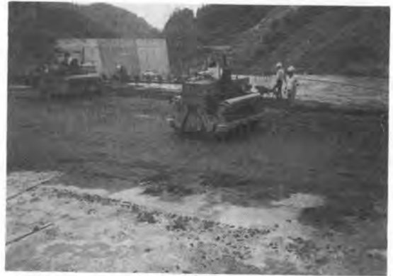
写真-7 振動ローラによる締固め
