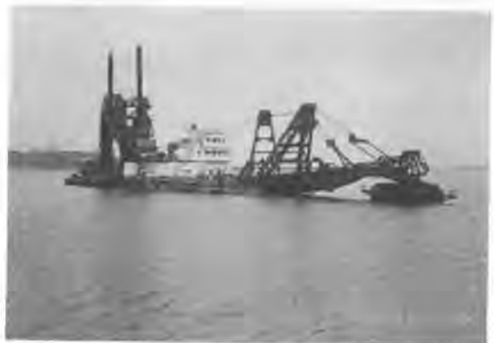
写真-1 薄層覆砂専用船「マリンスノー1号」
