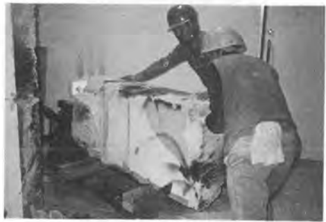
写真—10 切断ブロック搬出状況
