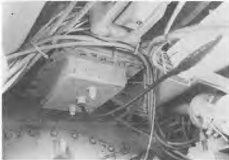
写真-3 アンテナ格納箱の状況
