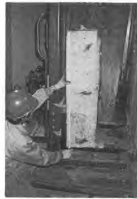
写真—9 切断ブロック取出し
