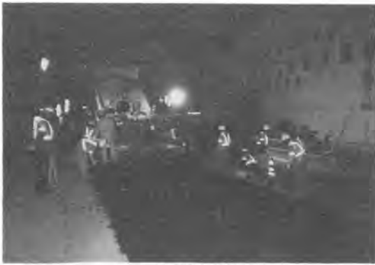
写真-5 現場の試験状況
