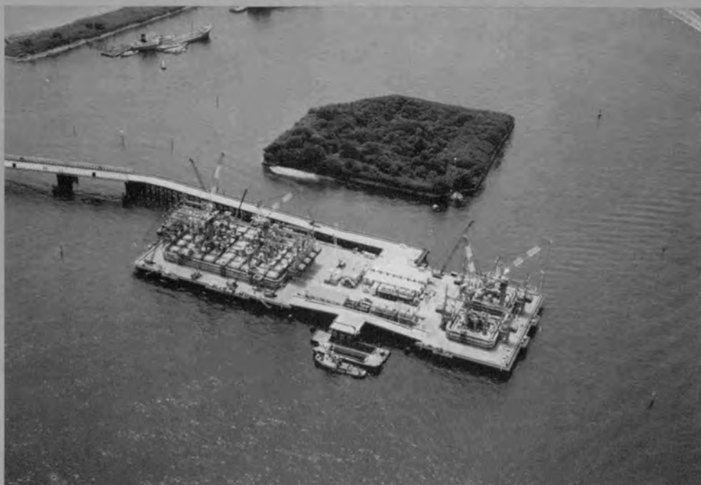
⌘ アンカーレイジおよび主塔ケーソンの構築全景
