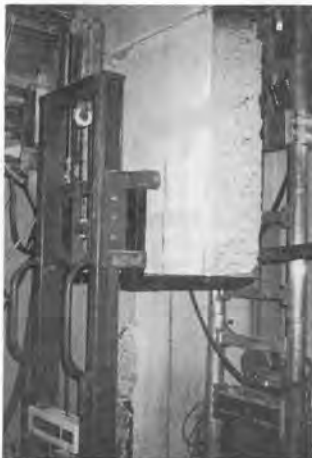
写真—8 簡易リフトセット状況
