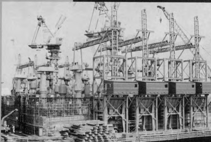
⇨ ケーソンの掘削設備など
