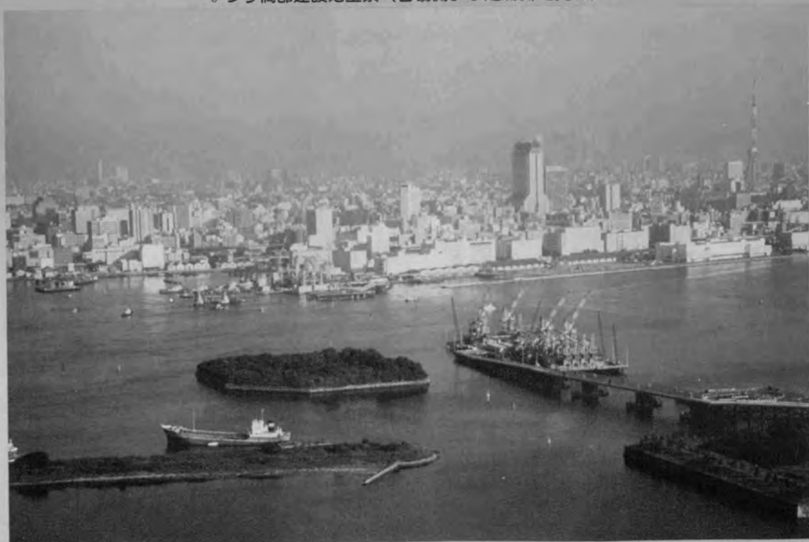
◆つり橋部建設地全景（台場側より芝浦側を見る）
