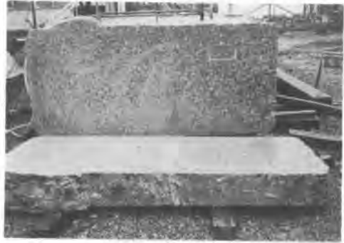
写真-2 切断状況
