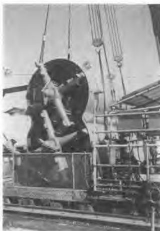
写真-1 縦二連型 DOT シールド機
