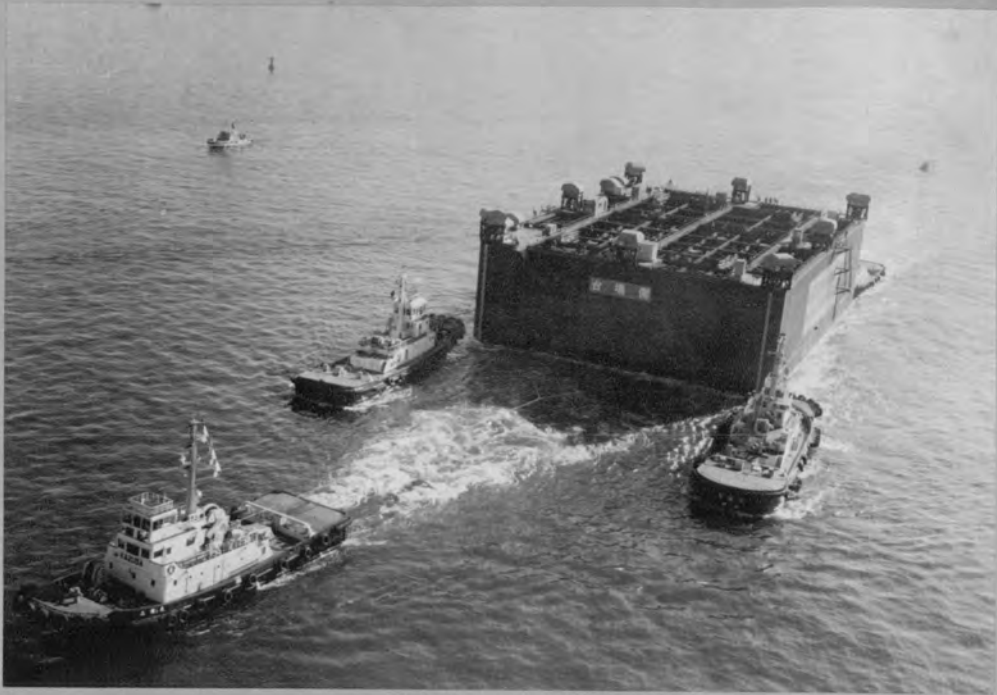
⇨ 鋼殻ケーソン曳航
