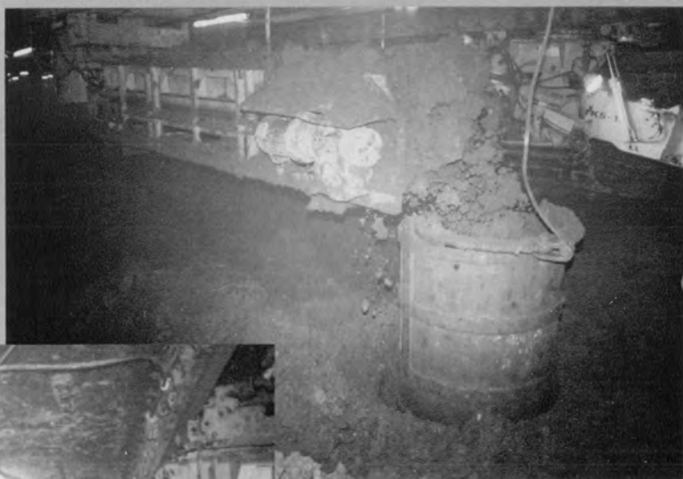
⌘バケットへの積み込み
