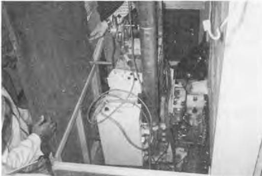
写真—7 廊下側防音対策
