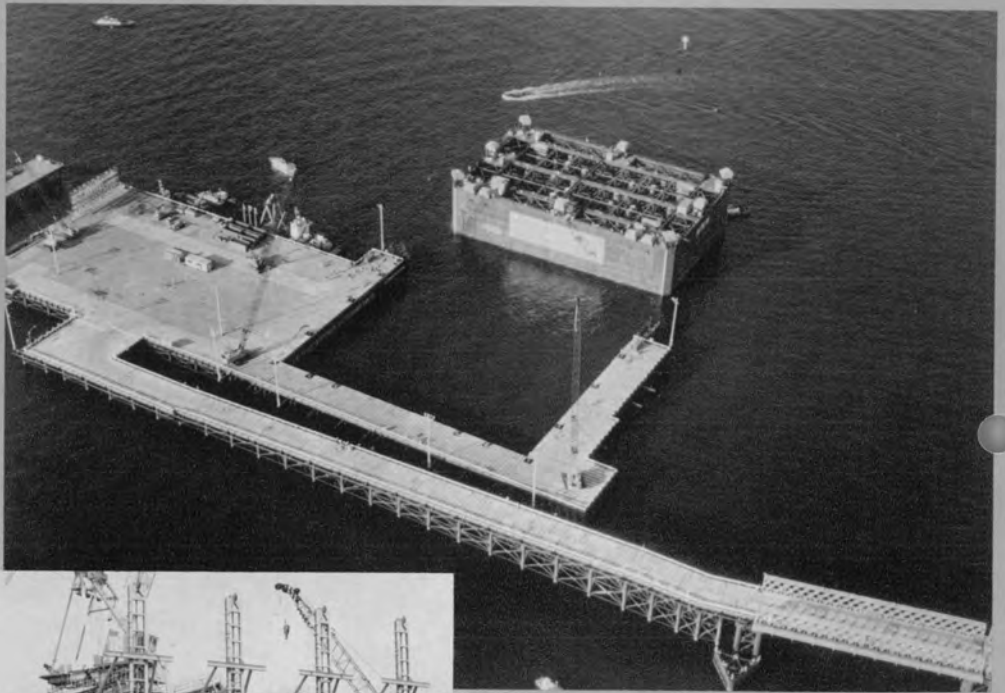
⇨ 鋼殻ケーソン引込み
