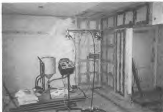
写真-1 間仕切り壁切断状況
