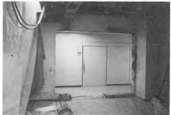
写真—11 切断撤去後の状況
