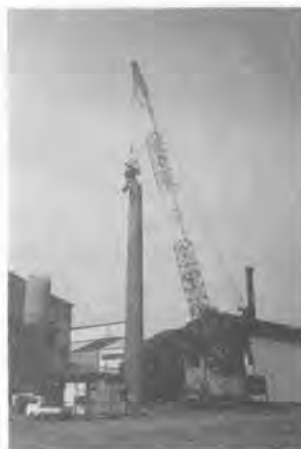
写真-1 施工状況
