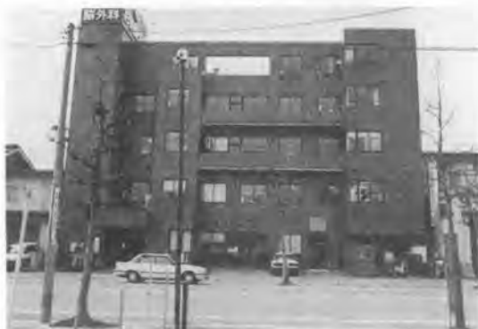
写真-1 建物外観
