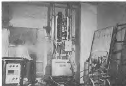
写真-6 切断状況
