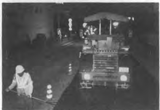
写真-4 現場の試験状況
