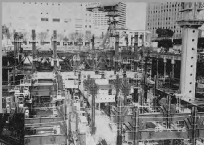
◆ 地下躯体施工状況 (1988年12月)
