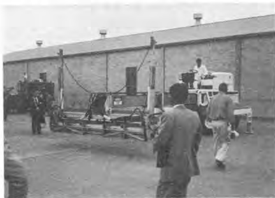
写真-4 コンクリート仕上げロボット
