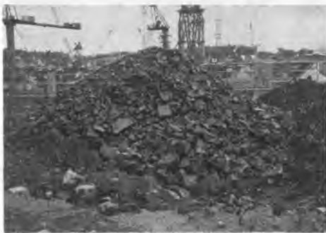
写真-5 搬出中の発破ずり
