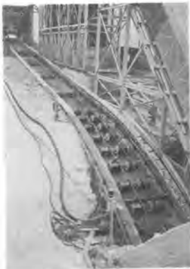
写真-6 インクライン・レール屈曲部
