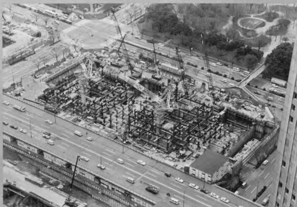
◆ 地下躯体施工全景 (1989年1月)
