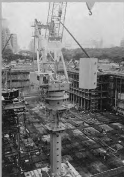
◆ 1号タワークレーン組立 (1988年9月)
