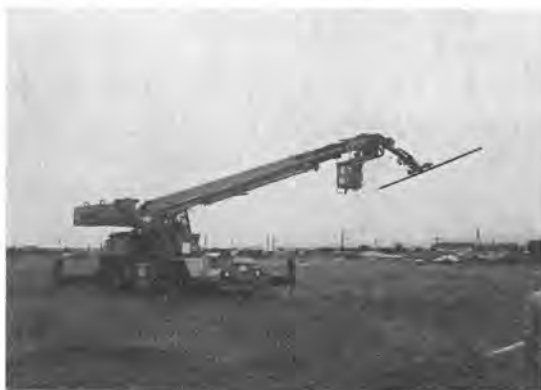
写真-2 パイプマニピュレータシステム (作業機)
