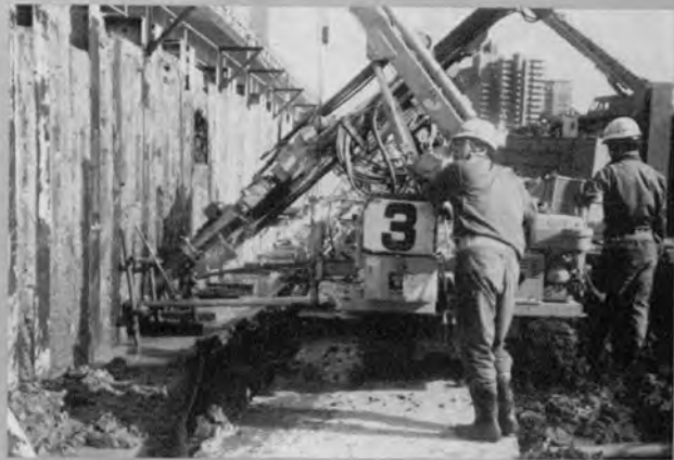
第1段目アースアンカー施工状況 (1988年5月)
