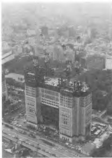
写真-3 19階建方中の JCC-900 H
