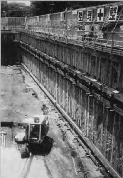
山留材取付状況 (1988年6月)
