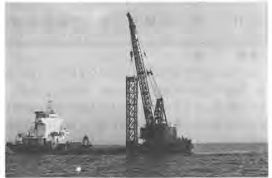
写真-1 施工状況
