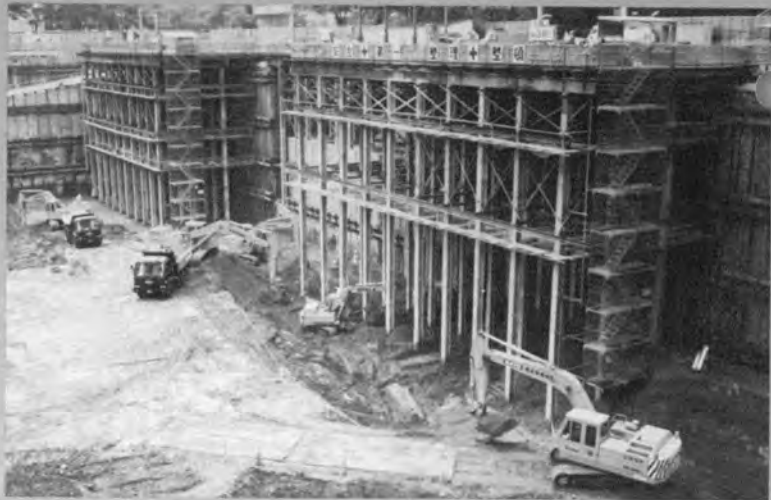
第4次掘削工事施工状況 (1988年8月)
