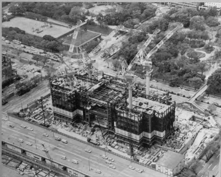
5階建方完了・積層工事 ♡ 準備全景 (1989年4月)
