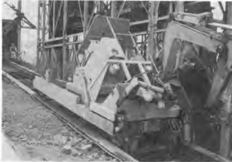
写真-9 共通台車上のバックホウ
