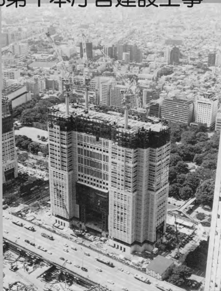
22階建方完了 (1989年9月)
