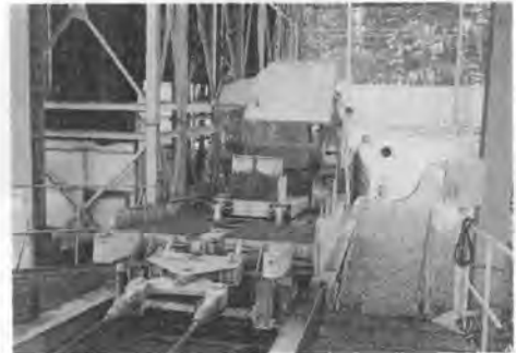
写真-7 共通台車のけん引部(台車上にバックホウ搭載)
