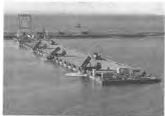
写真-1 施工状況
