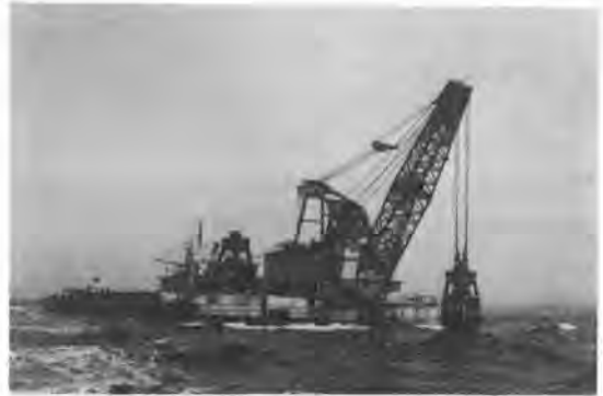
写真-1 大型グラブ船による掘削状況
