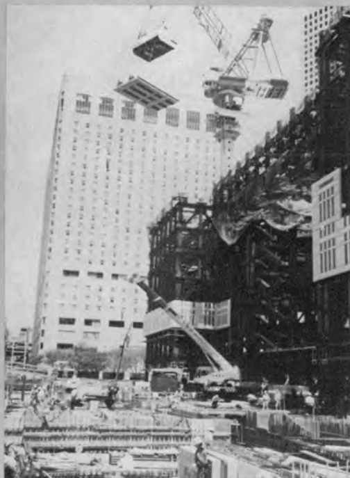
♡ 外壁PC板取付状況 (1989年4月)
