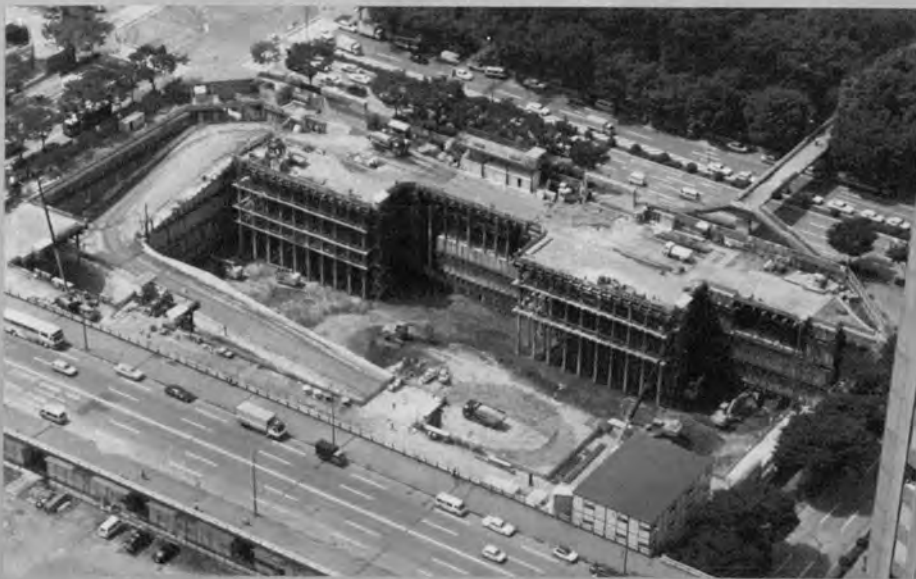
第4次掘削全景 (1988年8月)
