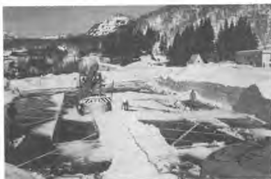
写真-3 投雪パターン制御実験状況
