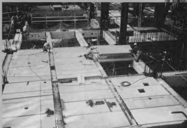
◆ 地下1階スパンクリート敷込み状況 (1989年1月)
