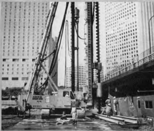
山留壁施工状況 (1988年4月)
