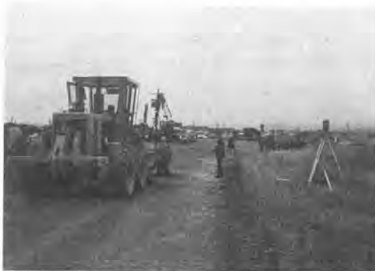
写真-1 レーザービームブレード制御モータグレーダ
