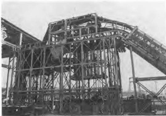
写真-3 インクラインド・コンベヤベルト収納部
