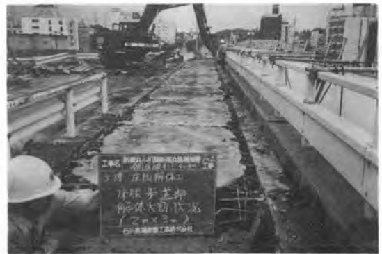
写真—3 鋼床版部床版解体
