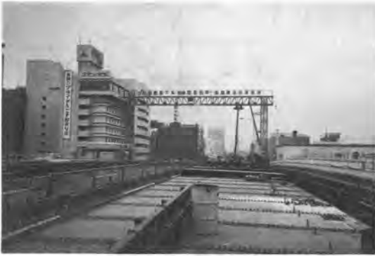
写真-5 鋼床版 2 期工事
