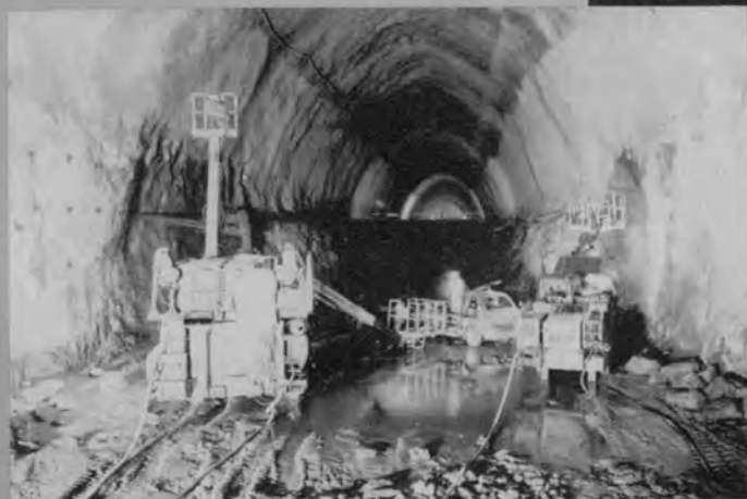
◆ 2nd ベンチ掘削状況
