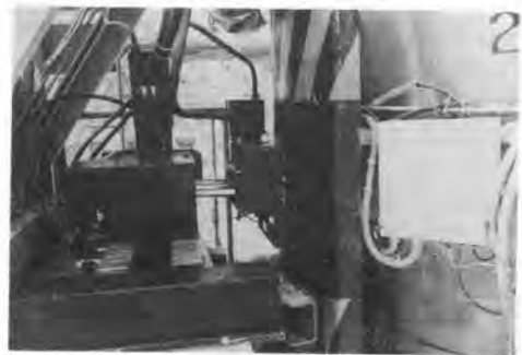
写真-5 エア供給状況
