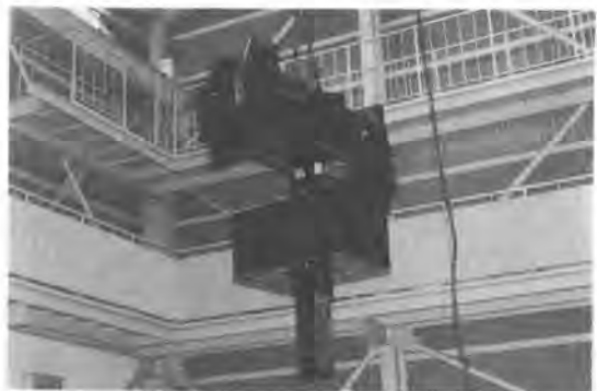
写真-6 TMD 外観
