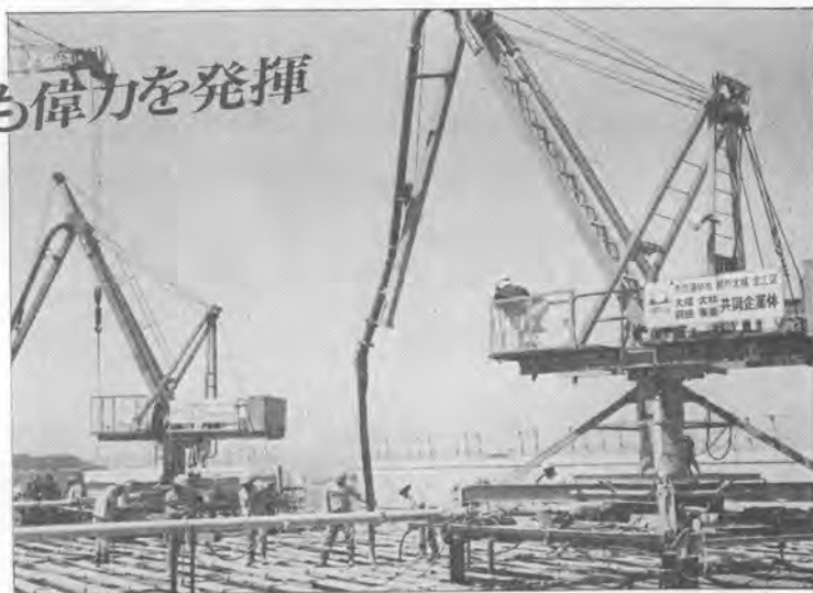
(本四架橋現場設置例)
