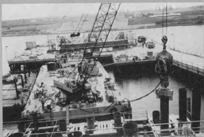
♡ クレーン台船による施工状況
