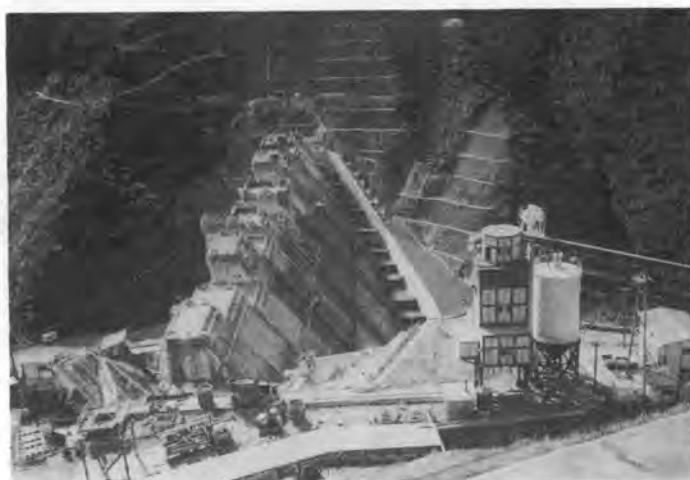
写真-1 箕輪ダム全景
