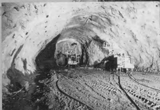
◆ アーチ部掘削状況
