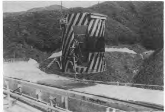
写真-6 バケットの位置決め装置
