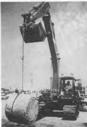
写真-6 バックホウによるつり上げ
