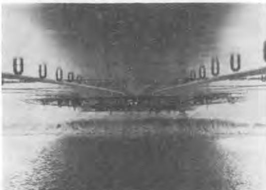
写真—4 移動足場設置・使用状況
