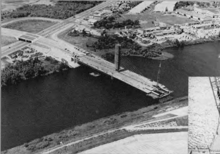
⇨ 張出し架設状況
