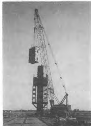
写真—5 塔の架設状況
