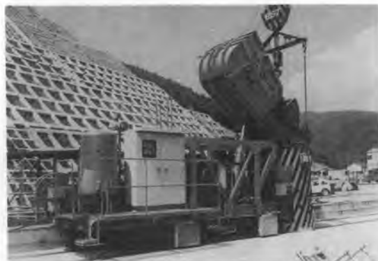
写真-2 トランスファーカー
