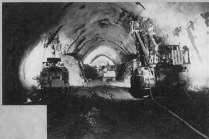
◆ 1st ベンチ掘削状況
