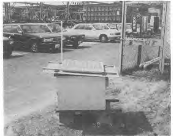
写真一 計測器設置状況
