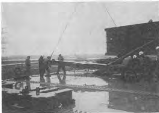
写真—3 クレーン・アウトリガ反力受架台据付状況
