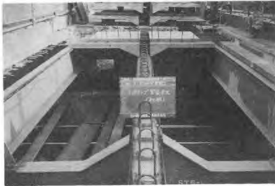
写真—2 コンポスラブ架設
