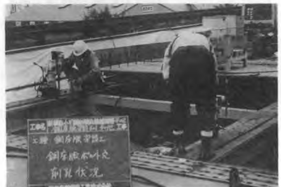
写真—4 鋼床版既設上フランジ削孔
