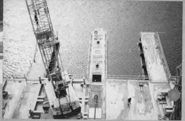
⇨ 張出し架設状況
