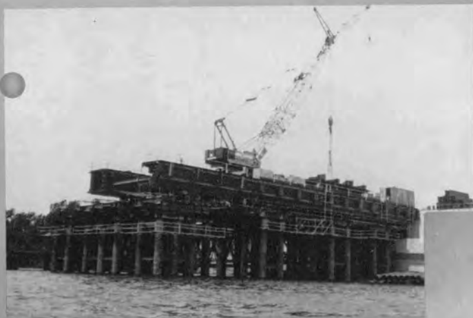
⇨ 側径間のトラッククレーンベント架設
