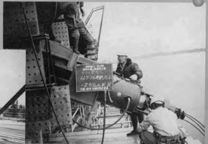
⇨ ケーブルの引込み状況
