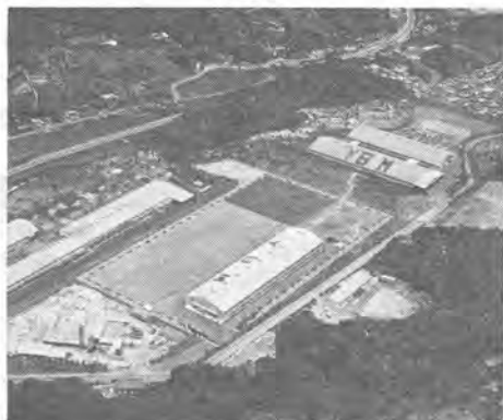
岸山工場全景
