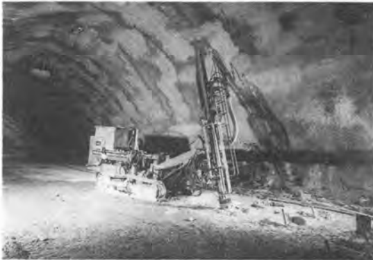
写真—2 油圧クローラドリル (ベンチ部大背掘削用)
