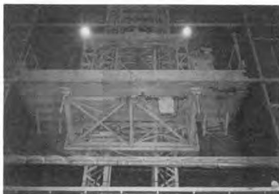
写真-15 高層リフト
