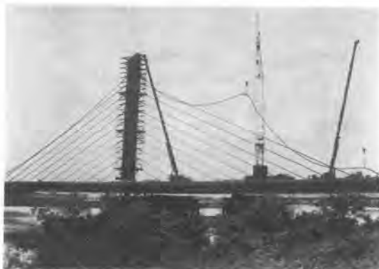
写真-1 ケーブル架設状況
