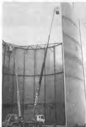
写真-7 愛知・小松 SK-200 ほか高所作業車
