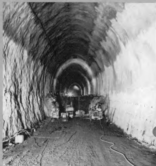
⇨ 3rd ベンチ掘削状況
