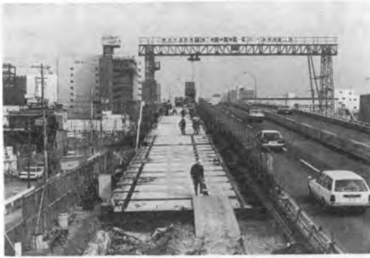
写真—1 コンポスラブ1期工事 (小田原側)
