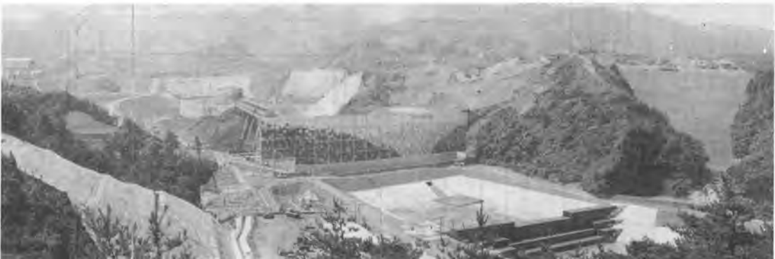
写真-3 防音壁（H=23 m, L=121 m）手前は沈砂池、調整池
