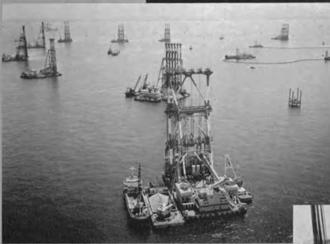
⇨地盤改良船による施工状況
