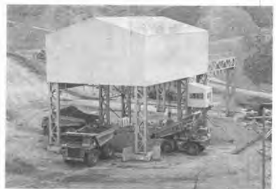
写真-1 土砂投入口(80tダンプ投入中)
