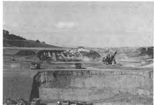
写真-7 起砕状況
