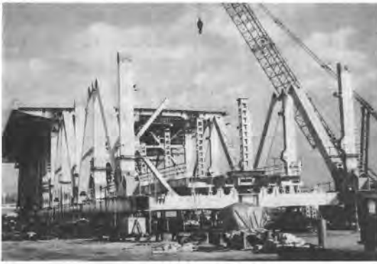
写真-4 トラス橋大組立
