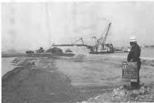
写真-1 揚土船（埋立工）
