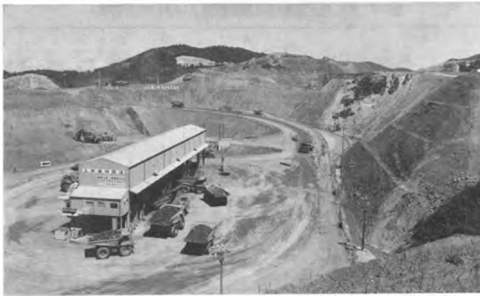
写真-5 運搬状況
