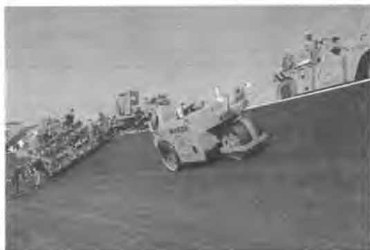
写真-1 テストコース施工状況
