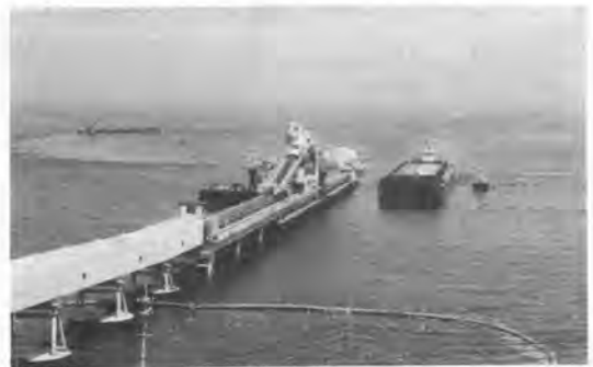
写真-2 積出状況
