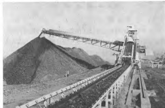
写真-9 搬送状況
