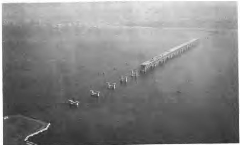
写真-5 工事海域全景(空港島側より前島側を望む)
