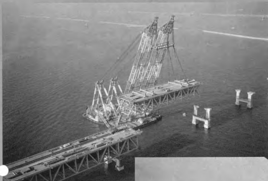
トラス橋架設
