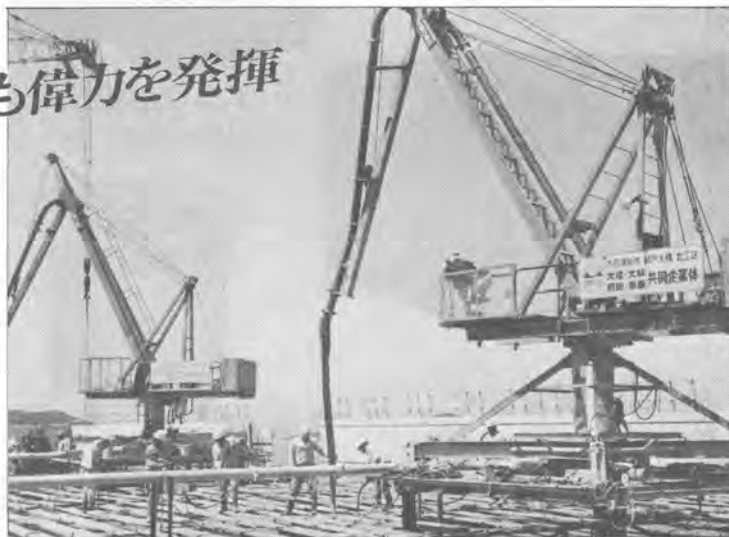
(本四架橋現場設置例)
