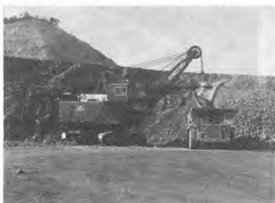
写真—4 積込状況
