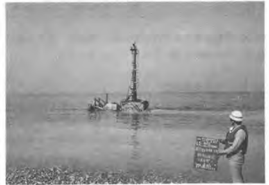
写真-3 水中ブルドーザ（緩傾斜護岸工）
