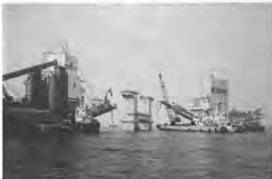
写真-3 フーチングコンクリート打設
