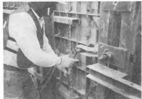
写真-9 抜き型枠のセット
