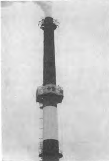
写真-4 円形ゴンドラの架設状況
