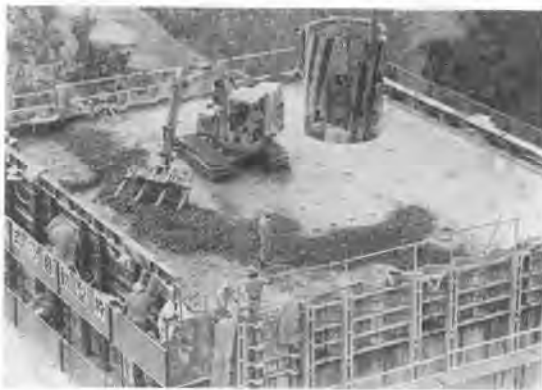
写真—10 コンクリートの打設状況
