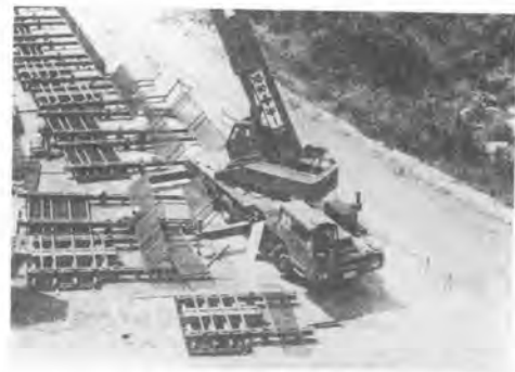
写真-2 型枠の組立て状況
