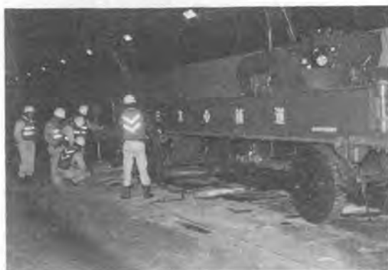
写真-2 施工状況
