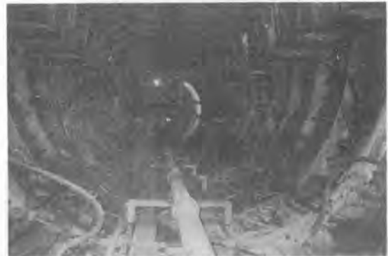
写真-2 2次覆工コンクリート打設状況
