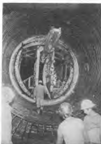
写真一 鉄筋区間での型枠移動状況
