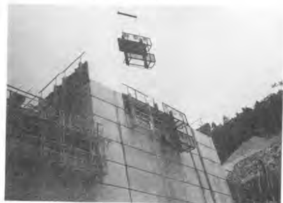
写真-3 型枠の据付け状況
