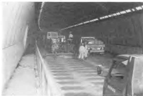
写真-1 施工状況
