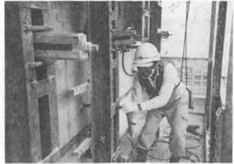
写真-8 ジャッキボルトのセット
