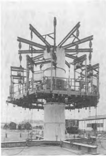
写真-3 円形ゴンドラ外観
