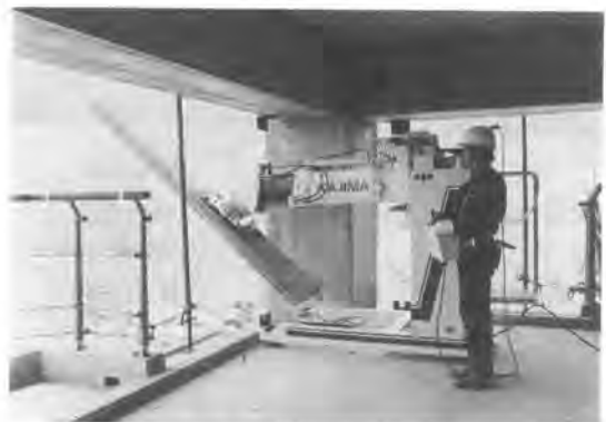
写真-1 PC 板（重量 430 kg、2.8×0.6×0.12 m）取付作業
