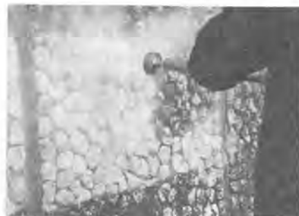
写真-2 大石寺での試験工事の状況
