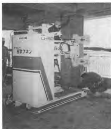
写真-3 軽量コンクリート板取付
