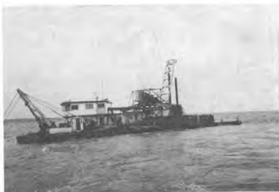
写真-4 浮島現場で作業中のポンプ船
