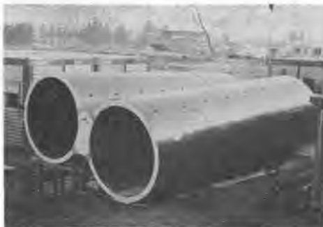
写真-2 仮組したスパイラルセグメント
