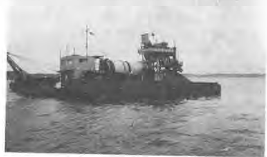
写真-1 出島現場で作業中のポンプ船
