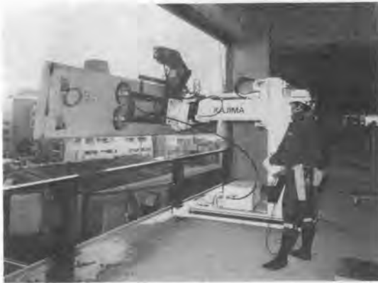
写真-2 押し成形セメント板取付
