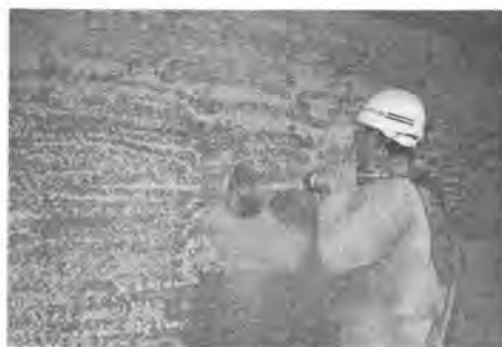
写真-1 ホリディン金沢での施工状況
