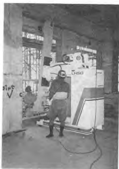
写真-5 コンクリート柱取付
