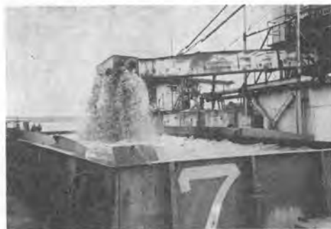
写真-5 スラリーで台船に積込まれる
