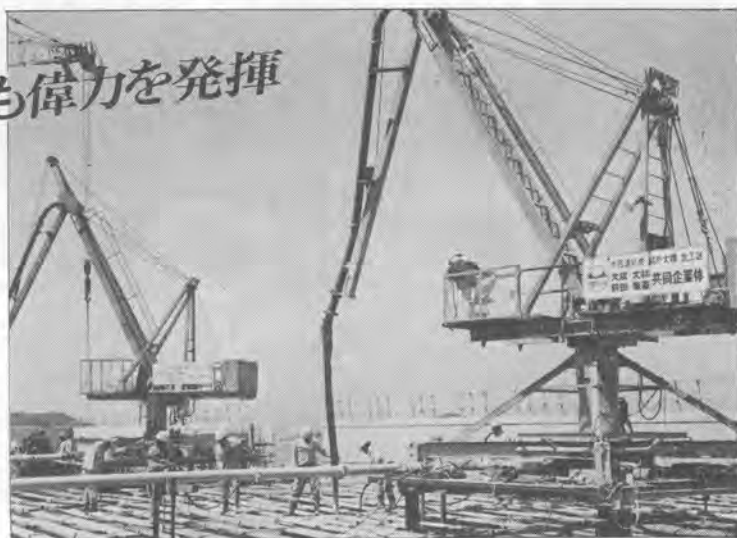
(本四架橋現場設置例)
