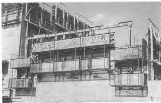
写真-4 型枠のスライド状況
