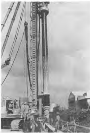
写真-1 先行削孔
