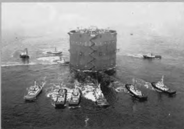
⇨ 3Pケーソン係留作業
