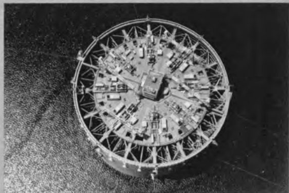
⇨ ケーソン構築架台上機器配置 (沈設用機器)
