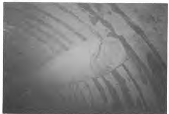
写真-4 風管の吐出し口
