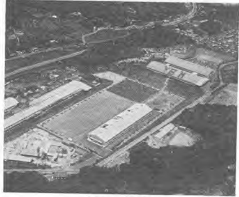
岸山工場全景
