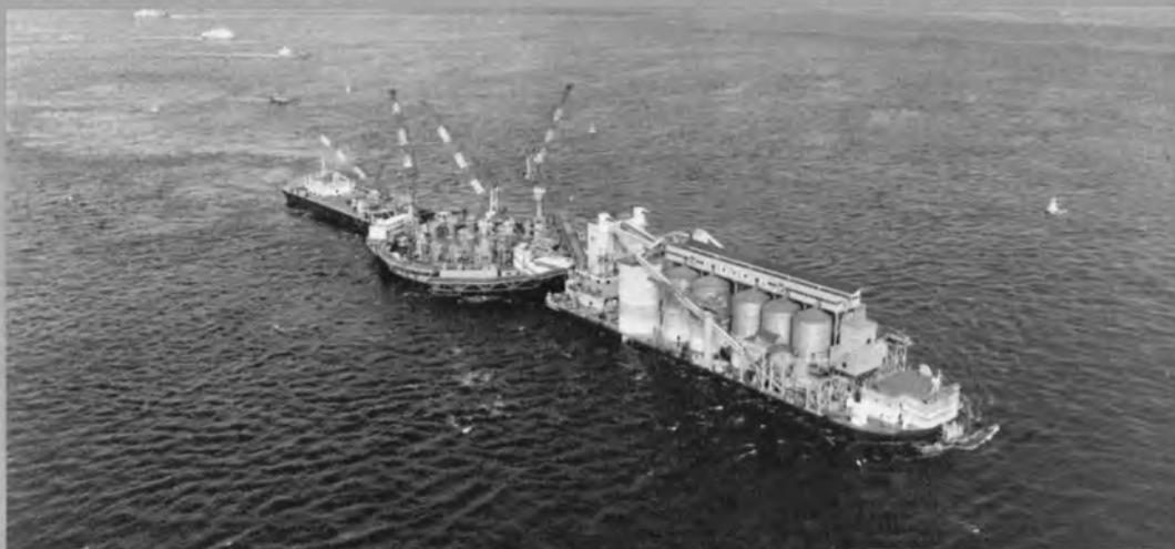
⇨ 資材台船・3Pケーソン・CP台船全景
