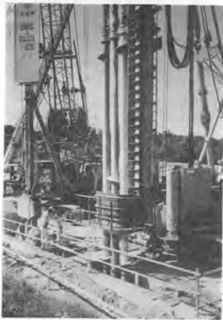
写真-2 三軸原位置攪拌工
