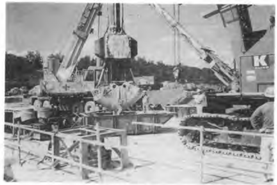
写真-3 残土処理(セメント混じり)
