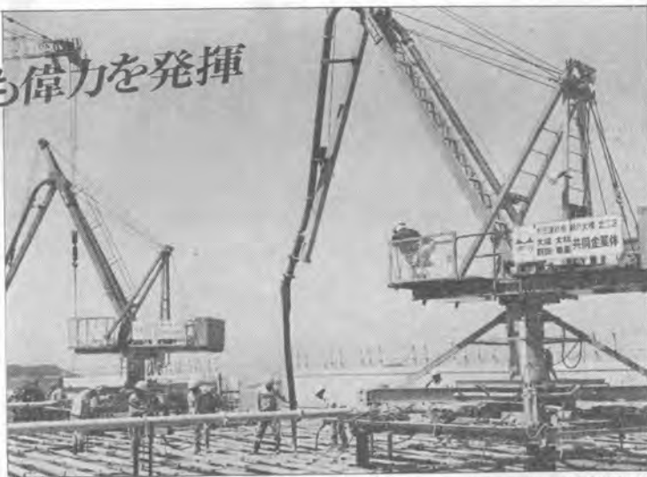
(本四架橋現場設置例)
