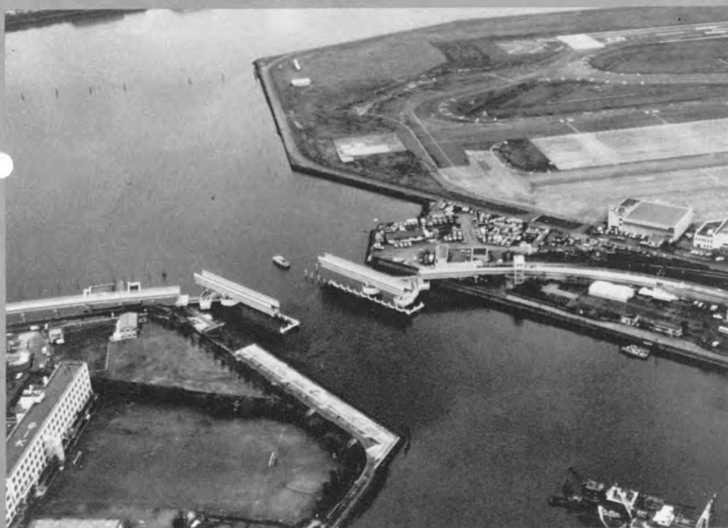
◆ 羽田可動橋開橋時
