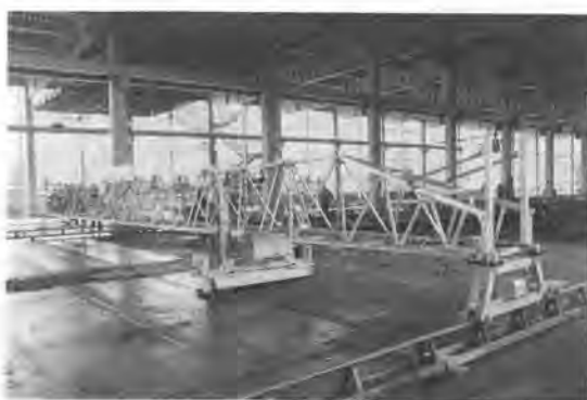
写真一 スクリードロボ全景
