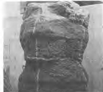
写真-2 施工後の固結体形状
