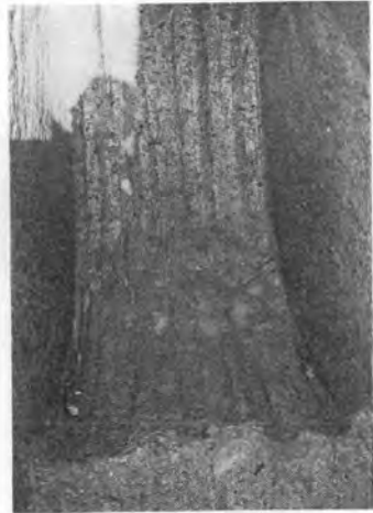
写真-4 掘削面の状況(試験項目 ③)
