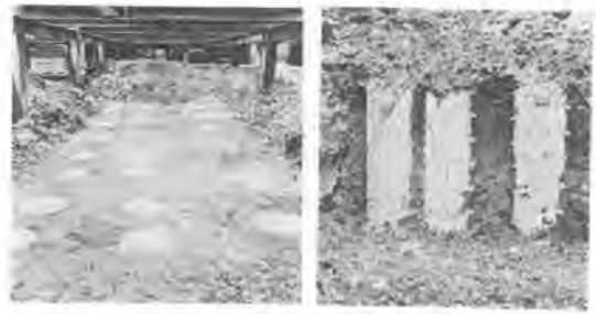
写真-1 パイル打設状況
