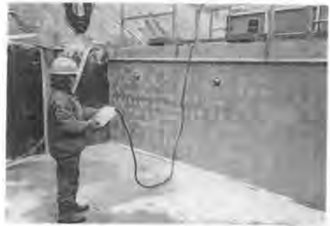
写真-2 自動型枠の操作状況
