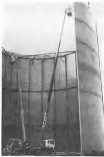
写真-11 愛知・小松 SK-200 ほか高所作業車
