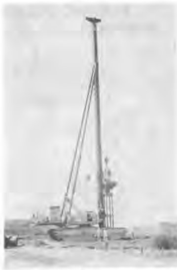
写真-5 超低接地杭打機 (SH 45-308 型)
