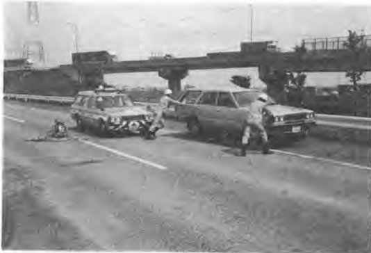
写真-5 作業状況
