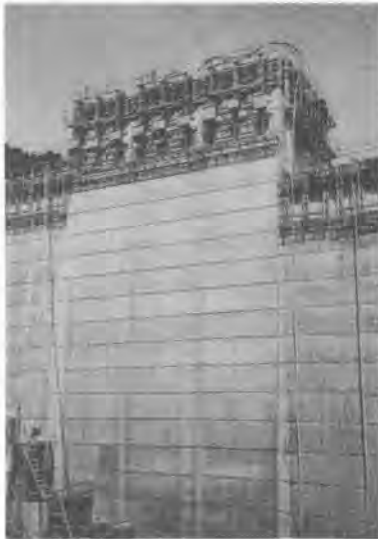
写真-5 自動型枠による施工状況
