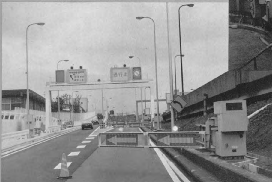
🌀 遮断機 (新設クランプと既設クランプの分流部付近)
