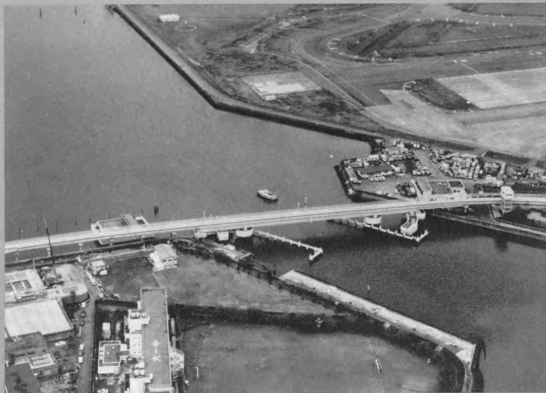
◆ 羽田可動橋閉橋時
