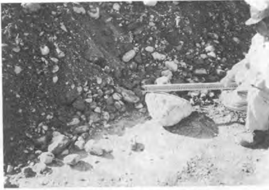
写真-2 埋戻しに使用した玉石混り砂れき
