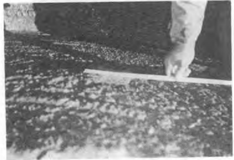
写真-5 玉石の切削状況
