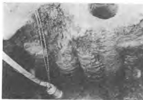
写真-3 遅効性固化材による柱列仕上り状態
