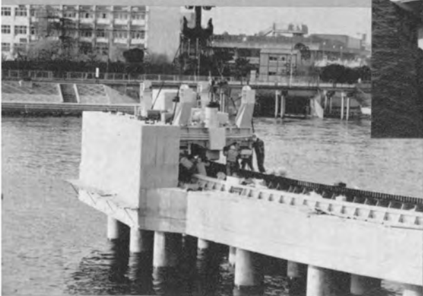
⇩旋回台車の架設
