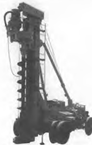
写真-7 ホイール式杭打機
