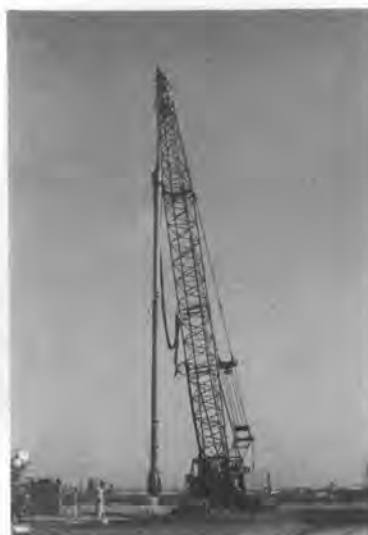
写真-9 ディーブ・パイブレータ
