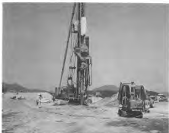
写真-10 遠隔操縦地盤改良施工機
