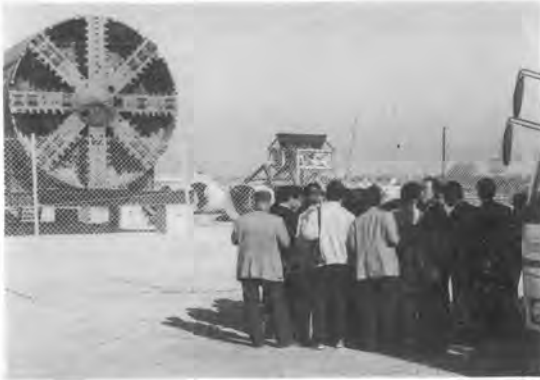
写真-4 引上げられたシールドマシン (三菱重工)
