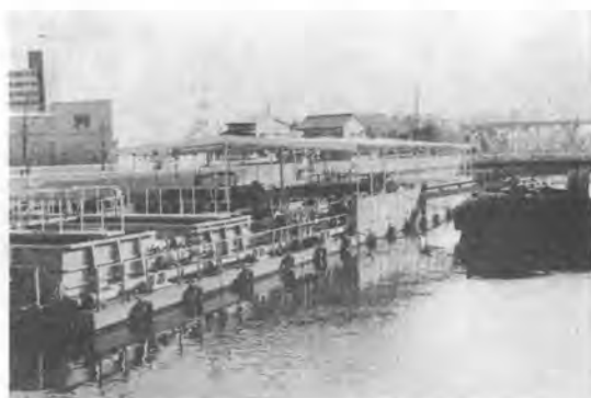
写真—40 機械式汚泥脱水処理船 TMD 船
