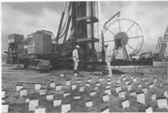
写真-9 グリッドドレインの打設状況
