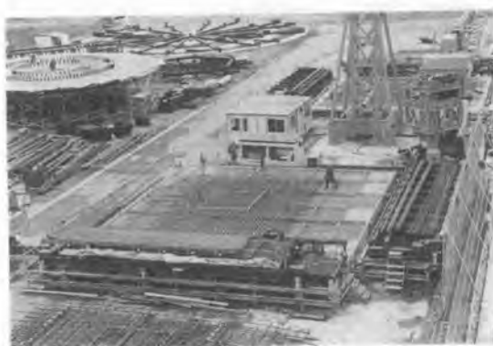
写真-2 作業状況(2)
