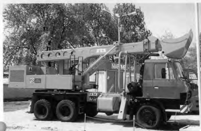
⇨チェコ製トラックバックホウ (0.8m 3 , エンジン出力 208 kW)
