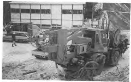
写真—22 吹付システム機
