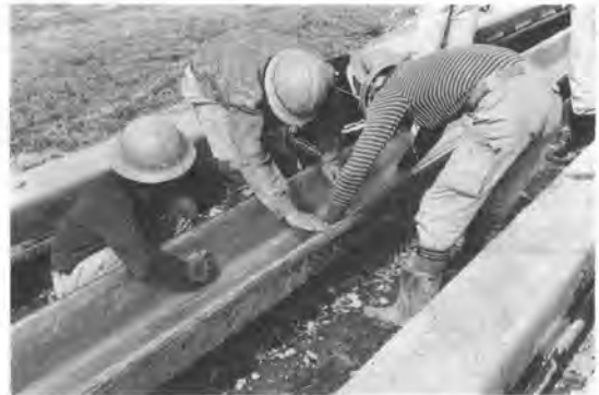
写真-1 被覆材貼付け状況
