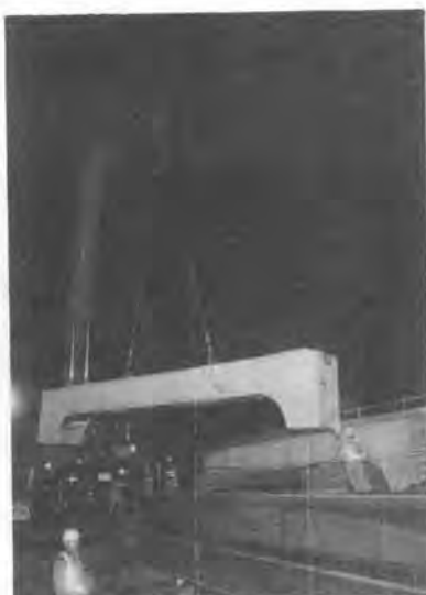
写真-15 切断ブロックの搬出
