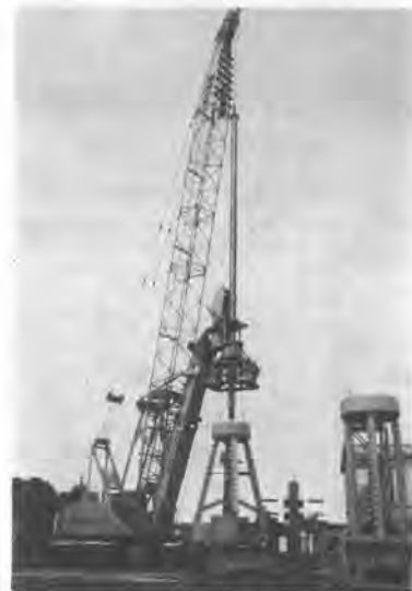
写真-8 アースドリル式掘削機 (ベルアース工法)
