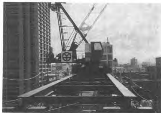
写真-4 タワークレーントラベリング工法
