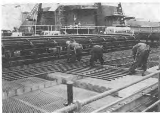
写真-1 作業状況(1)
