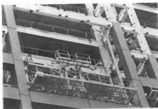
写真-43 遠隔操作式外装施工機
