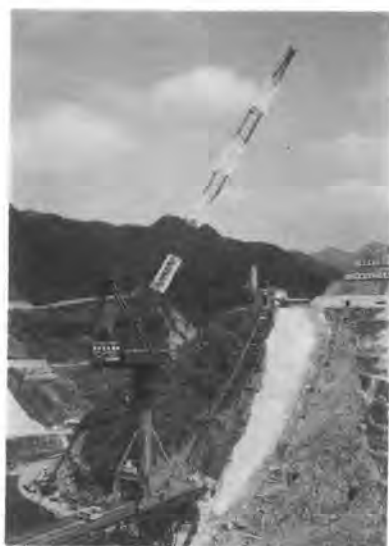
写真-3 走行式タワークレーン
