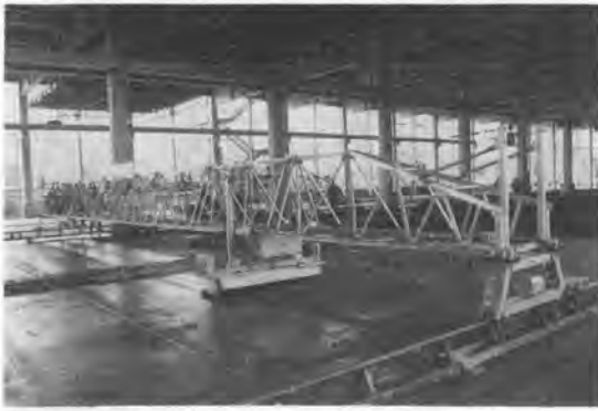
写真-25 コンクリート床ならし機スクリードロボ
