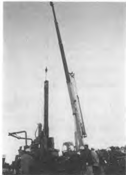
写真-2 鋼矢板引抜き状況
