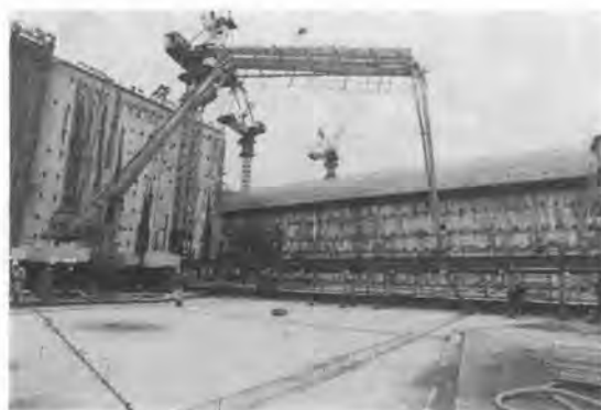
写真-24 大型コンクリートディストリビュータ
