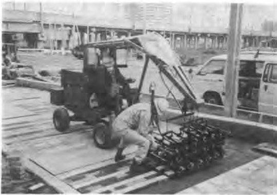
写真-36 ブロック敷設状況
