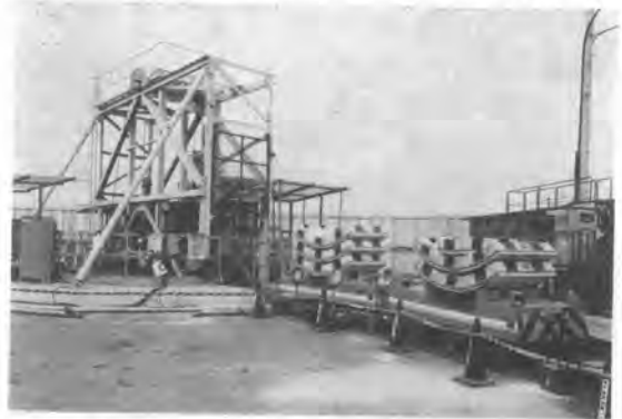
写真-19 自動走行台車と自動エレベータ装置
