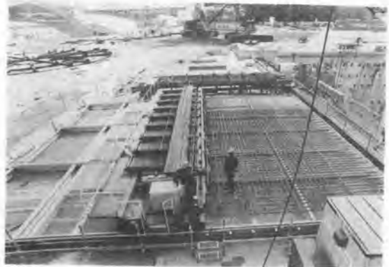
写真—48 鉄筋自動配筋装置
