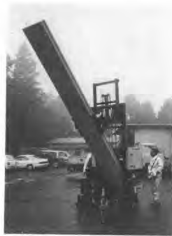
写真—42 壁パネル取付装置
