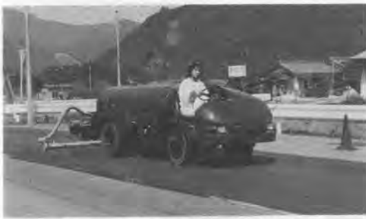
写真—30 強制路面冷却機パワークーラー NCD 10 ST 型
