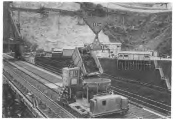
写真-26 バケットにコンクリート投入中
