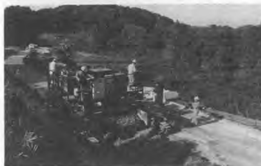
写真-35 スリップフォームペーバ施工状況
