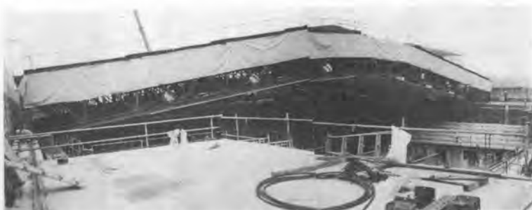
写真-44 トラベリング工法
