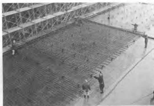
写真-3 作業状況(3)
