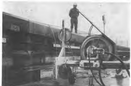
写真-14 コンクリート切断機
