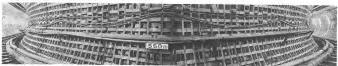
写真-5 急曲線施工状況(セグメント外径 \phi 6m, 曲率半径 20m)
