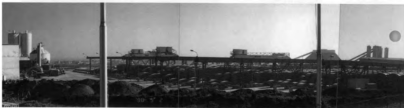
⇨セグメントヤード全景
