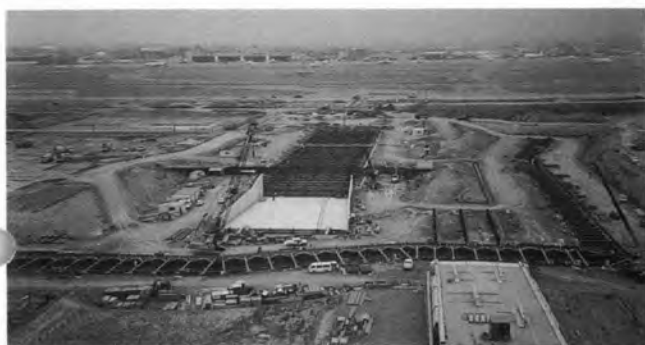
⇨ 空港アクセス道路 および共同溝工事
