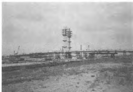
写真-4 エアサイド連絡橋工事（2面つり鋼斜張橋）
