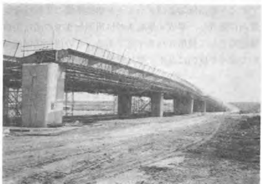
写真-5 ターミナル南連絡橋工事（鋼連続箱桁橋）
