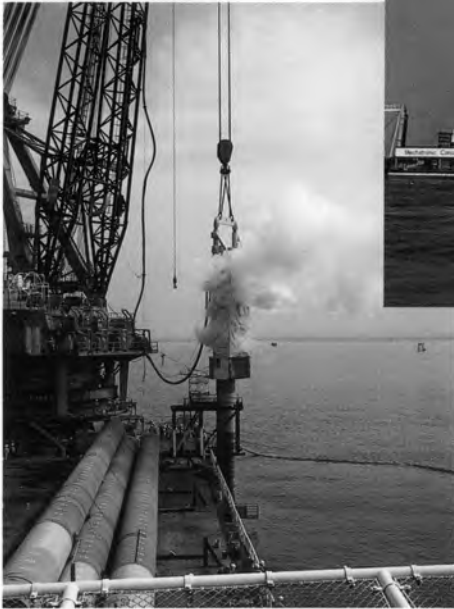
⇨ 木更津側立坑の大径鋼管杭の 載荷試験における杭打設
