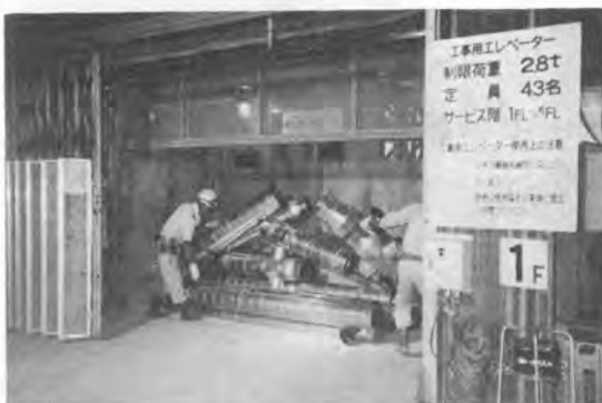
写真-5 荷積み作業状況バラ積み
