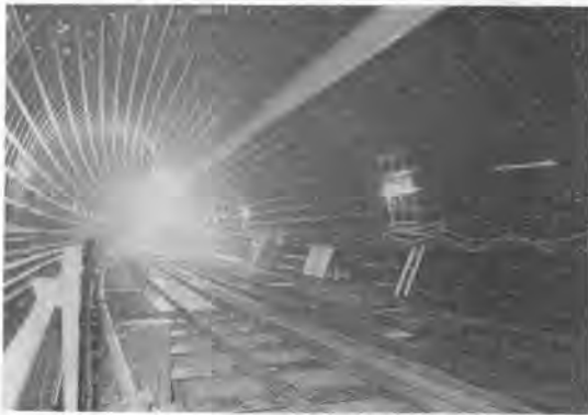
写真-8 1次覆工完了（豊島園第二工区）
