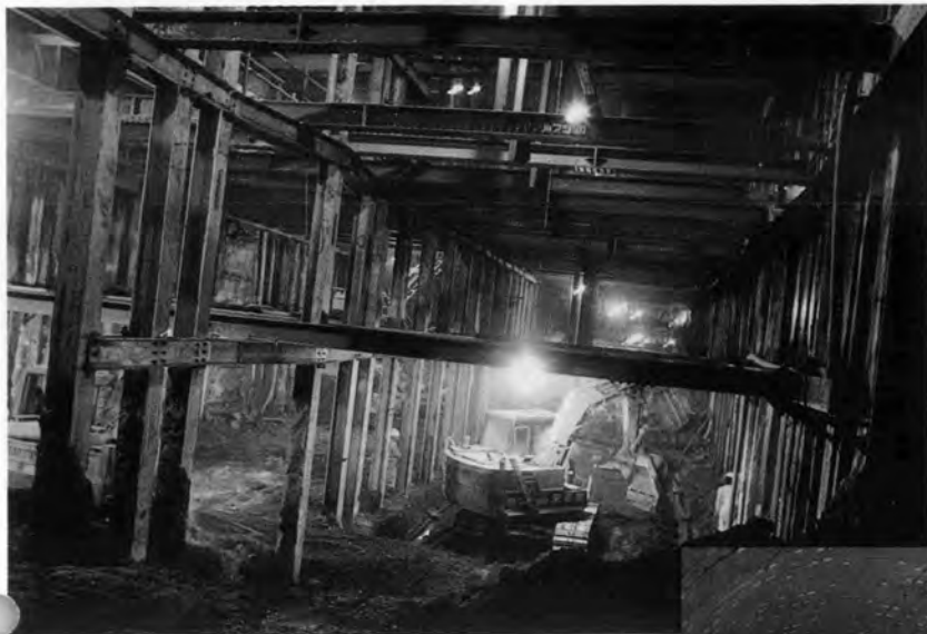
⇨ 練馬第一工区掘削状況
