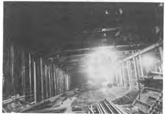
写真-4 掘削床付 (練馬第一工区)
