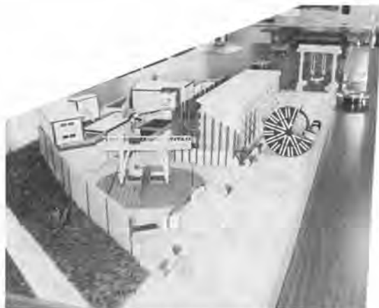
写真一四 シールド掘進工事立坑模型（シールド機は都営住宅5階建と同じ高さの13.94m）
