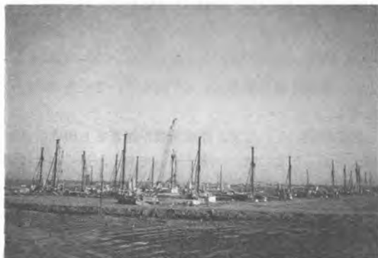
写真-3 共同仮設工事（CDM 工法施工状況）
