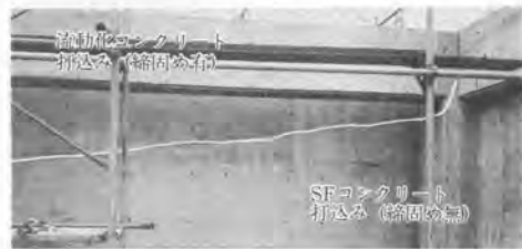
写真-3 実構造物の壁部材の脱型後状況
