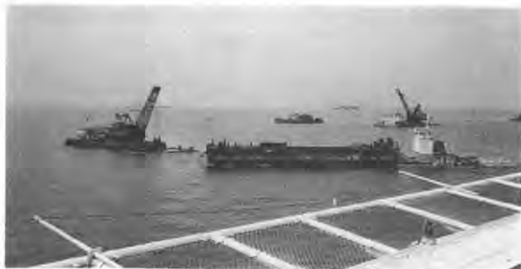
写真-1 木更津人工島における床掘工（グラブ式浚渫船と土運船）
