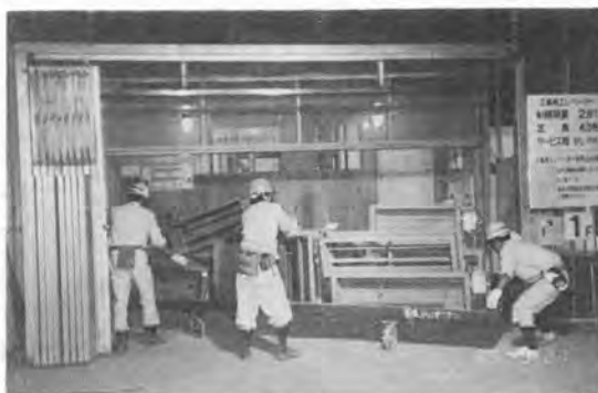
写真-4 荷積み作業状況台車使用
