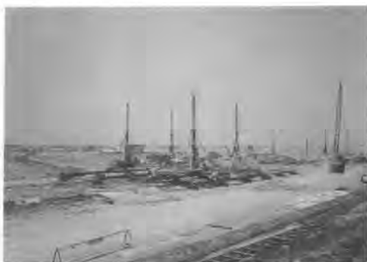
写真-6 東京モノレール工事 (JSG 工法施工状況)
