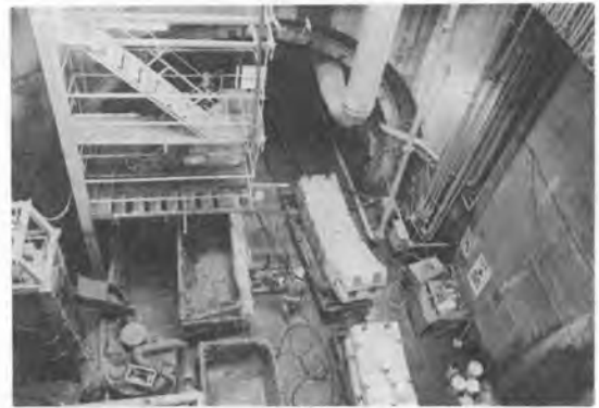
写真-7 立坑（豊島園第二工区）
