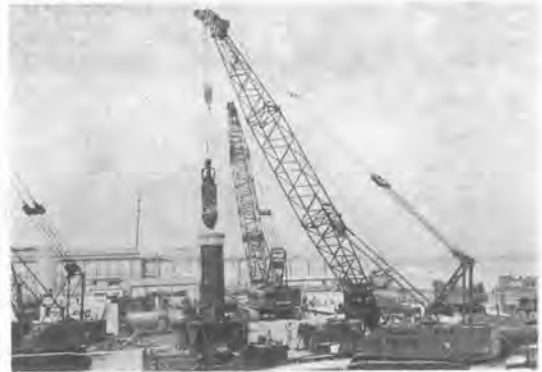
写真-4 柱列杭の掘削状況
