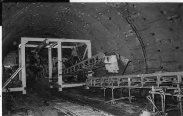
⇨ 練馬第二工区シールド初期掘進状況⇨
