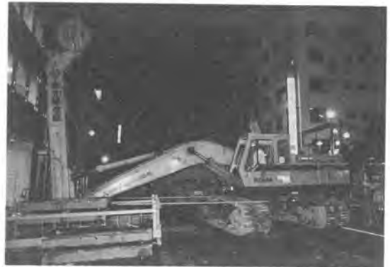
写真-3 機械掘削 (練馬第一工区)
