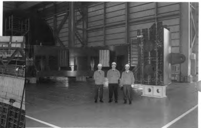
⇨ 外径 13.94m シールド機中胴部 1/2 半円に仮組み
