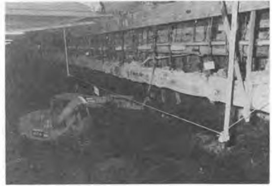
写真-6 埋設物防護・掘削（豊島園第一工区）
