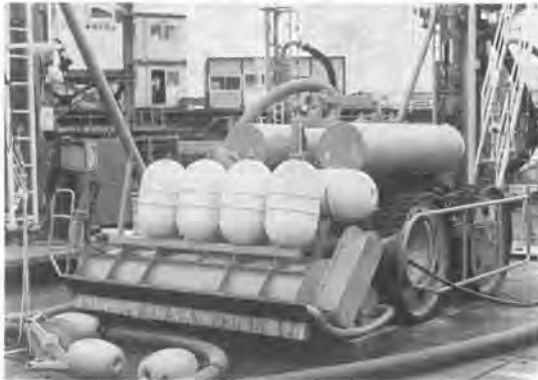
写真-3 水中打継目処理装置
