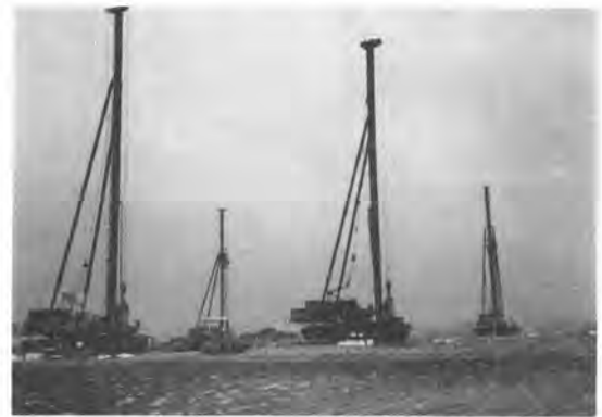
写真-1 地盤改良工事（バックドレーン打設状況）
