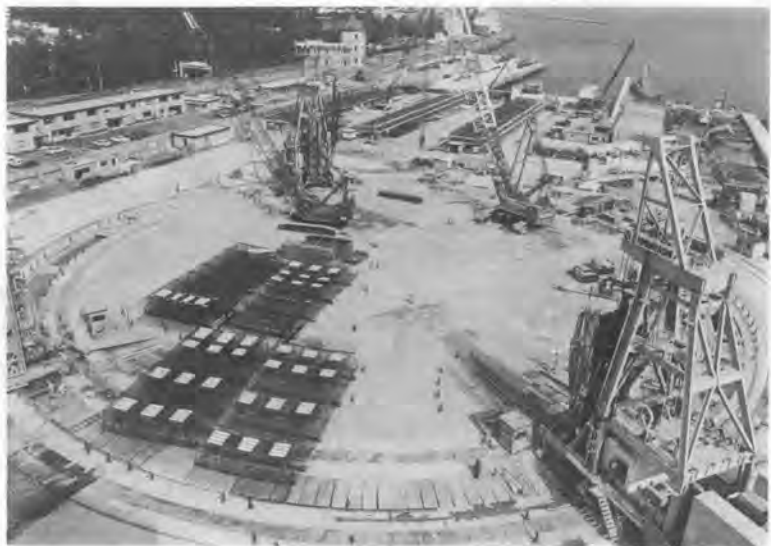
写真-1 地下連続壁掘削状況
