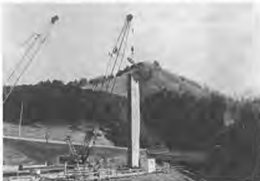
写真一 鳥居原止水対策工
