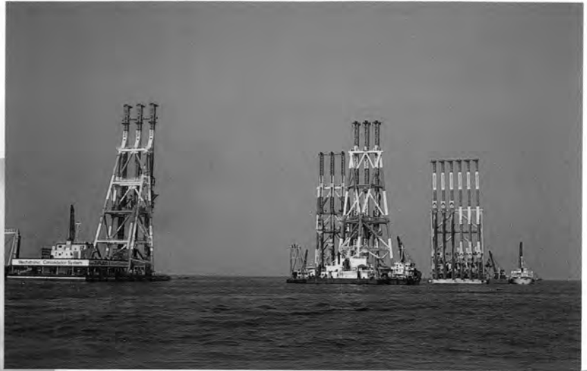
⇨ 川崎人工島地盤改良工事
