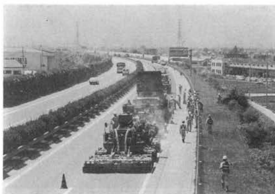
写真—17 リミックス施工状況
