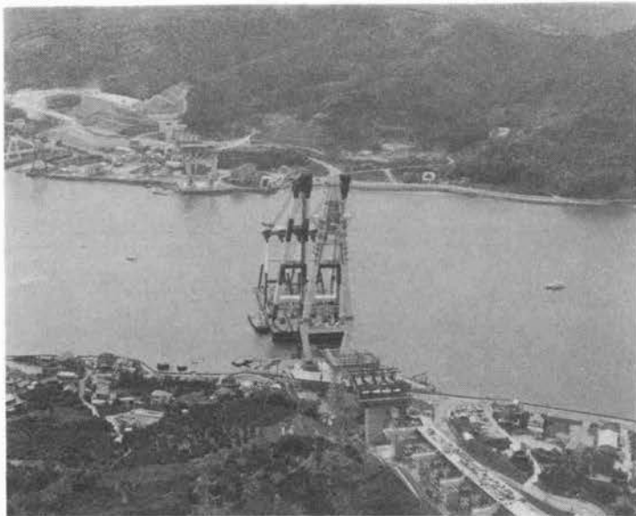
写真-8 Aブロック架設
