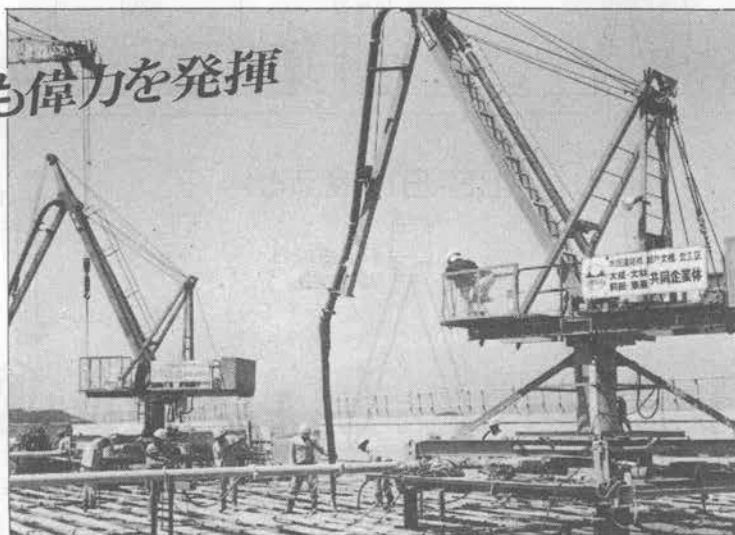
(本四架橋現場設置例)
