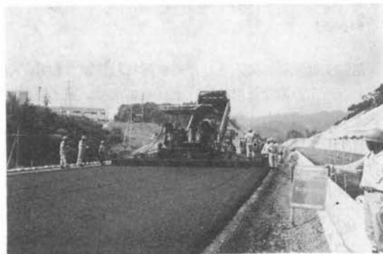
写真-5 大型フィニッシャ 1 台による敷ならし
