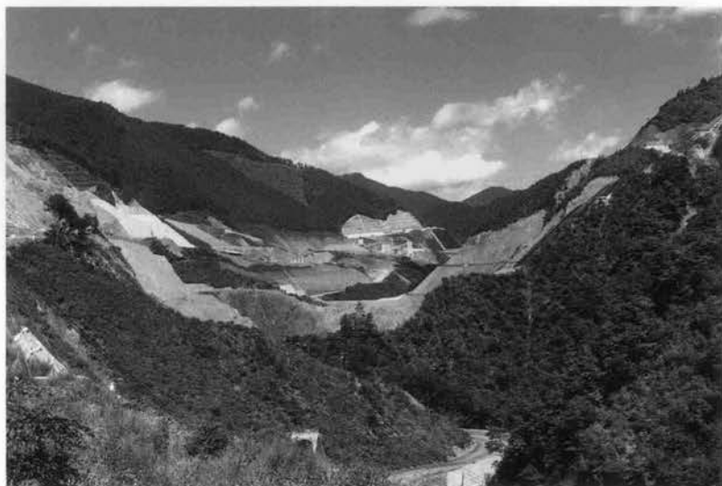
⇨ 基礎掘削（昭和61年9月）
