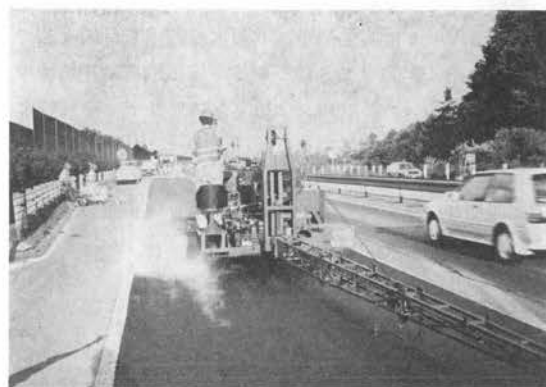
写真—18 舗装体冷却機（サーフェスクーラ）
