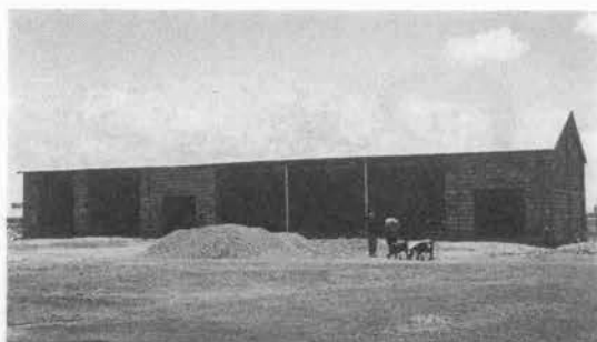
写真-4 自国予算で建設中の工場
