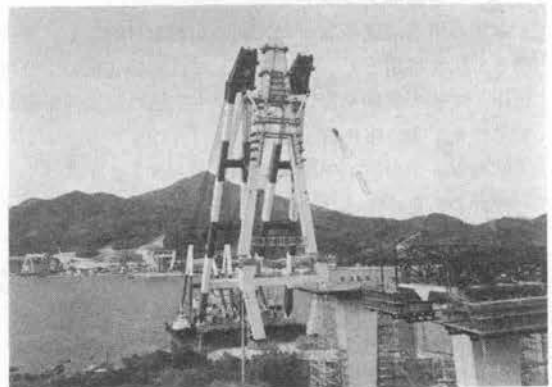
写真-7 Aブロック架設(2P)
