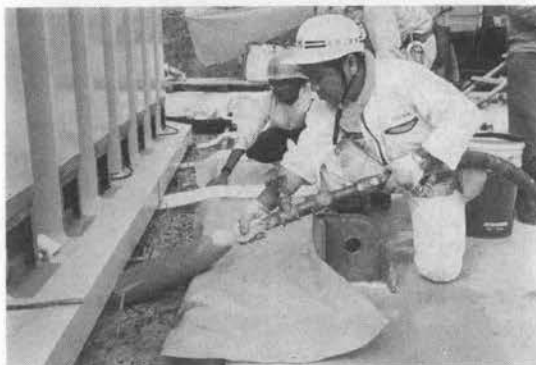
写真-3 塔基部グラウト (バグパイプ内注入)
