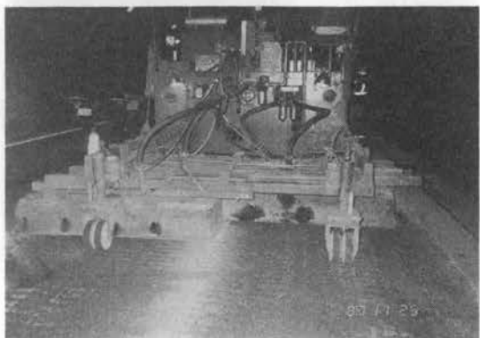
写真-15 コンクリートの目粗し状況
