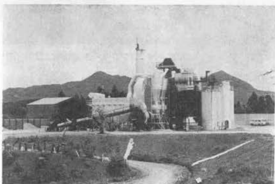
写真-9 180 t/hr アスファルトプラント
