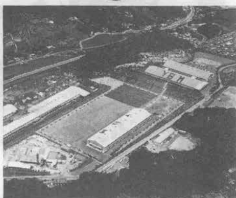
岸山工場全景
