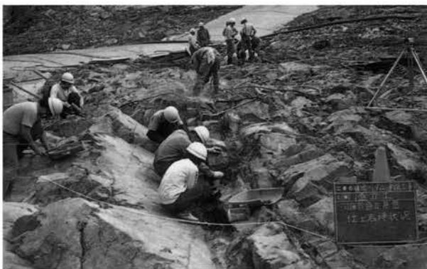
盛立前岩盤の清掃（昭和62年7月）
