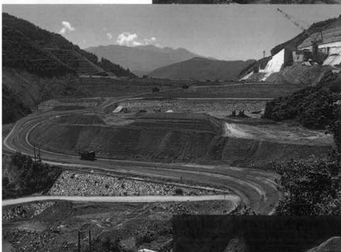
ダムサイト上流側より
