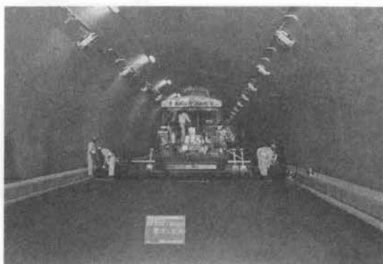
写真-13 ハイコンパクションフィニッシャーによる RCCP 施工
