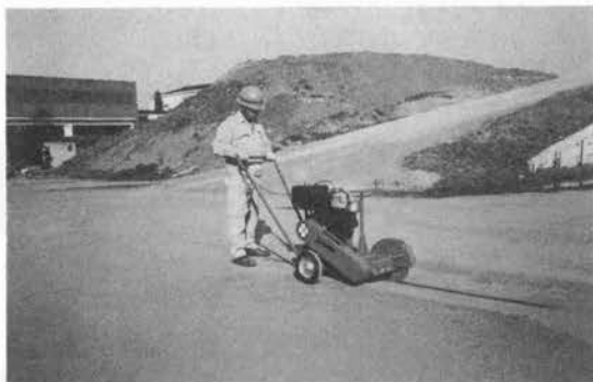
写真-14 クラック補修機（ブラッシング）
