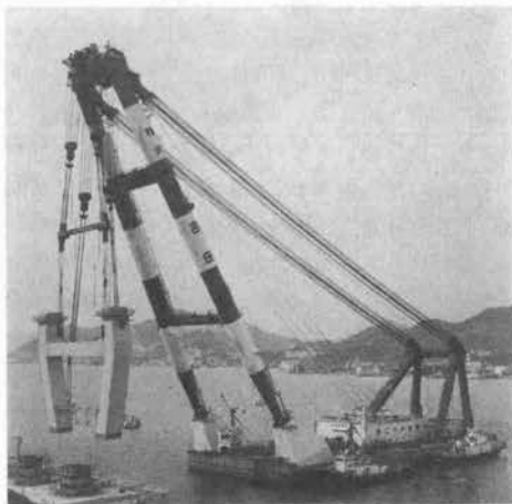
写真-4 Bブロック架設
