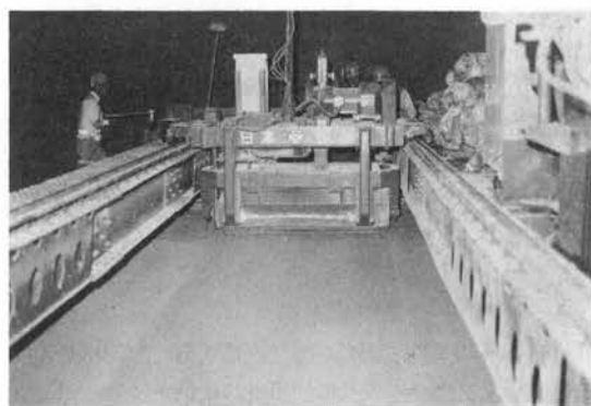
写真—12 骨材露出機施工状況
