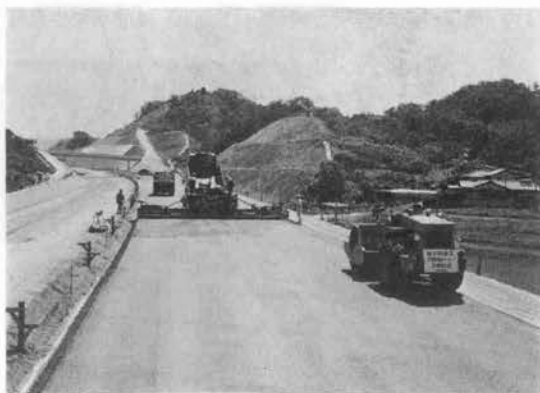
写真-1 フィニッシャタイプのベースペーパーによる敷ならし状況
