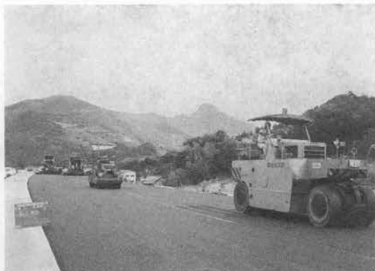
写真-8 初期転圧および 2 次覆転圧状況
