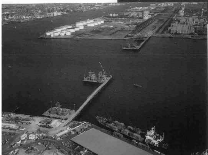
⇨ ケーソン基礎4基施工全景
