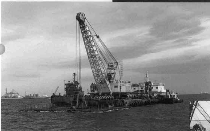
着手前の浚渫
