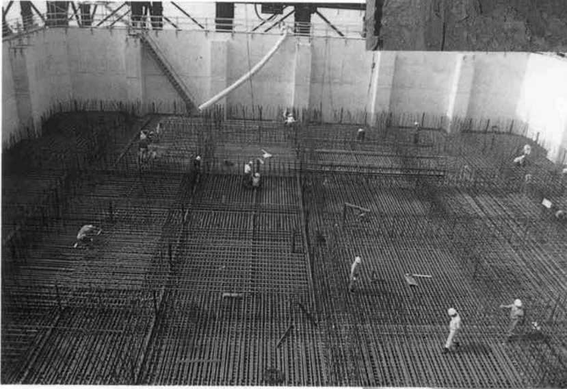
⇨ケーソン頂版配筋
