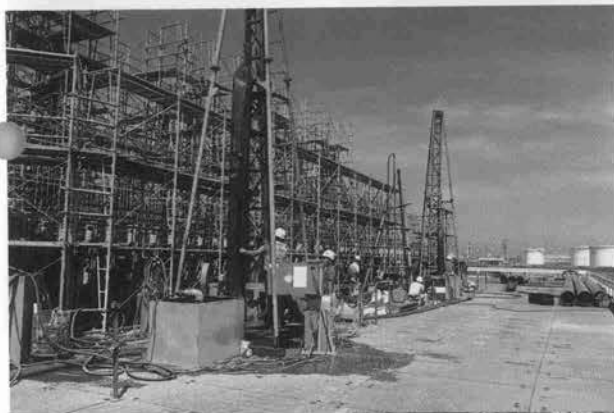
⇨ ディープウェル設置作業
