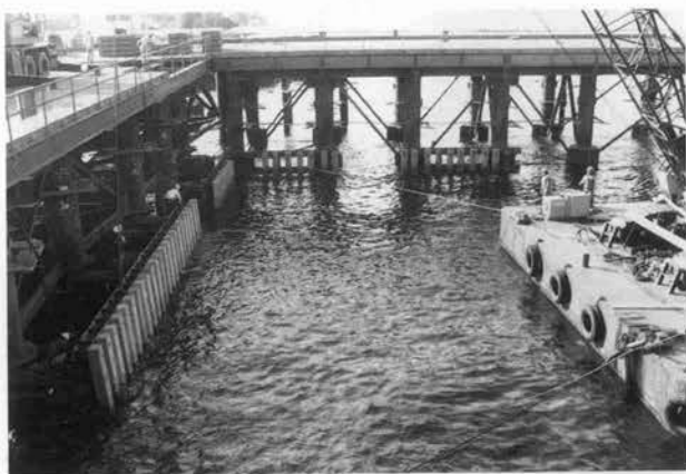
⇨ 栈台ジャケット防衛工
