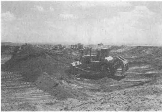
写真-2 掘削作業を行う 63 t 級リッパ付ブルドーザ
