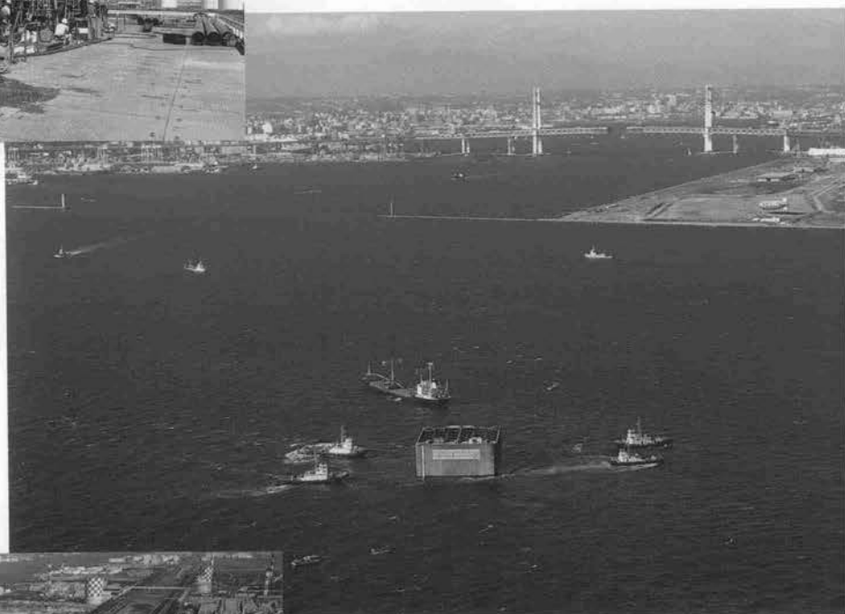
⇨ 鋼殻ケーソン曳航
