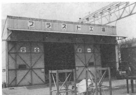
写真-1 プラスト工場
