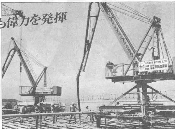
(本四架橋現場設置例)
