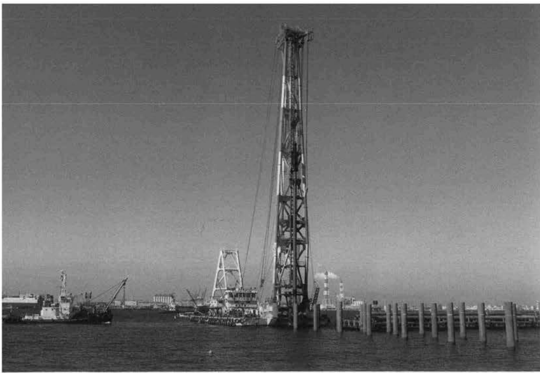
⇨ 渡り栈橋杭打ち
