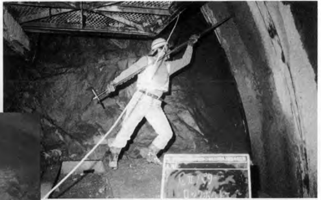
⇨ ロックボルト打設状況（水上側）
