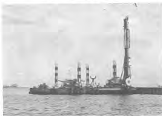
写真-4 海上打設機の全景
