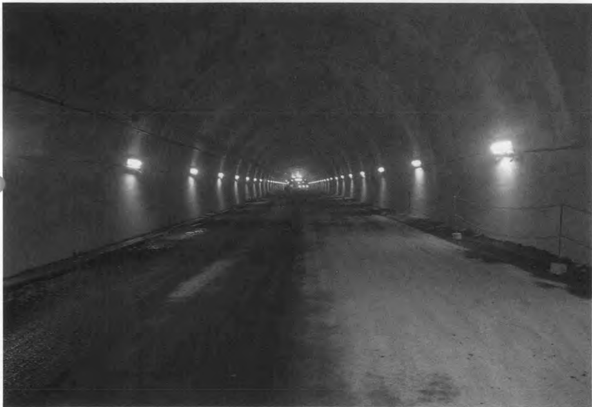
⇨ トンネルの覆工が完了した状態
