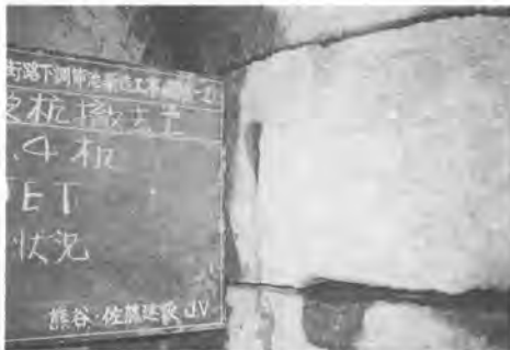
写真-4 スリット挿入状況
