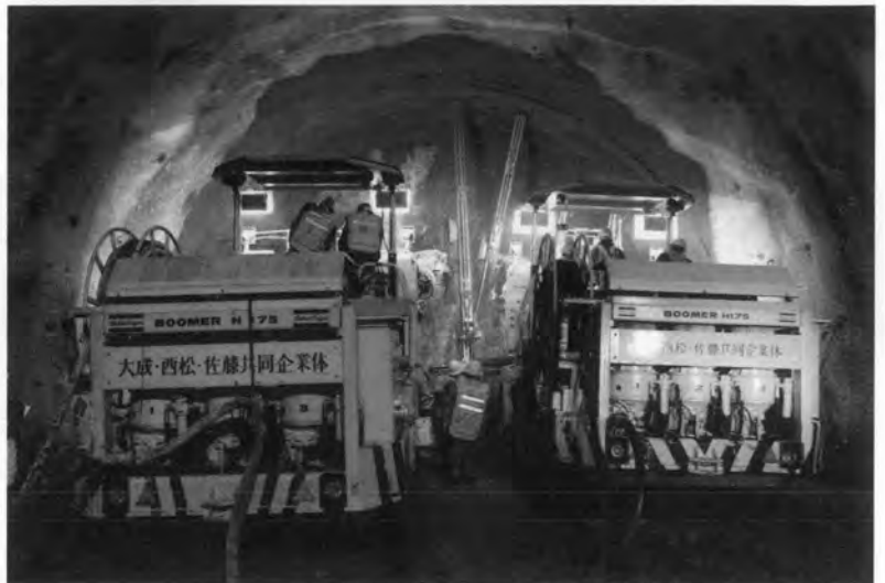
ロックボルトせん孔状況⇨ (湯沢側)
