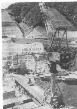
写真-3 コンクリート打設設備全景
