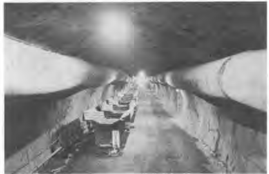
写真-1 坑内仮置状況
