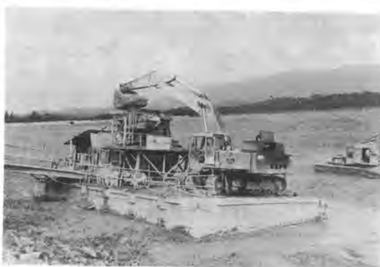
写真-8 工事全景
