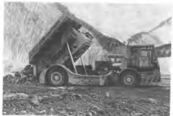
写真-2 坑外ダンブ状況
