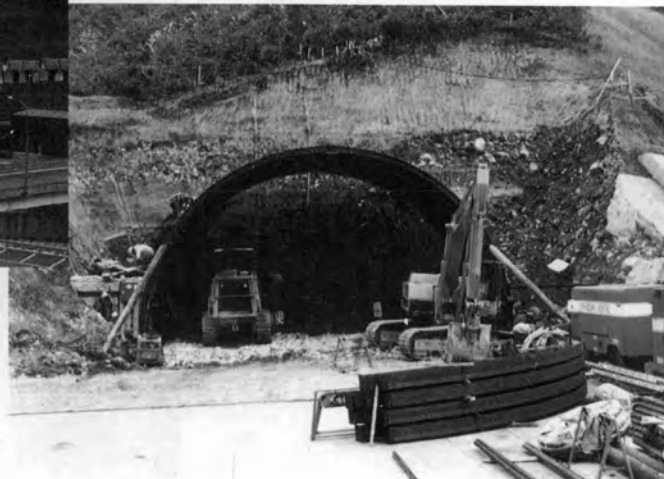
湯沢側坑口付け⇨
