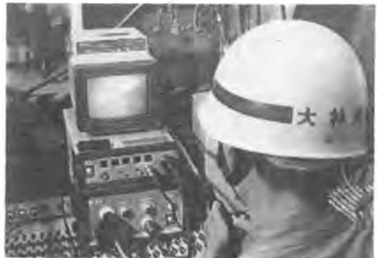
写真-1 シールド切羽監視システムによる 隔壁前方の観察状況
