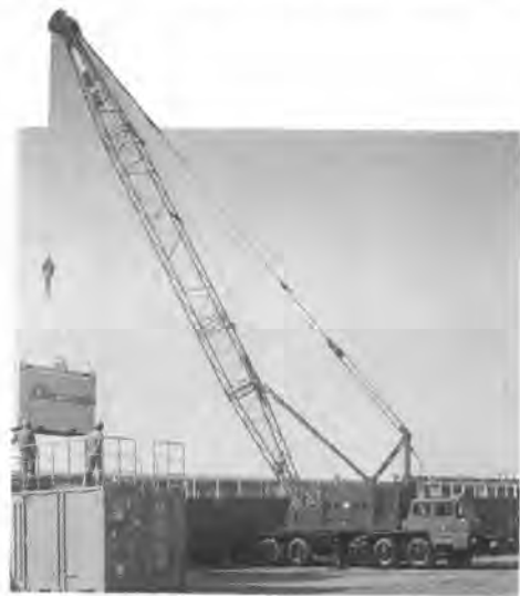
写真—1 住友建機 HC-118 RM 機械式トラッククレーン
