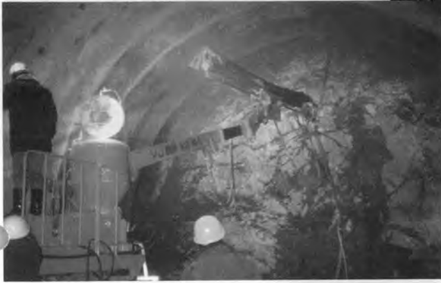
⇨ コンクリート吹付状況（水上側）
