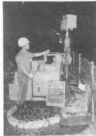
写真-2 ボーリングマシン
