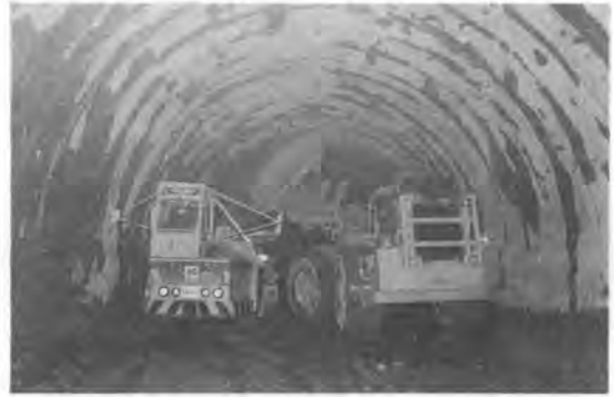
写真-4 ずり積状況
