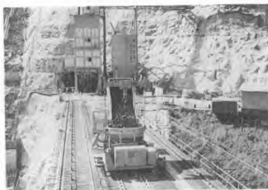
写真-2 コンクリート移替状況
