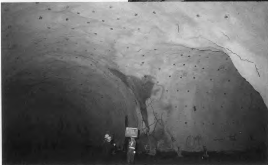
⇨ コンクリート吹付が完了した 電気集塵室取付部付近
