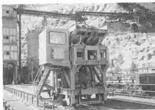
写真-4 トランスファーカー
