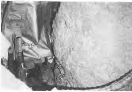
写真-3 ノズルセット状況
