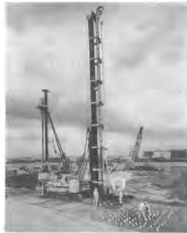
写真-2 打設機の全景
