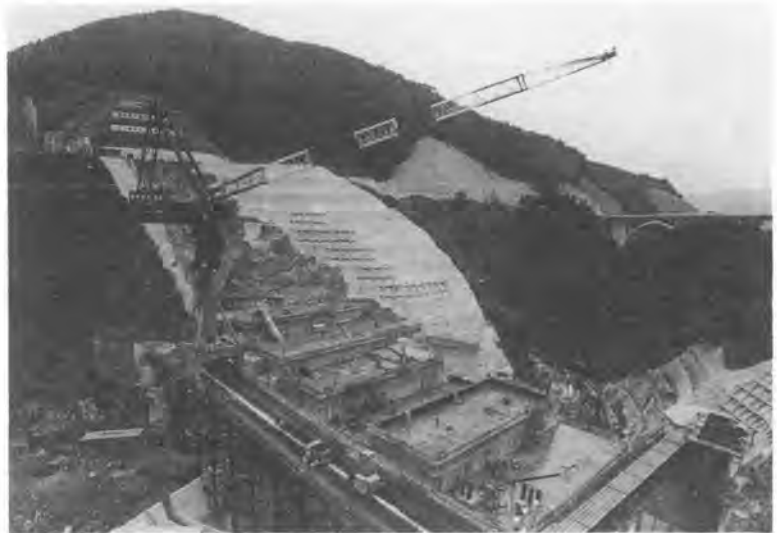
写真-1 犬鳴ダム全景
