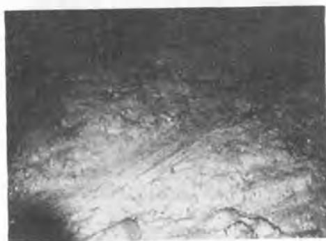
写真-8 噴射攪拌杭表面に残された カッタビットの線条痕
