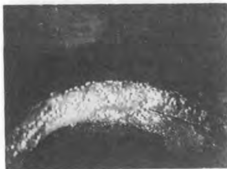
写真-7 切羽に出現した埋設番線屑
