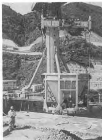
写真-7 コンクリートバケットおよびつり具
