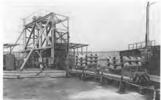
写真-1 オートマチック・セグメント・キャリヤシステム
