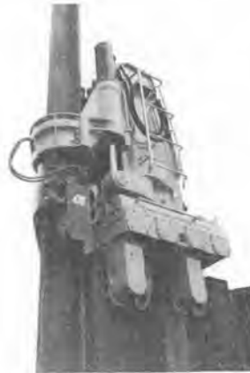
写真-4 サイレントパイラ C4
