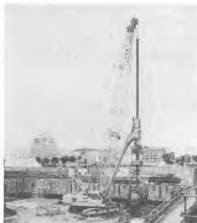
写真-4 KH 180-3 拡底杭施工用アースドリル
