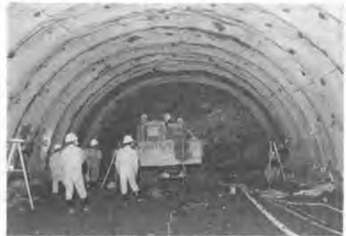
写真-1 吹付け状況
