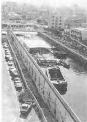
写真-6 機械式汚泥脱水処理船「TMD 2号船」
