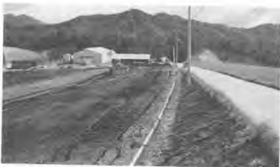
写真-2 実施工状況
