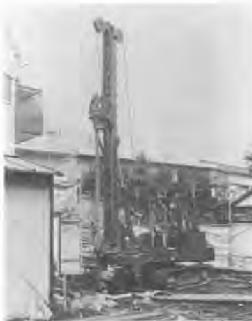
写真-1 NB 60 BH 杭施工用機械
