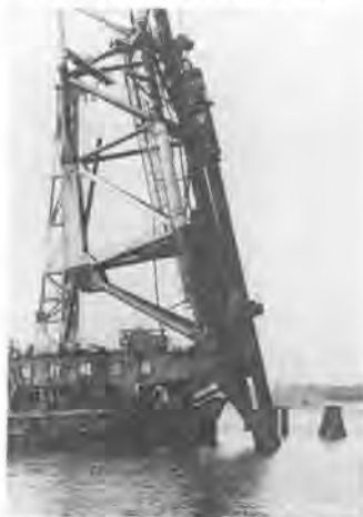
写真-1 油圧ハンマ HNC 125 の海上における稼働風景
