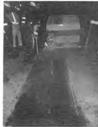
写真-4 稼働後現場写真
