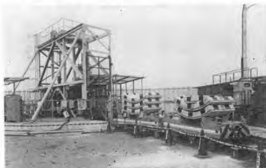
写真-14 オートマチック・セグメント・キャリヤシステム
