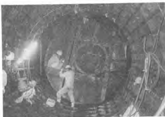
写真-11 ドッキング前圧気ドア取付
