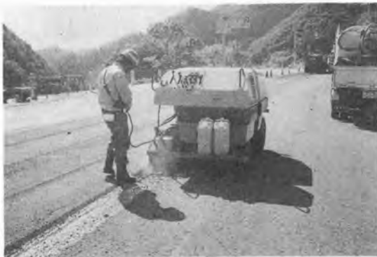
写真-6 稼働後現場写真
