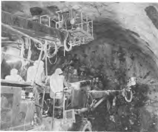
写真一2 切羽マーキングおよび削孔状況
