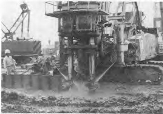
写真—16 SMW 3軸機拌ビット部分
