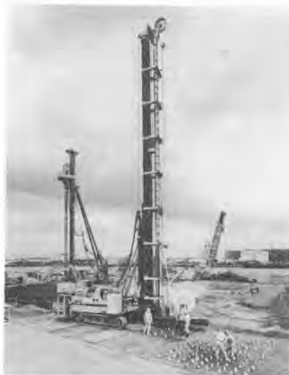
写真-1 グリッドドレーン工法
