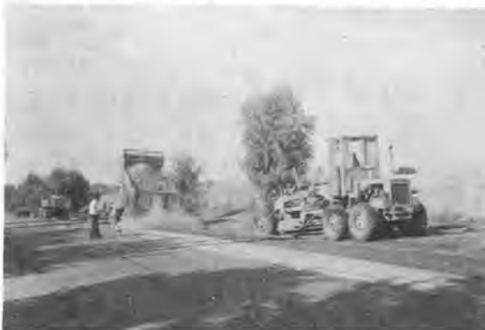
道路の補修状況
