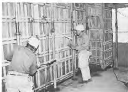
写真-4 林バイブレータ製型枠振動モータ使用例
