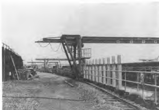
写真二 現C滑走路付近のクレーン設備上端は進入表面以下におさえている
