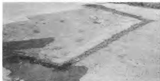
写真-10 稼働後現場写真
