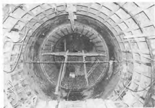
写真-12 ドッキング完了後セグメント巻立
