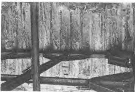
写真—17 SMW 構築壁
