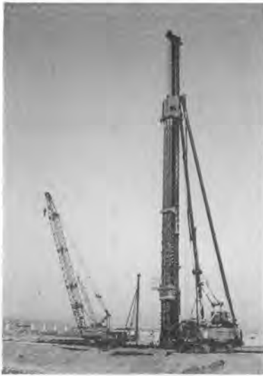
写真—15 SMW 掘削攪拌機（3軸機）（攪拌深度 45m）
