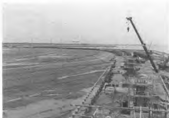
写真一 R地区の橋脚工事 (後方は現C滑走路付近の共同仮設区間)
