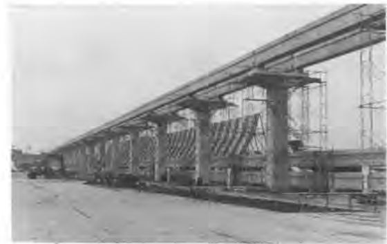
写真-4 架設された軌道桁
