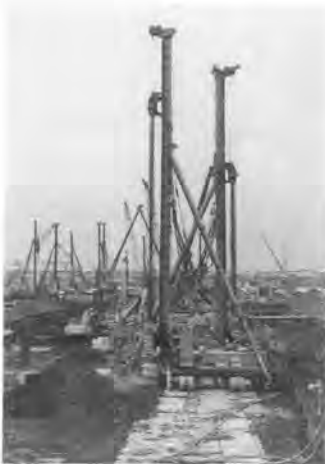
写真-3 地盤改良 (DJM 工法)
