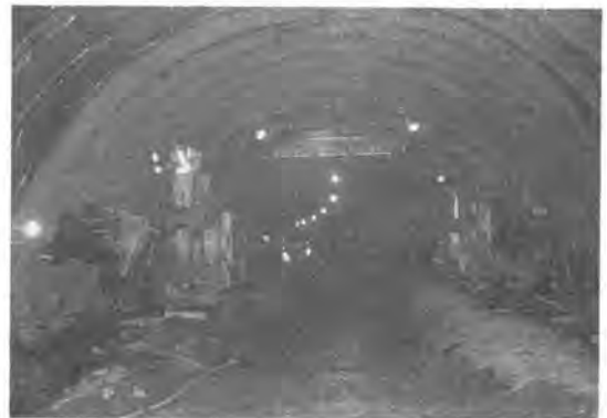
写真-21 坑内作業
