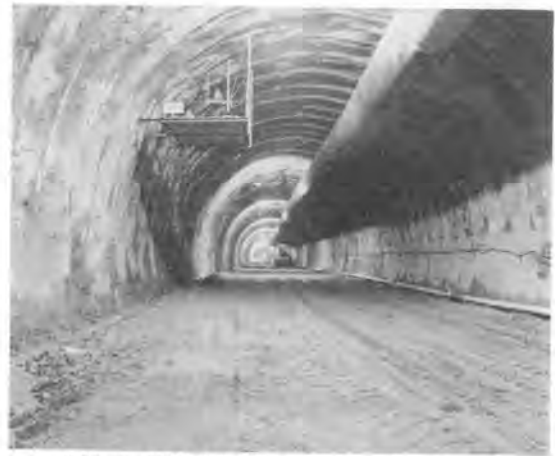
写真一3 坑内に設置されたトータルステーション
