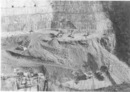
写真-2 掘削状況
