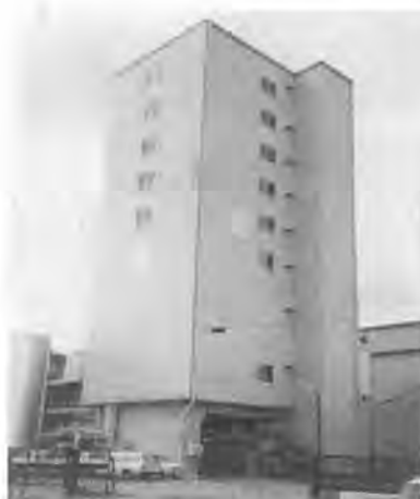
写真一 都市型アスファルトプラントの一例
