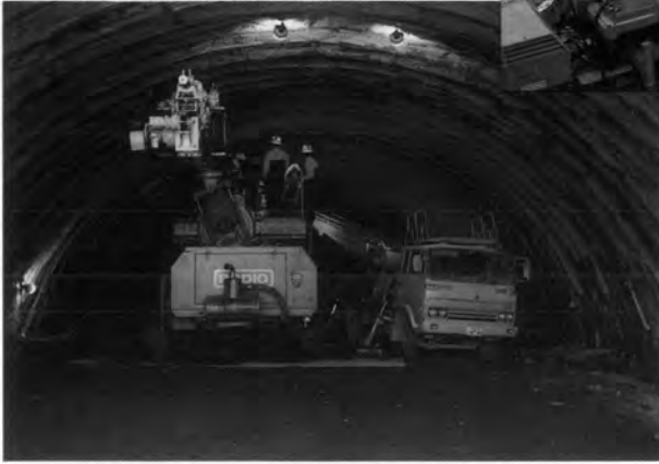
⇨RJFP の打設状況（使用機械 SR-510）
