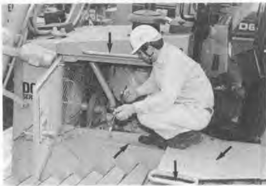
写真-6 メンテナンス個所の集中化と手すり・滑り止めステップ
