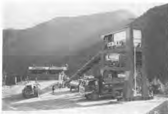
写真-2 転圧コンクリート用移動式プラント
