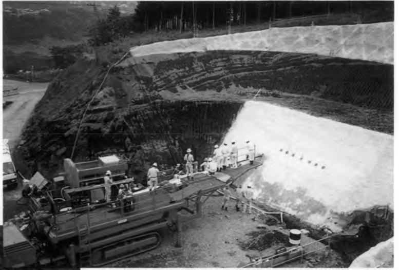
⇨RJFP 工法の試験施工（西坑口切土部の露出土はローム，スコリア層）
