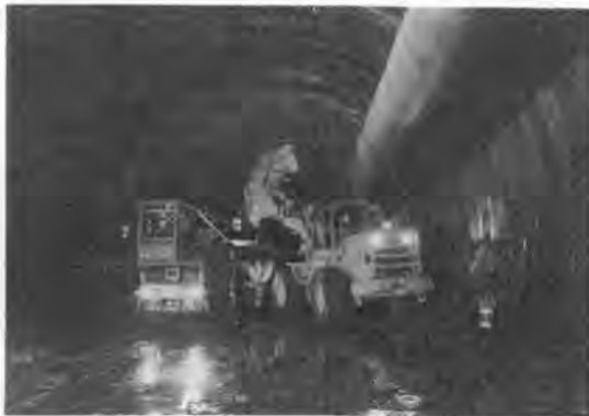
写真-2 ザリの積込状況 (ホイールショベルとキルナコンビトラック)
