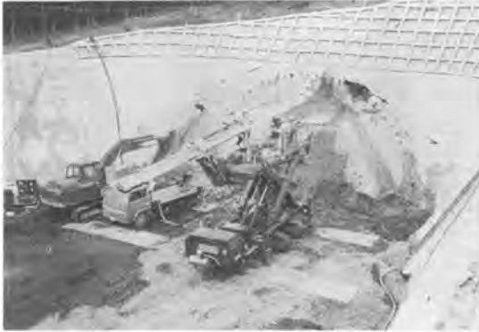
写真-1 RJFP試験施工状況 (SR-510)
