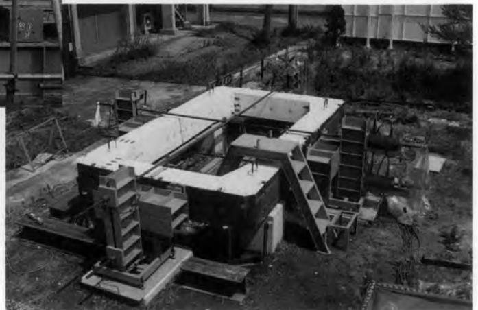
合成構造方式沈埋函の構造実験 函断面載荷実験（試験後）
