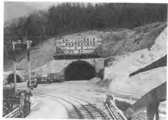
写真-1 雁坂トンネル山梨側坑口全景 (右・本坑, 左・避難坑)
