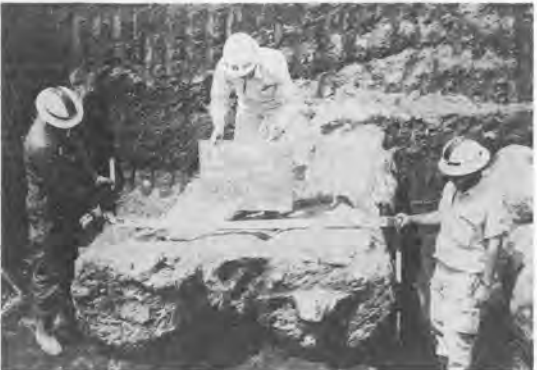
写真-3 改良体造成状況
