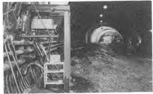
写真-4 レーザーマーキング装置の設置状況
