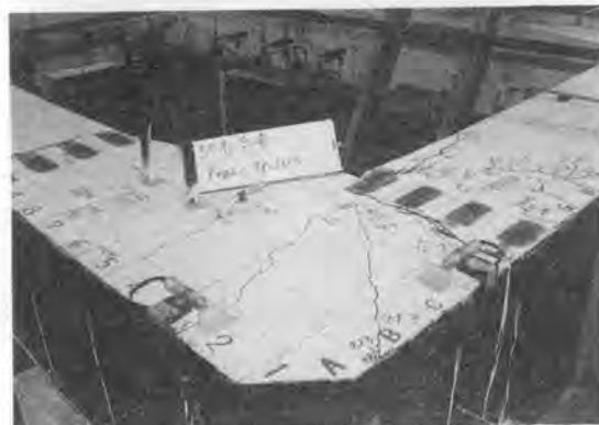
写真二 函断面載荷実験供試体 No. ② のひびわれ状況 (試験後)
