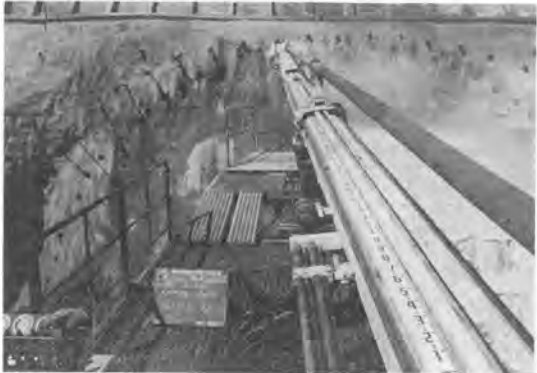
写真-2 RJFP削孔状況
