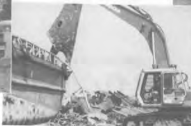
ラバウンティシアー (切断機) Labounty Mobile Shear
