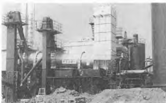
写真-2 バグフィルタ付再生アスファルトプラントの一例
