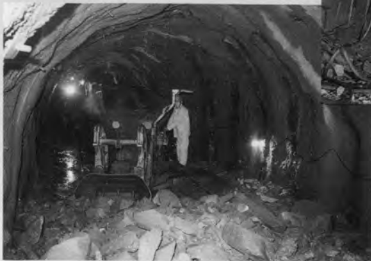
⇨ 避難坑ずり積込状況 (ロッカーショベル)
