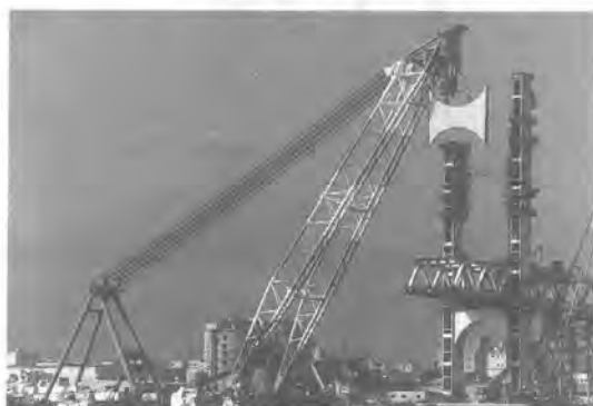
写真-4 塔中ブロック架設状況
