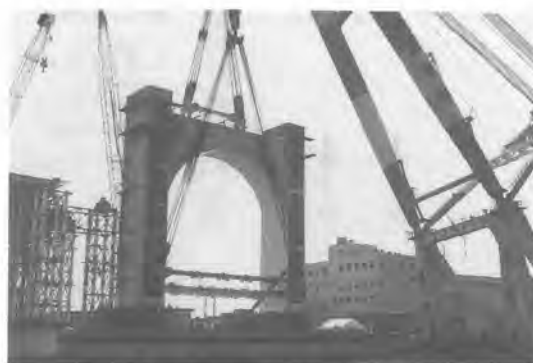
写真-3 塔下部大ブロック架設状況
