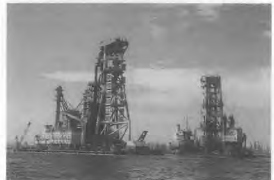
写真3 深層混合処理船 (80~150 m³/hr 改良面積 4~6 m²/回)
