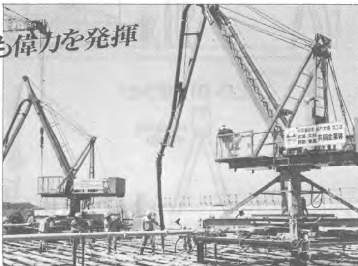
(本四架橋現場設置例)
