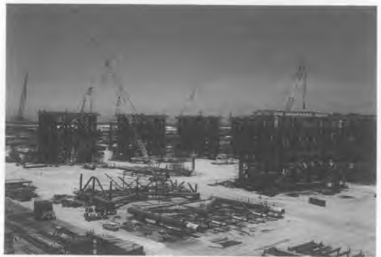
写真—6 ジャケット製作状況（1基750t～2,200t）
