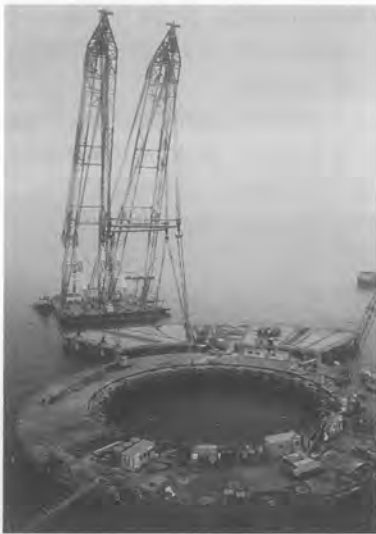
写真—4 川崎人工島ジャケット（1基1,800t）据付大型クレーン船（3,600tつり）
