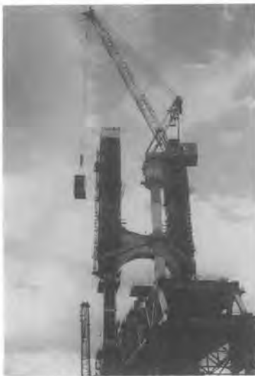
写真-5 塔上部単材架設状況
