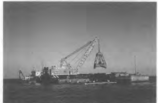
写真1 大型グラブ浅瀬船 (バケット容量 32~15 m³)
