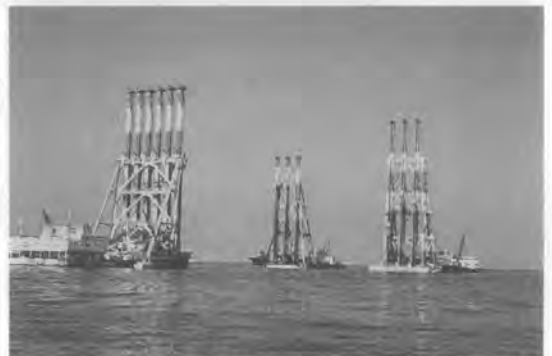
写真2 サンドコンパクション船 (3連装, 6連装) 砂杭径 1,000~2,000 mm, 長さ 50~60 m
