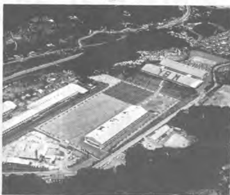
岸山工場全景
