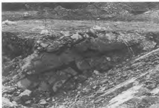
写真-2 保安物件に近接した岩盤破碎
