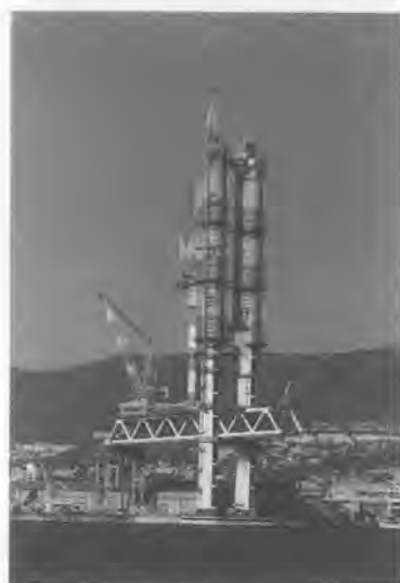
写真-7 塔完成状況
