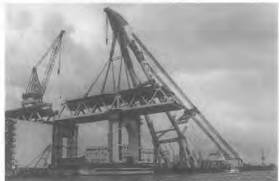
写真-6 主桁大ブロック架設状況
