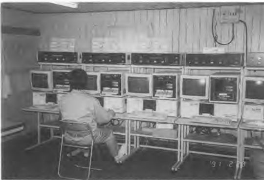
写真-1 注入管理状況 (管理室内部)
