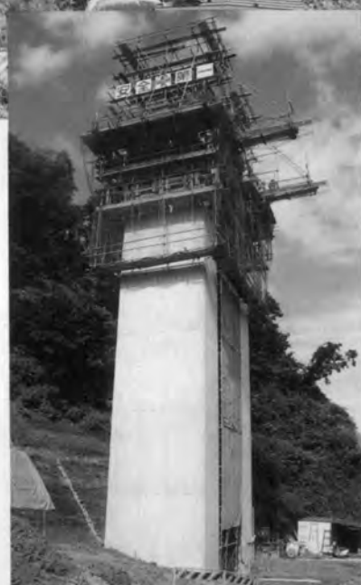
⇨ ジャンプアップ工法による施工
