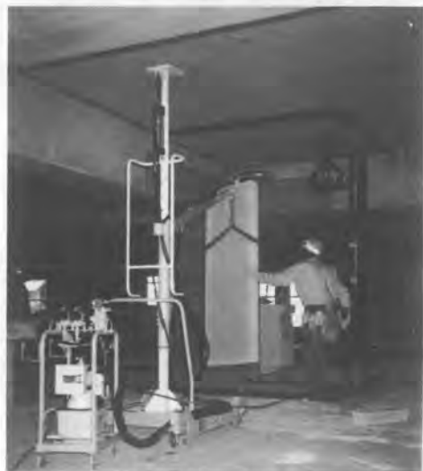
写真-8 マルマ MFA 130 ALC パネル取付装置
