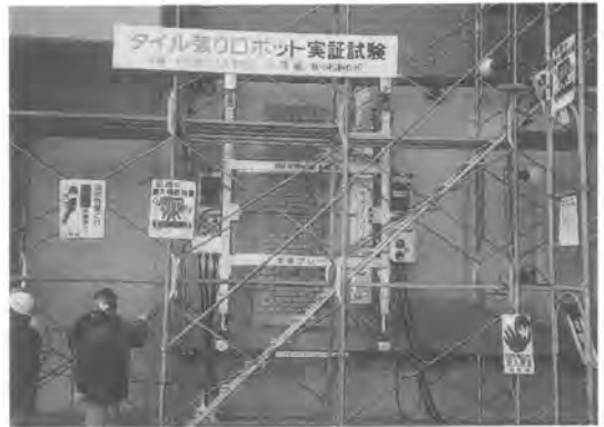
写真-8 現場におけるタイル施工風景
