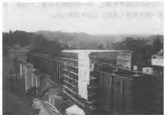
写真-2 桁架設状況
