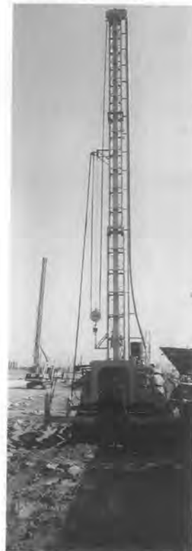
写真-2 打設全景
