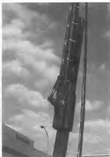
写真一 施工状況
