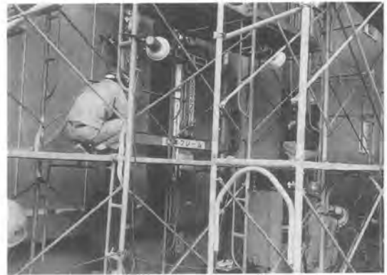
写真-7 現場における下地施工風景
