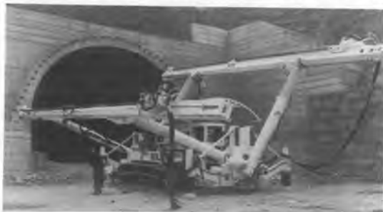
写真-3 Trevitubシステムを搭載したSoilmec SM 505/TDドリルマシン
