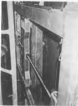
写真-4 下地施工風景
