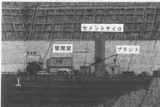
写真-2 ロボットの設置状況 (管理室およびプラント)
