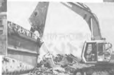
ラバウンティーシアー (切断機) Labounty Mobile Shear
