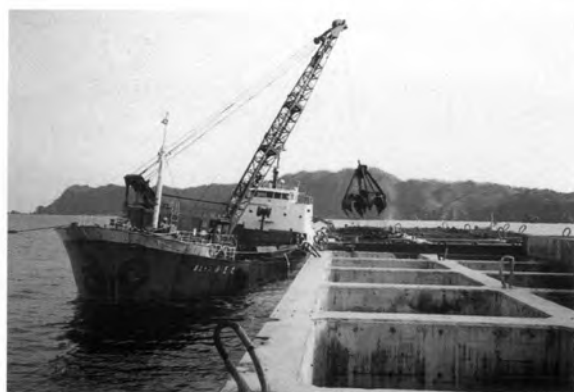
⇨中詰材の投入
