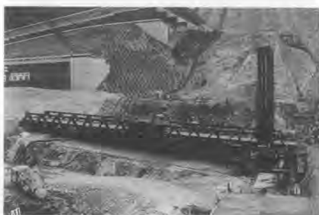
写真-1 リフトアップ棧橋
