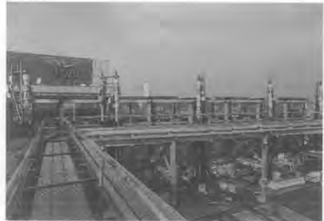
写真-2 ジャッキの取付状況
