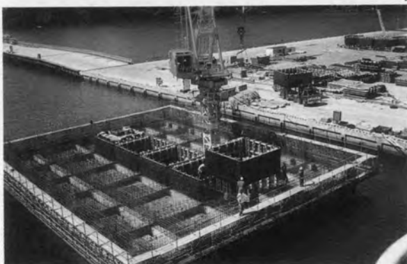
⇨ 鋼製型枠の組立て
