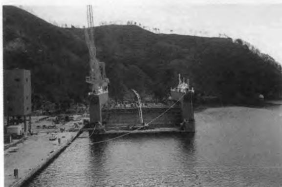
⇨ フローティングドックによるケーソン製作
