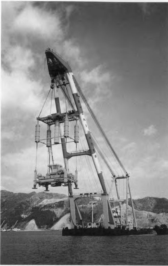
⇨ 捨石均し機組立完了
