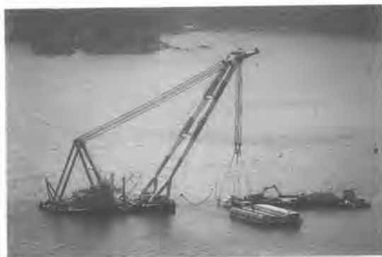
写真-3 捨石ならし作業状況
