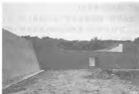
写真一 調整池堰堤におけるPC型枠施工例
