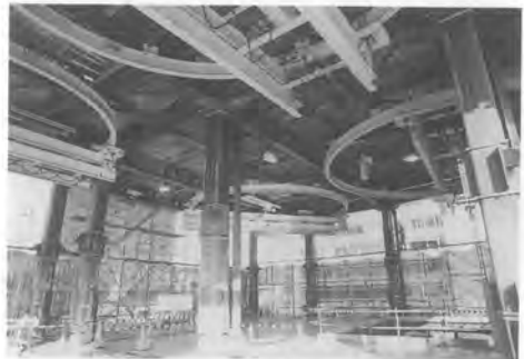
写真-3 サークルクレーンの取付状況
