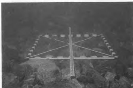
⇨ マウンド天端面の 仕上り状況
