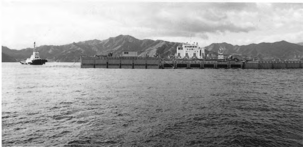
⇨ケーソンの据付完了(3函目)
