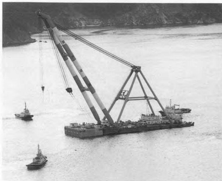
⇨ケーソンの据付状況(1函目)
