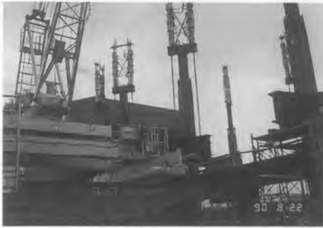
写真-1 駆動階の鉄骨建方状況
