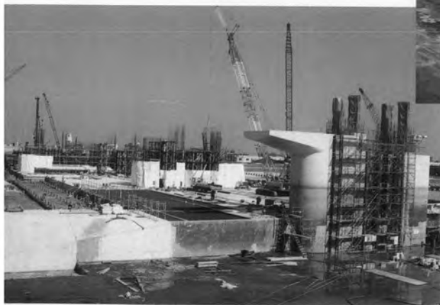
↑堰柱立上り状況
