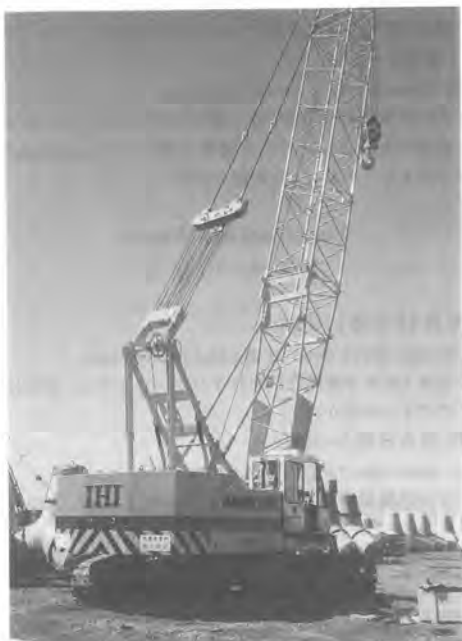
写真—5 石川島 DCH 650 全油圧スパンナークレーン
