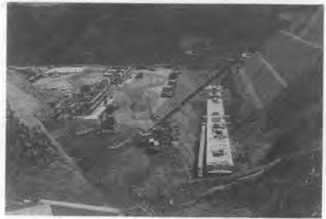
写真—5 2次プラント基礎造成
