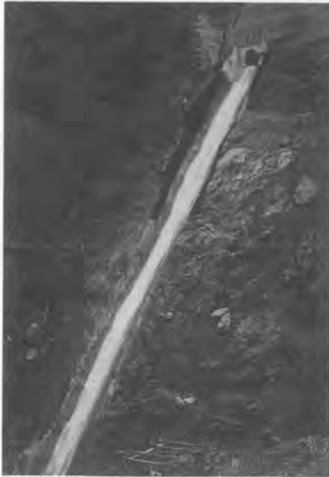
写真—4 原石山仮排水トンネル吐口
