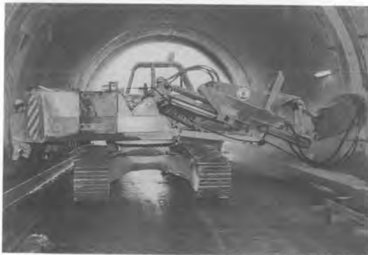
写真-5 トンネル現場実験
