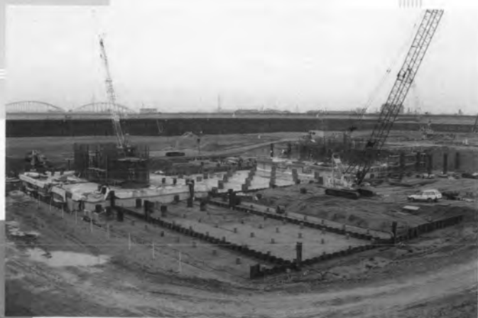
↑堰柱床版コンクリートの打設
