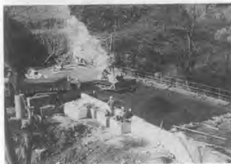
写真-2 上流締切試験施工状況
