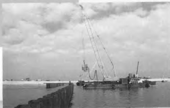
←仮締切矢板の打設
