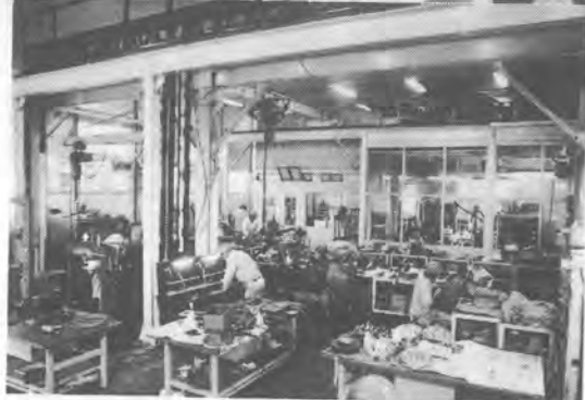
▲油圧ポンプ、モータ、バルブ整備工場
