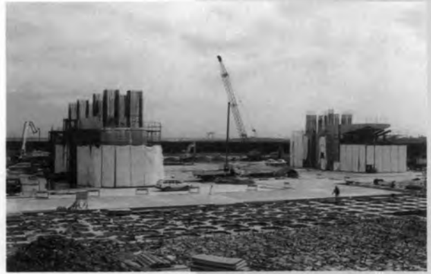
↑堰柱及び護床工の施工
