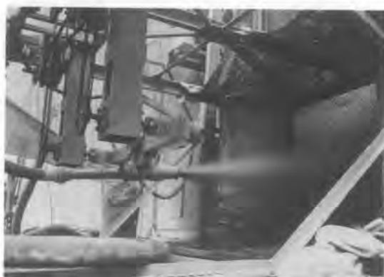
写真-2 「モルタルショット」による作業状況
