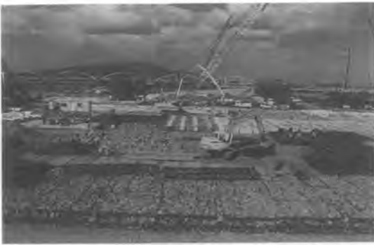
写真-3 護床工施工状況
