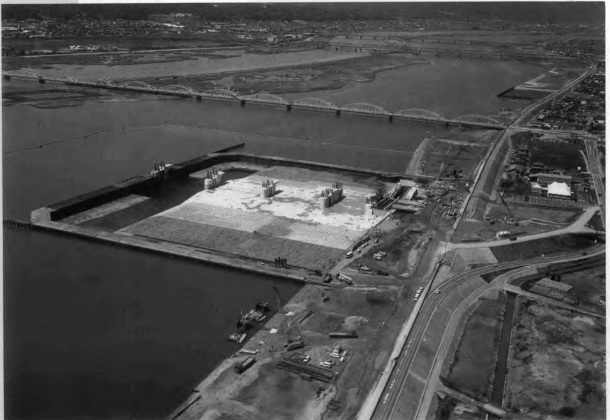
↓締切内工事完了
