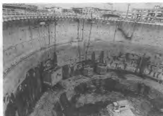
写真-4 東京ガス根岸工場 TL-22 地下タンク作業所の工事状況。掘削壁面で3種類のロボットが作業している。(右からメッシュセッタ、モルタルショッタ、ロックボルトセッタ)
