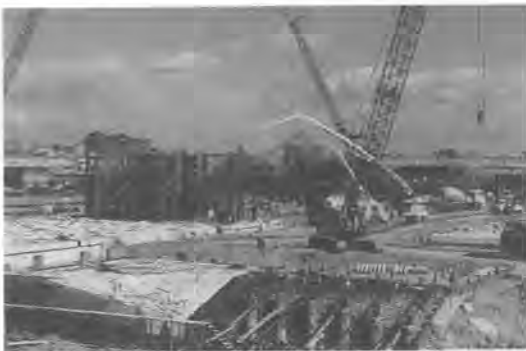
写真—2 戸当たり架台設置状況
