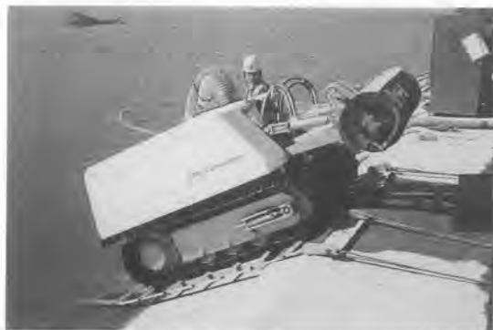
写真—1 堆積土砂処理機（14 m 3 /hr）
