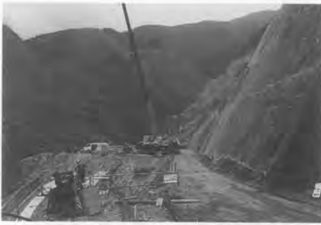
写真—3 原石山（正面）に向かう工事用道路
