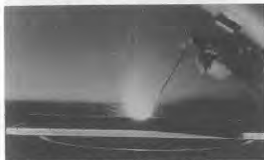
写真-2 本溶接システムの火花発生状況
