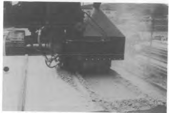
写真-6 ダムコンクリート切削実験
