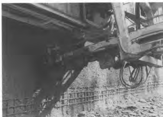
写真-3 「ロックボルトセッタ」による作業状況 (削孔)
