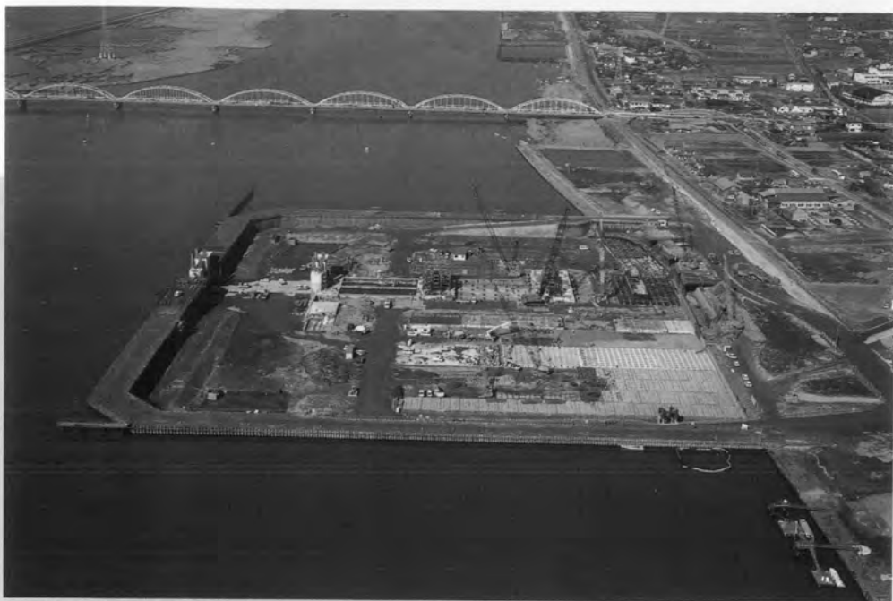
↑第2ブロック工事状況
