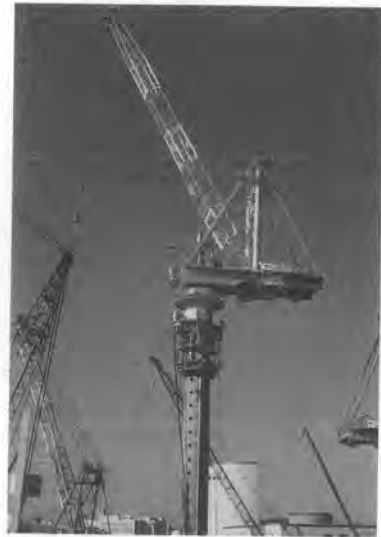
写真-5 1500 H タワークレーン
