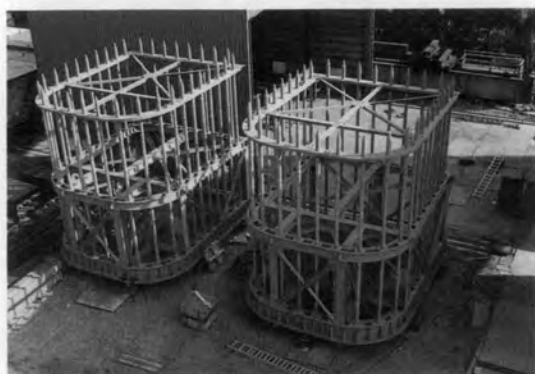
⇨主塔アンカーフレーム据付
