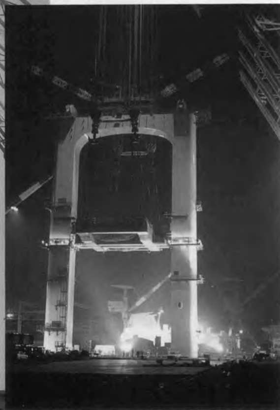
◆主塔上段大ブロック浜出し
