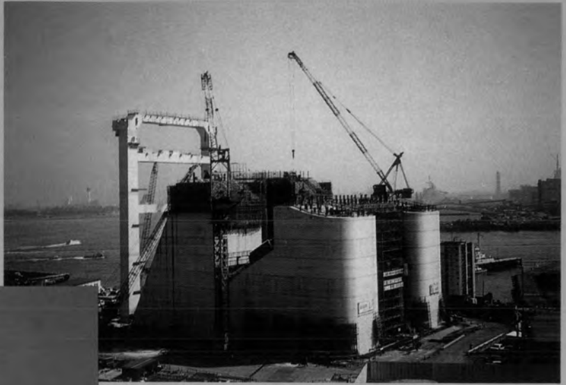
側塔及びケーブルアンカー フレーム架設完了
