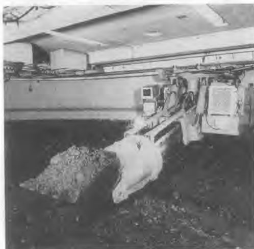
写真-16 天井走行式函内掘削機
