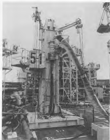
写真-4 打設管引揚装置 (配管径はφ200)
