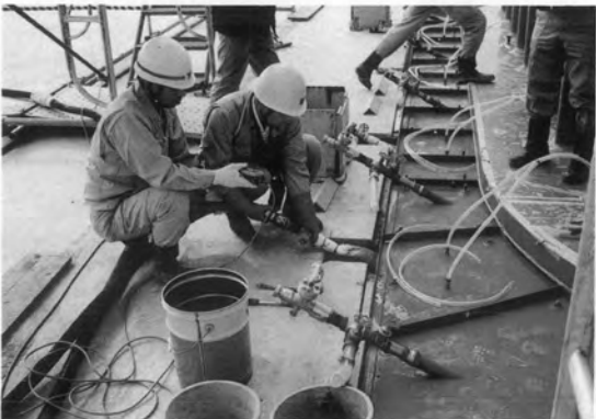
⇨ 主塔底板下グラウト注入
