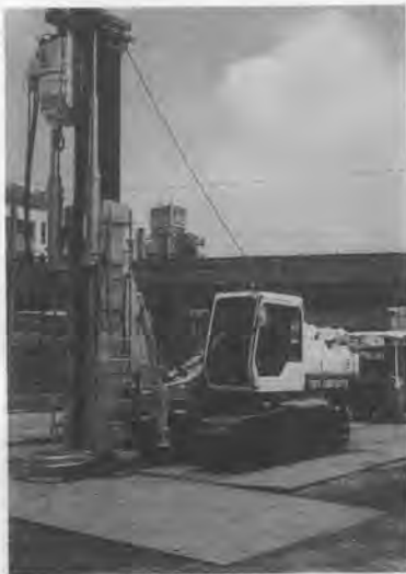
写真—12 リーダ部“伸”状況
