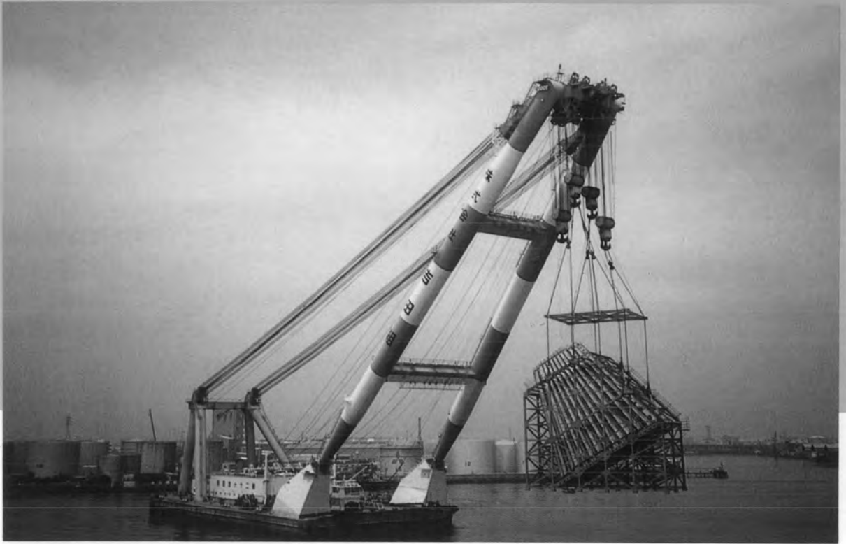
⇨ ケーブルアンカーフレームつり曳航
