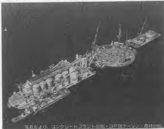
写真-1 大型高性能コンクリートプラント船（左からコンクリートプラント台船、3P鋼ケーソン、資材台船）
