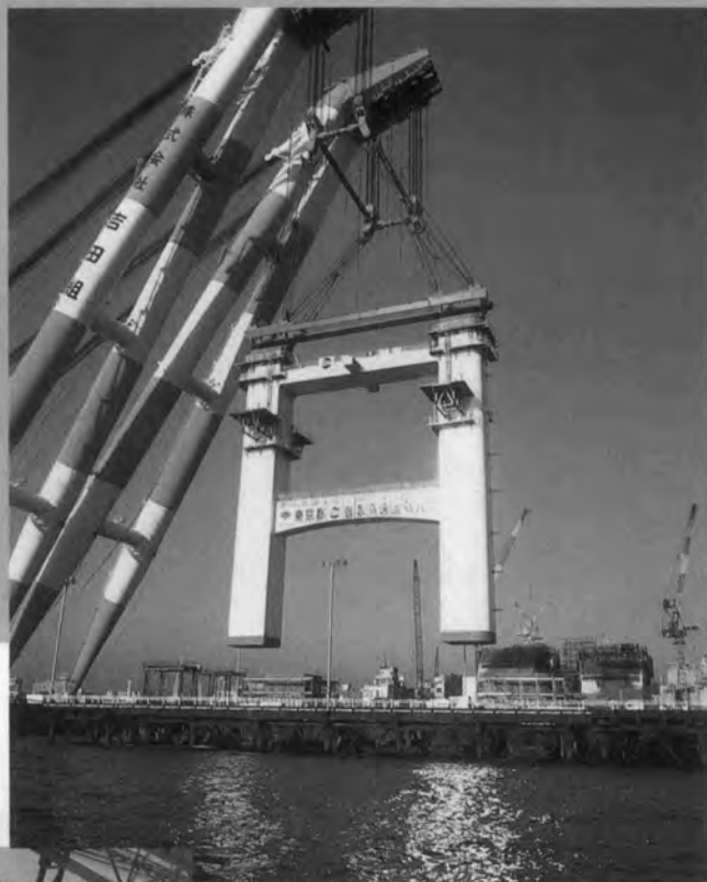
◆中段大ブロック架設
