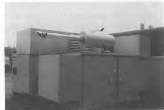
写真-3 共鳴型サイレンサ HSB 型と FOB 型
