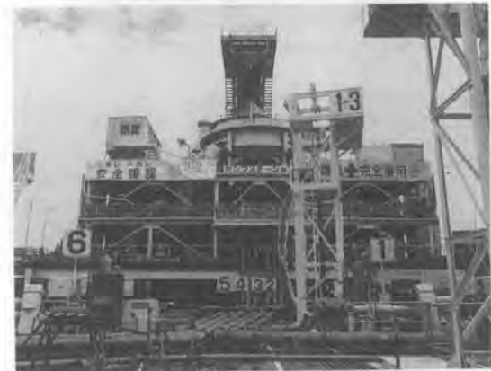
写真-3 ケーソン上のポンプステーション（最上部がアジテータ、その下部にコンクリートポンプ）
