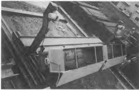
写真-30 横転式トラバサ運転状況
