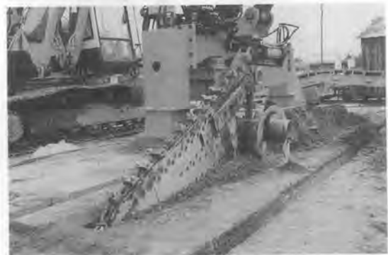
写真-3 チェーンカッタ式薄溝掘削機
