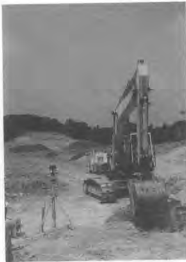
写真-2 レーザパワーショベル
