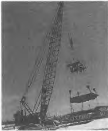
写真-10 定点転倒式揚土ベッセル
