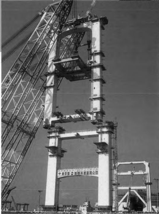
主塔上段大ブロック架設
