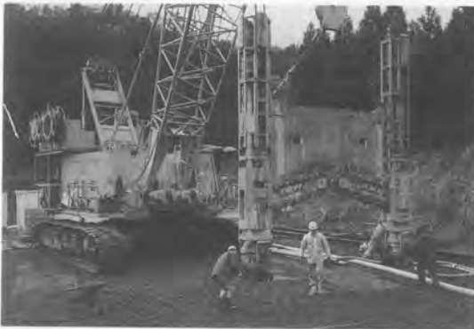
写真-13 薄型止水壁掘削機
