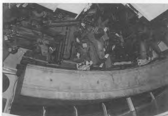
写真-6 RCセグメントAB型 1ピース7.4t 自動組立機, 把持装置
