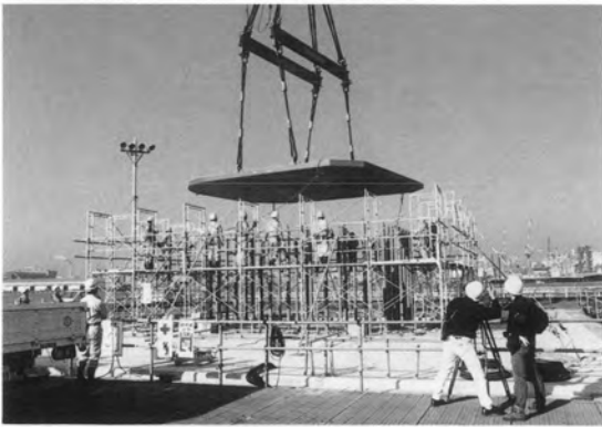
⇨ 主塔底板据付
