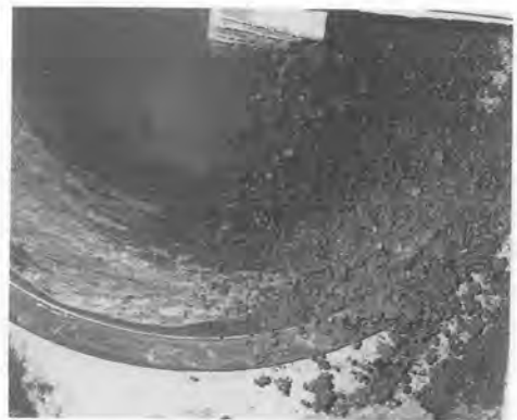
写真-31 攪拌・混合状況
