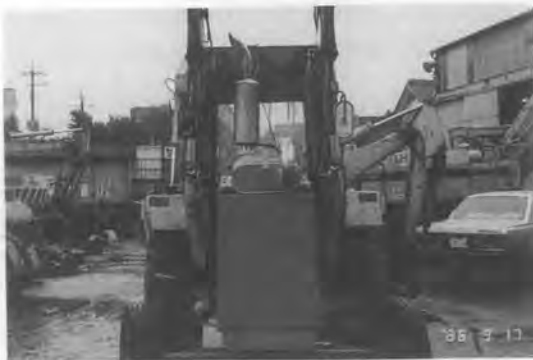
写真-1 吸音型サイレンサ KDE 型と W3Z 型
