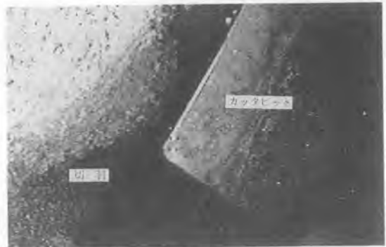
写真-27 カッタビットと切羽の状態
