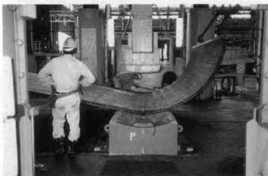
⇨主塔曲線部鋼板曲げ加工
