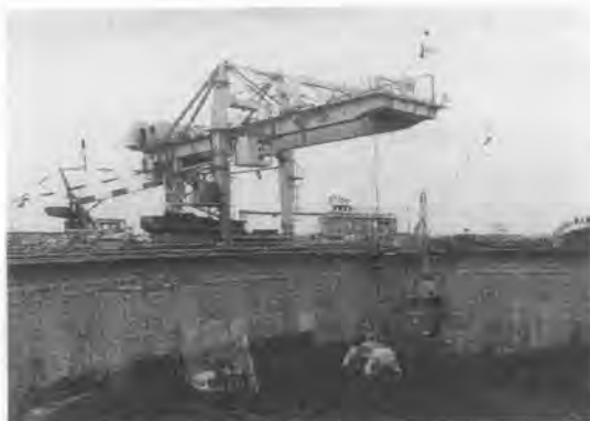
写真—9 高性能揚土システムの稼働状況
