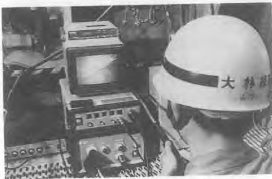
写真-26 シールド切羽監視システムによる隔壁前方の観察状況
