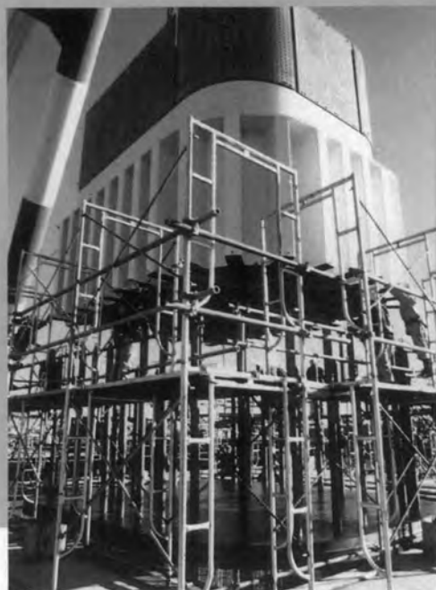
◆主塔基部ブロック架設
