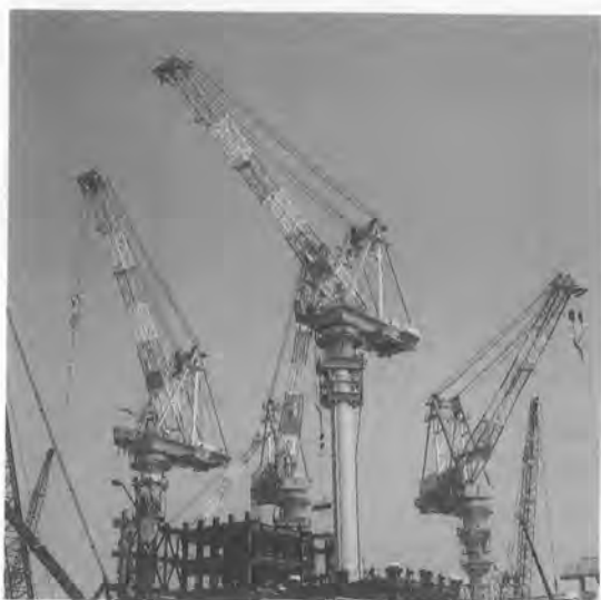
写真-2 タワークレーン
