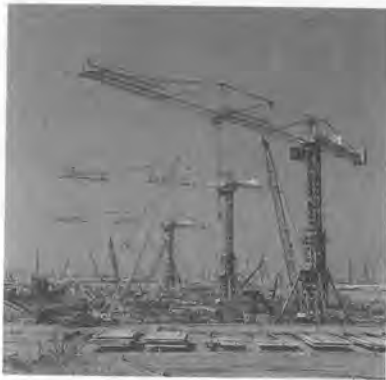
写真—8 大型水平ジブクレーン JCC 500 T
