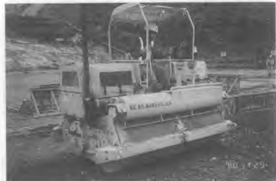
写真-40 RCDダム重機稼働管理システム稼働状況
