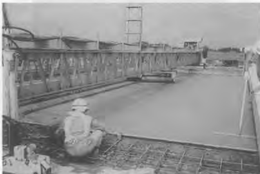
写真—32 コンクリートローラフィニッシャ C450
