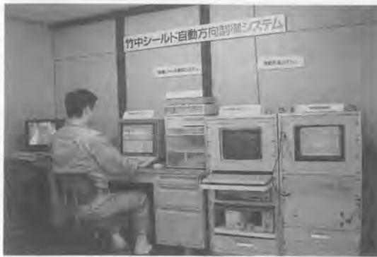
写真-4 計測室全景
