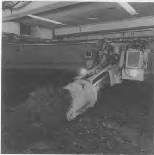
写真-2 稼働中の掘削機
