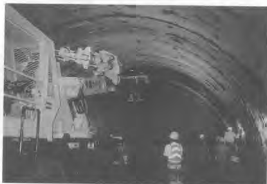
写真-3 支保工の建込作業
