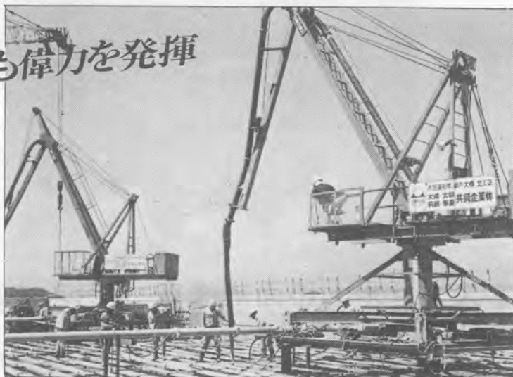
(本四架橋現場設置例)
