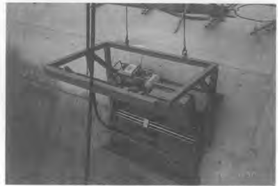
写真-38 堤体上下流面清掃機
