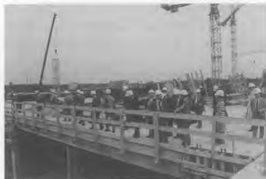
写真-3 フランクフルト空港増設工事現場視察
