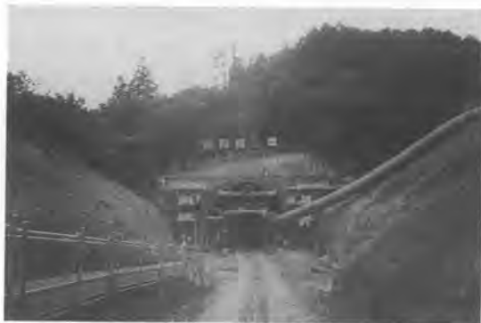
写真—1 坑口付近全景
