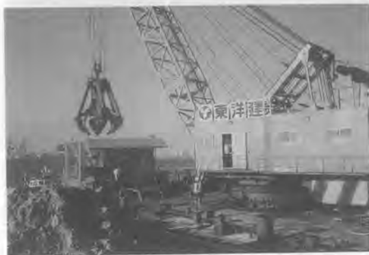
写真—47 テレスコピックトレミ式捨石投入船
