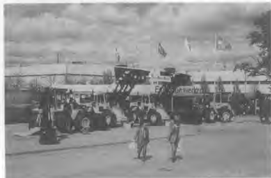
写真-4 VME エスキルチューナ建機工場
