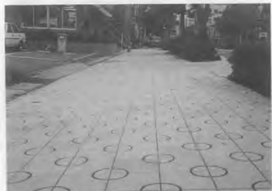
写真-2 降灰ブロックにより舗装された歩道
