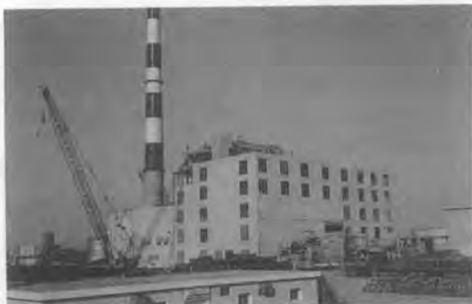
写真-1 完成間近の火力発電所
