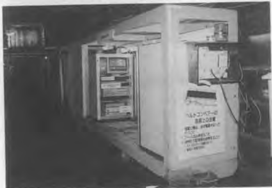
写真-3 坑内の計測台車
