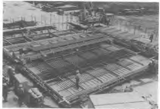
写真-1 作業状況
