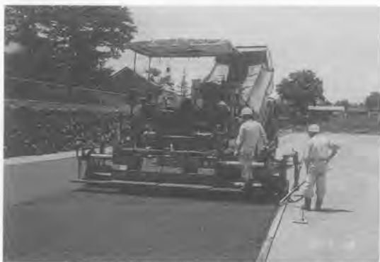
写真—45 新型アスファルトフィニッシャー
