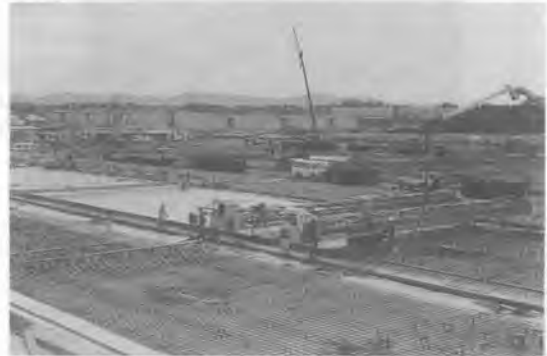
写真—33 コンクリート打設システム C450
