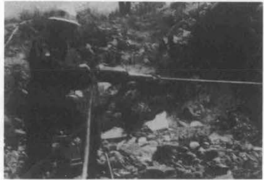
写真-4 ジャックレグ削岩機
