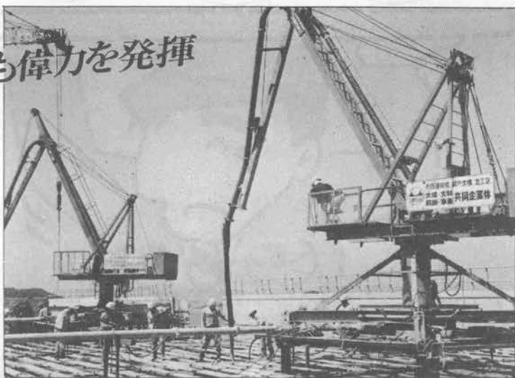
(本四架橋現場設置例)
