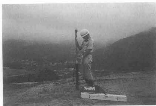
写真—3 盛土管理工傾斜計測定状況
