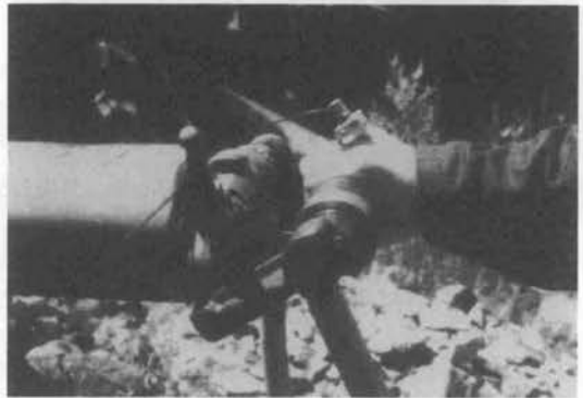
写真-5 X方向(一)加速度計の取付状況
