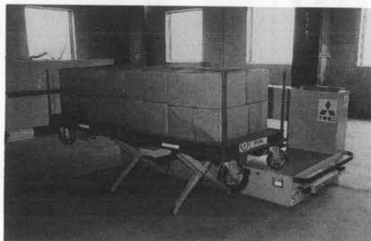
写真-5 (2) 積み卸し作業中の自走台車 (清水建設・三菱重工業)
