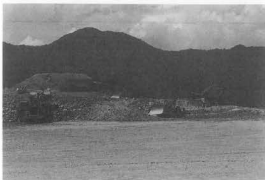
写真一2 切土工積込状況 D11N 992C 777 PC 1000 465
