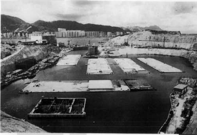
⇨ ドックから水路への沈埋函移動
