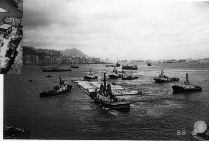
⇨ 沈埋函係留地への曳航
