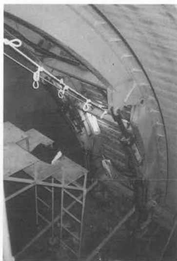
写真-7 CLip セントルシステム覆工仕上り状況
