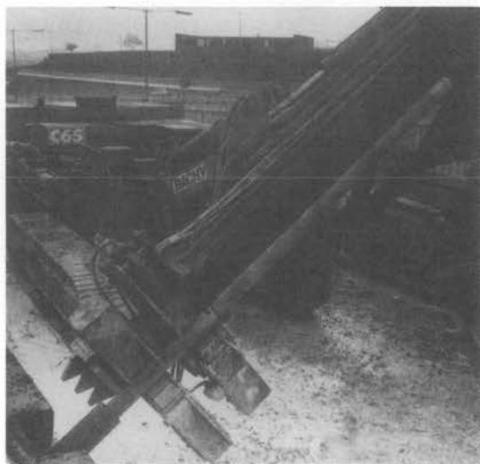
写真一 地中アンカー用削孔機
