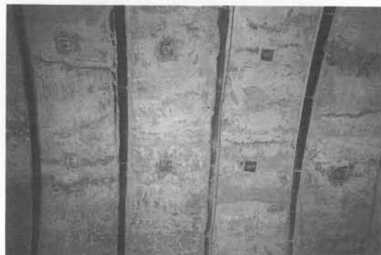
写真-6 SPL 覆工仕上り状況
