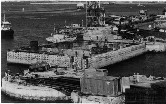
⇨ 圧縮空気を利用した九龍側ケーソン型換気塔の沈設
