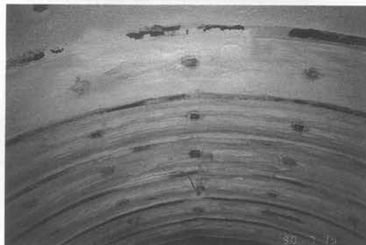
写真-8 SKL 覆工仕上り状況
