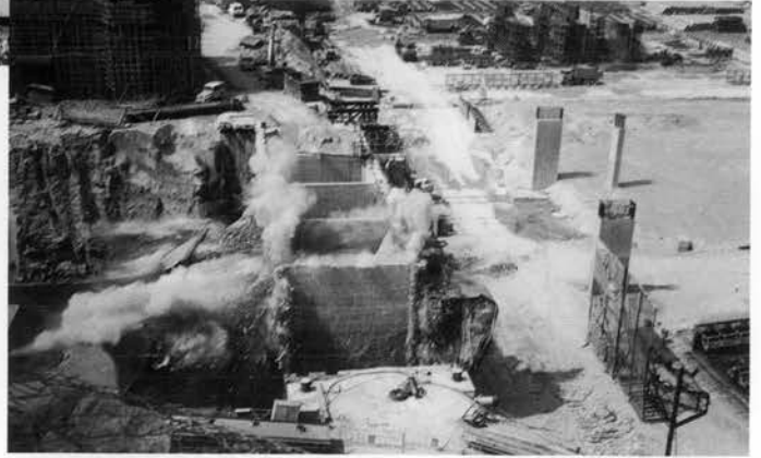
⇨ ドライドック側ゲートの発破⇨による取り壊し
