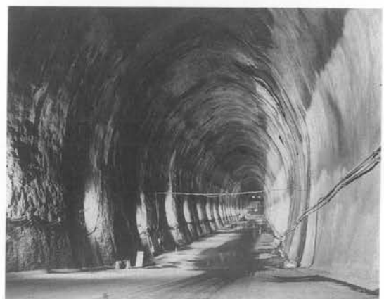
写真二 RCCP 完了後全景 (TK-102 B)
