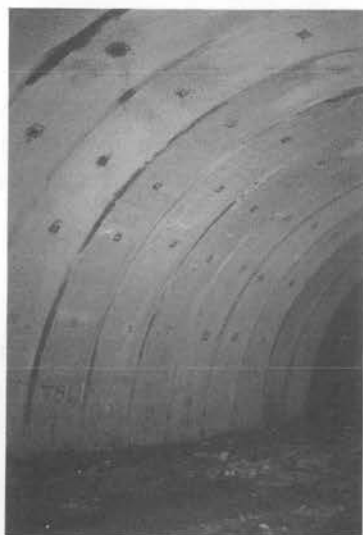
写真-5 TSL 覆工仕上り状況
