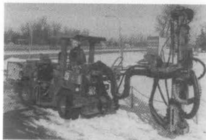
写真-4 ロックボルト打設機
