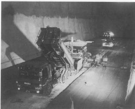
写真一 RCCP 施工状況 (TK-102 D)
