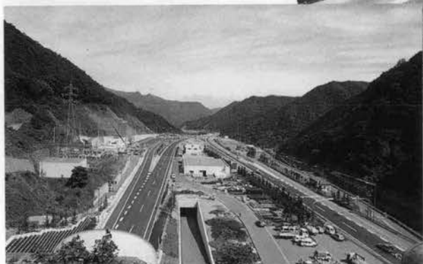
⇨ 完成後トンネル坑口より東京方面を望む (左側Ⅱ期線)
