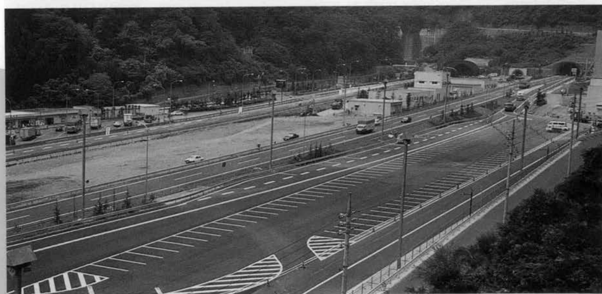
⇨ 供用中関越トンネル水上側坑口(谷川岳パーキングエリア内)
