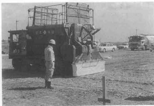
写真-8 散布機による散布状況
