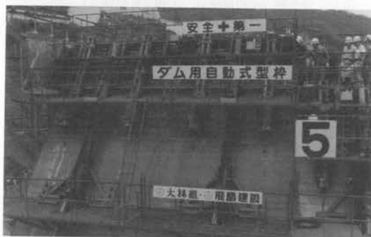
写真-1 ダム用自動式型枠 OT フォーム
