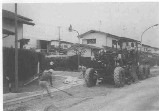
写真-9 レーキを用いた人力散布状況
