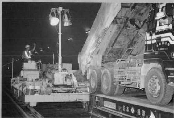
⇨ ターンテーブル兼ダンプアップ台 およびボックススレッダ
