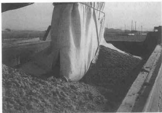
写真-6 ダンプトラックへのバラ積み状況
