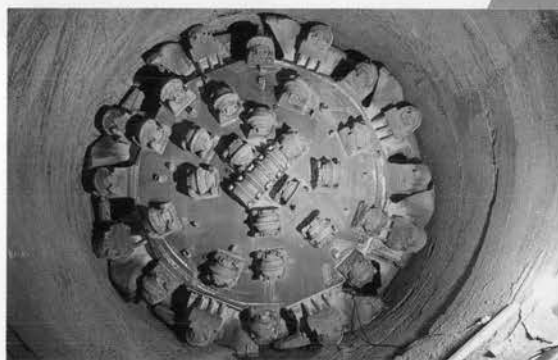
掘削完了後の後退作業
