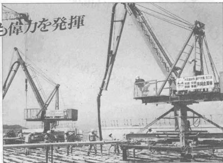
(本四架橋現場設置例)
