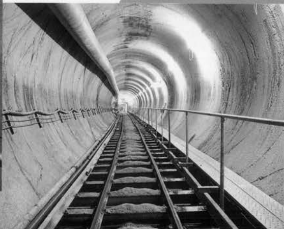
支保工のない区間
