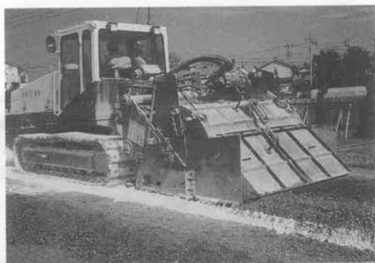
写真-10 ロードスタビライザによる混合状況
