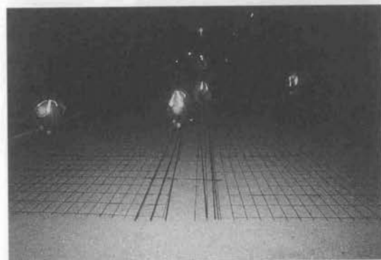
写真-3 鉄網・補強鉄筋の配置
