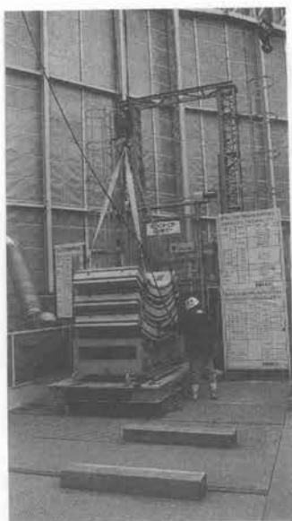
写真-6 積込状況
