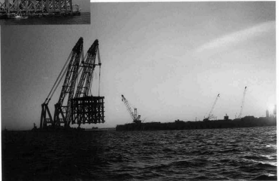
⇨ ⇨ 川崎人工島 鋼製ジャケツト設置
