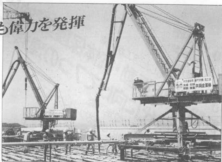
(本四架橋現場設置例)
