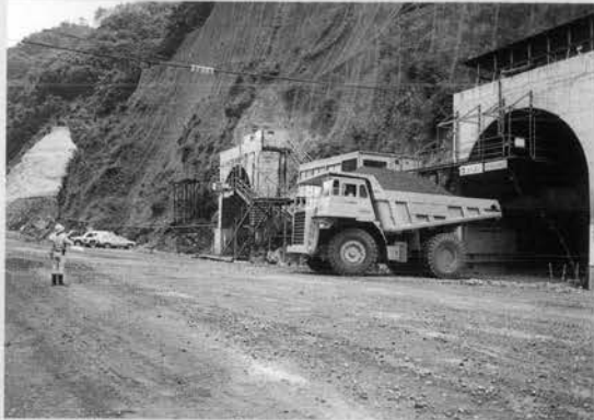
⇨ 立坑方式による原石の搬出
