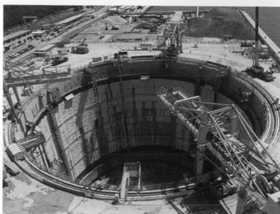
⇨ 内部掘削が完了した1A
