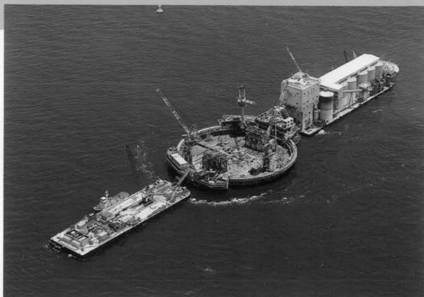
⇨ 気中コンクリートの打設が進む2P 中央が2P、右側がコンクリートプラント船 (24,000 t ), 左側が資材台船(12,000 t )
