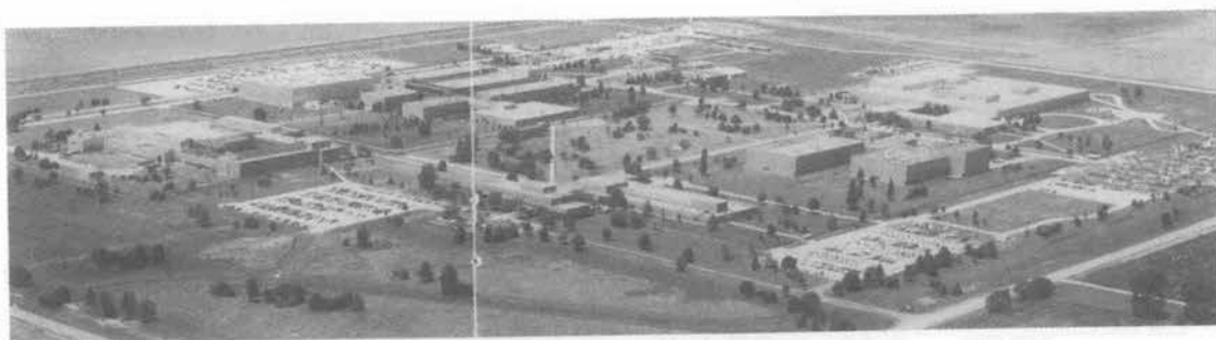
写真-1 テクニカルセンタ全景
