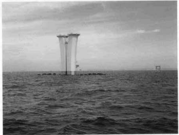
⇨ 木更津側橋梁橋脚
