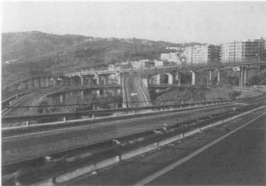
写真-16 太陽道路ナポリインターチェンジ
