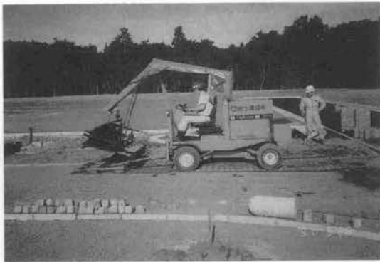
写真-11 目地砂充填
