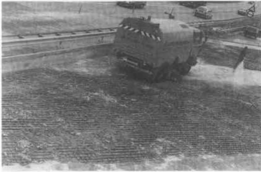
写真-15 太陽道路の部分補修状況（片側車線約300mにわたって施工中）
