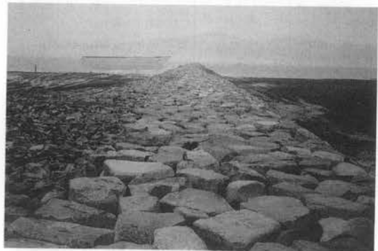
写真-6 潮受堤防A区間
