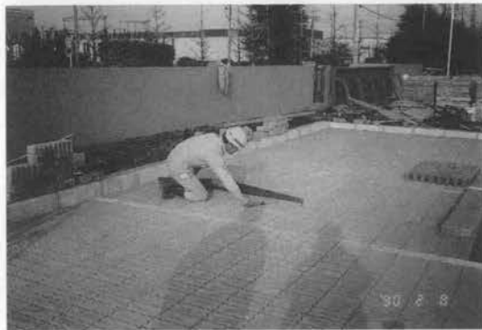
写真-12 仕上がりの確認
