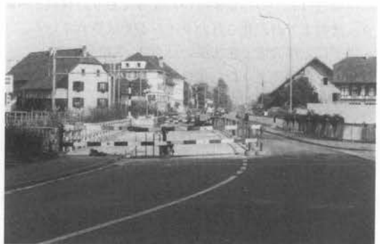
写真-17 トリノ市街地道路橋の補修現場
