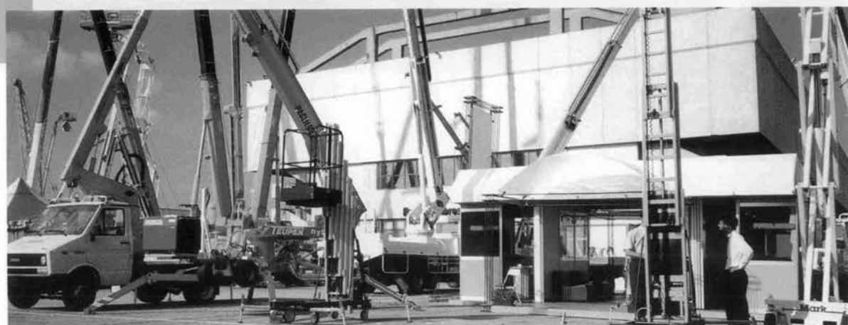
林立するクレーン車と高所作業機械
