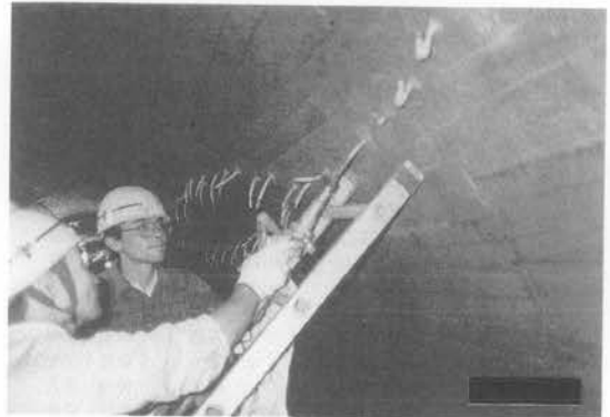
写真-1 高粘度接着剤の注入
