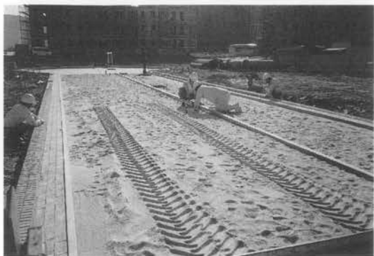
写真-5 型枠セット
