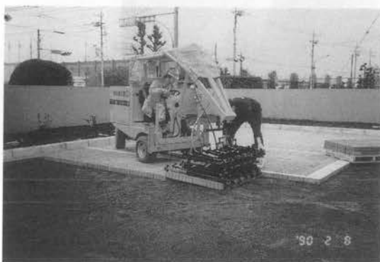
写真-9 ブロック敷設
