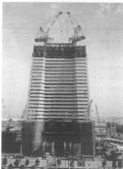
写真-1 ランドマークタワー建設工事
