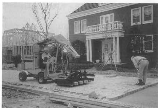
写真-10 ブロック敷設と目地調整
