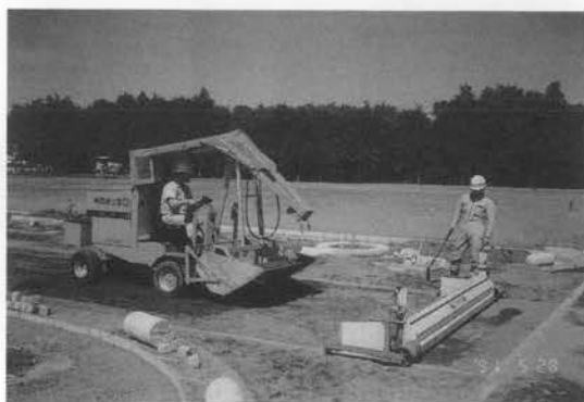
写真-8 カッティングスクリードのすき取り
