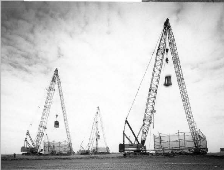
⇨ 動圧密工法による施工
