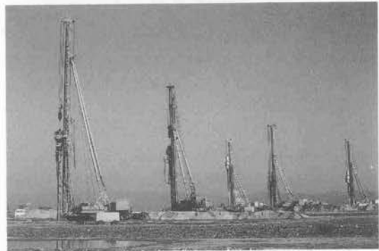
写真一1 SCPによる地盤改良
