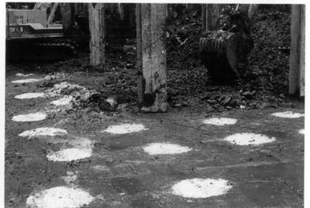
⇨ ケミコパイル掘削断面(φ40cm打設)
