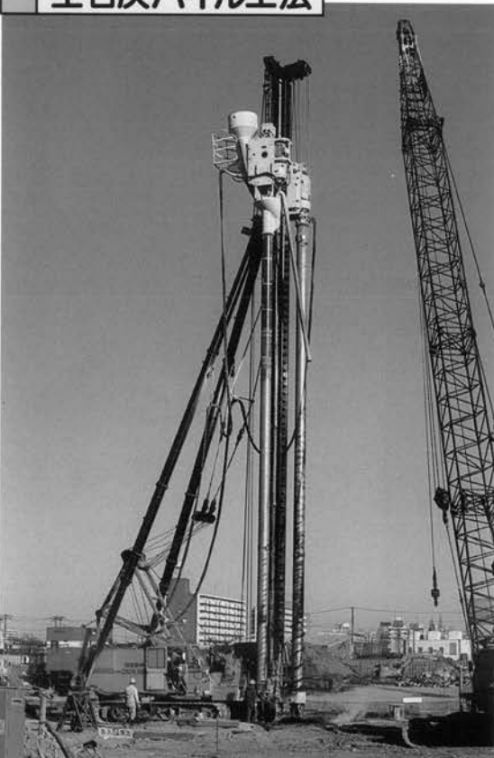
⇨ 生石灰杭打機
