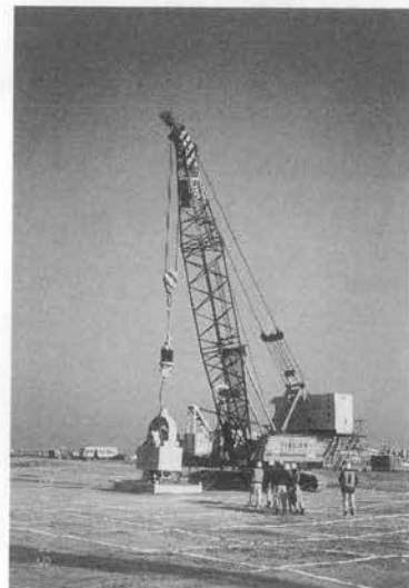
写真—3 MVTによる地盤改良
