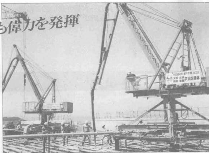
(本四架橋現場設置例)
