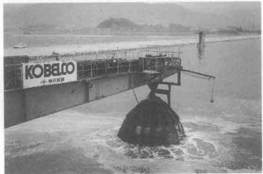
写真-1 砂撤出し状況
