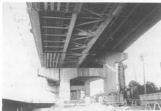
写真-1 DJM 1070 E の施工状況
