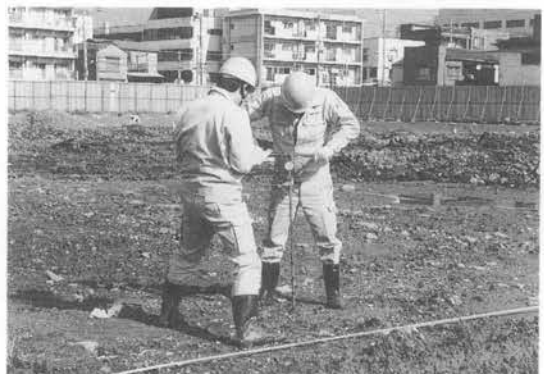
写真-1 ポータブルコーンペネトロメータ作業
