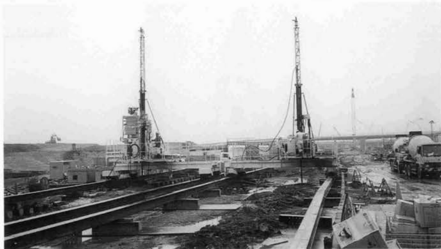
⇨ JMM工法による鋼管杭との間詰め部改良
