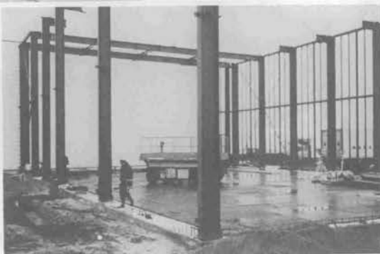
岡山市内S造高所作業車使用時、スラブ養生にゴムマット稼働。
