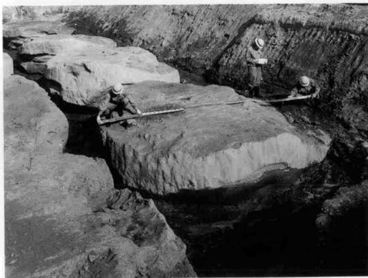
⇨ スーパージェット工法による改良体
