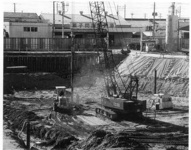
⇨ ディープパイプロ工法による施工
