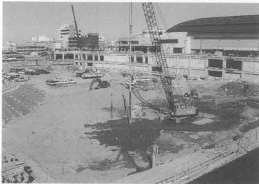
写真—1 施工状況
