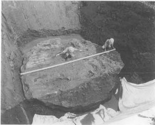
写真-2 砂質土地盤での改良体
