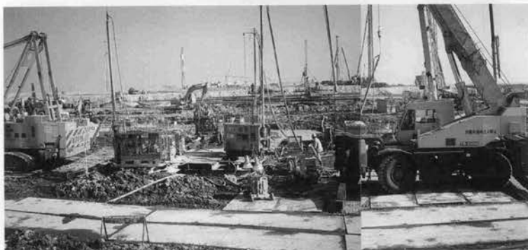
⇨ CJG工法による底板改良
