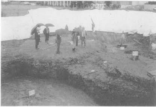
写真-1 粘性土地盤での改良体
