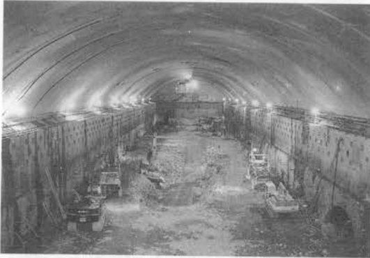
写真二 本体盤下げ掘削中
