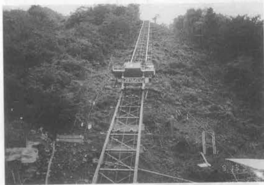
写真-4 インクラインによる運搬
