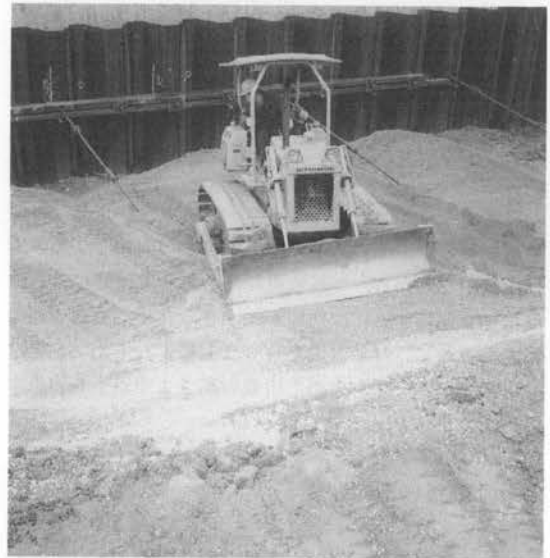
写真-1 敷ならし・転圧施工状況
