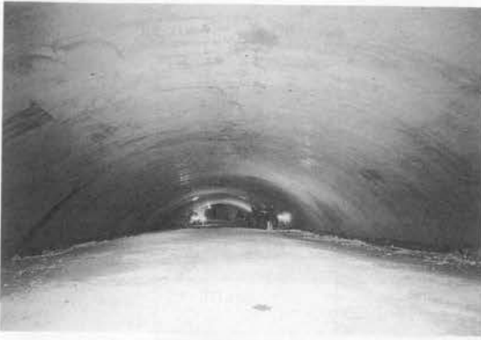
写真一 アーチコンクリート巻立完了時
