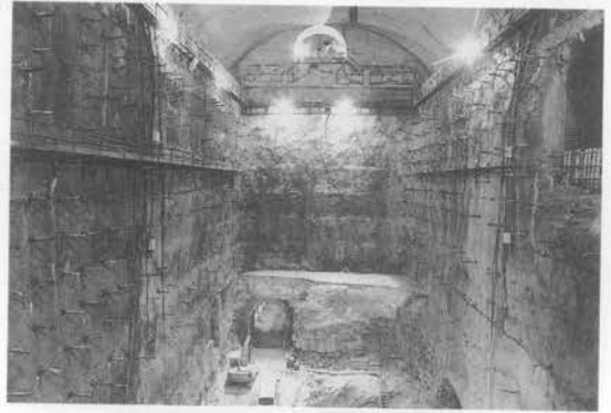
写真三 掘削完了時
