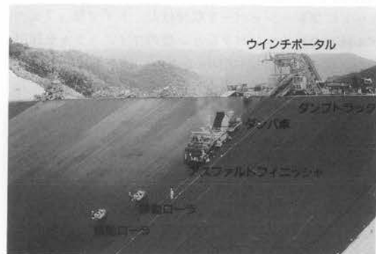
写真-2 舗設状況（下部遮水層）
