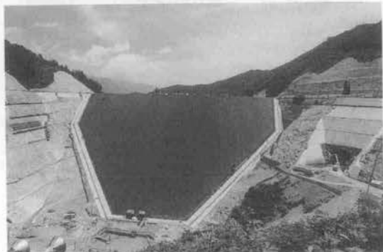
写真一 八汐ダム全景
