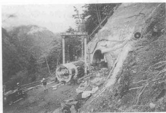
写真-5 二軒小屋発電所 TBM 現地組立状況
