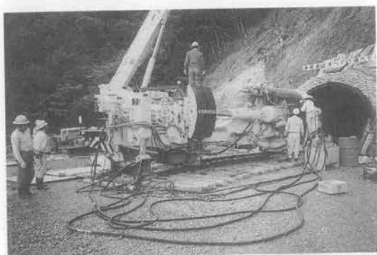
写真-3 赤石沢発電所 TBM 現地組立状況
