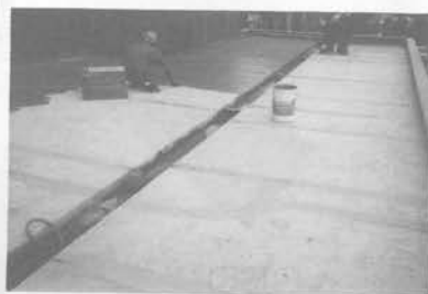
屋上防水改修
