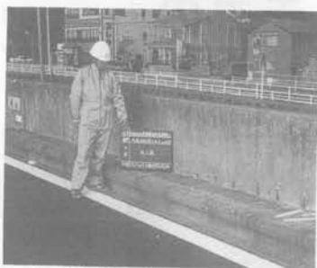
バイパス壁高欄改修
