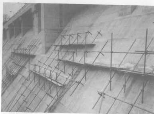
ダム水漏れ防止後の状況
