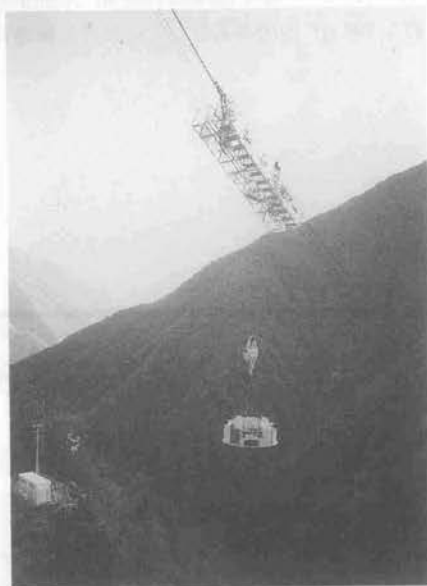
写真-6 ケーブルクレーンによる運搬
