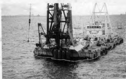
⇨ 鋼管矢板の打設
