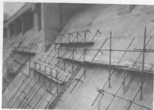
ダム水漏れ防止後の状況
