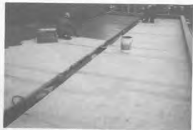
屋上防水改修
