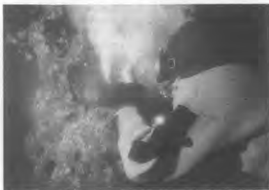
写真-2 潜水夫によるケレン作業
