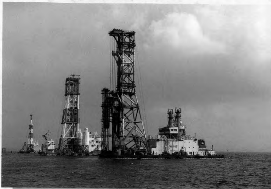
⇨ 深層混合処理船による施工(手前は「テコム5号」、後方は「DCM6号」)
