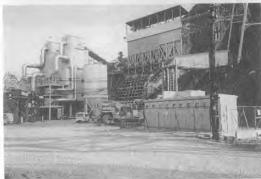
写真-4 コンパクトに纏められた仮設備群
