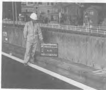
バイパス壁高欄改修
