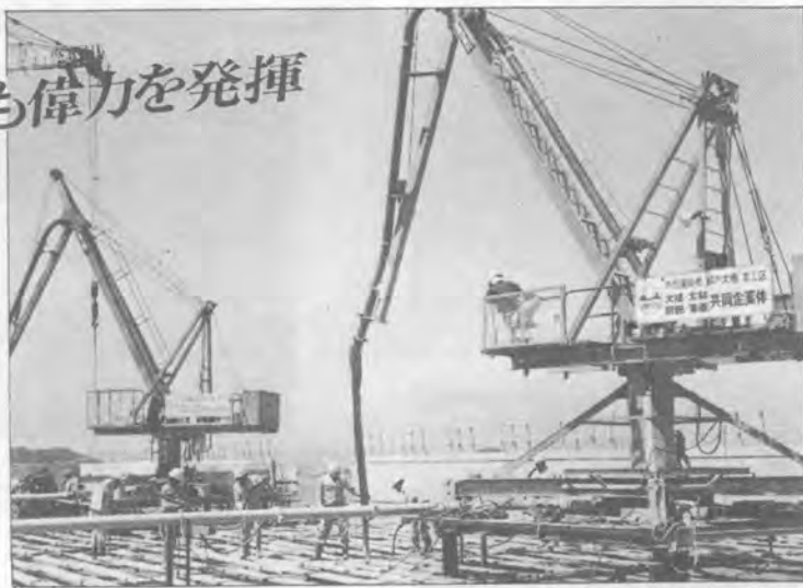
(本四架橋現場設置例)
