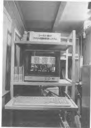
写真-1 シールド機のファジィ全自動掘進システム
