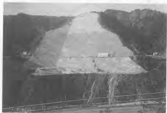
写真2 右岸から見た原石山
