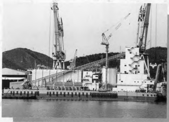
⇨ 改良盛土プラント船
