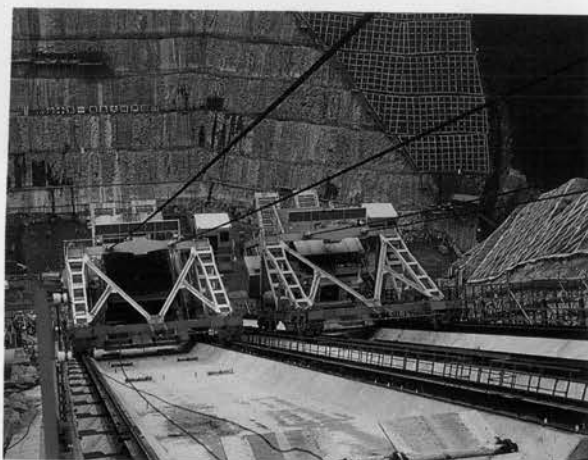
⇨ インクライン(右岸天端より打設面を望む)
