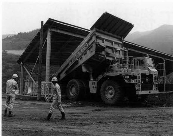
⇨ コンクリート生産設備（骨材投入ホッパへの製品骨材の投入）
