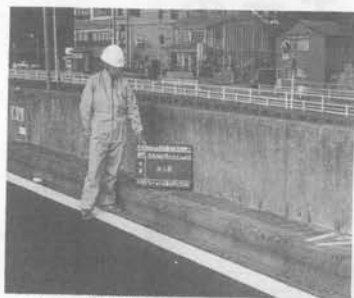
バイパス壁高欄改修
