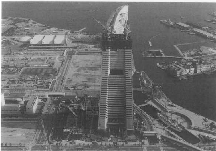
写真-4 工事中全景
