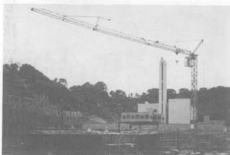
1.0t×35m(2.0t×20m) 最高自立：26m(ジブ水平時)
