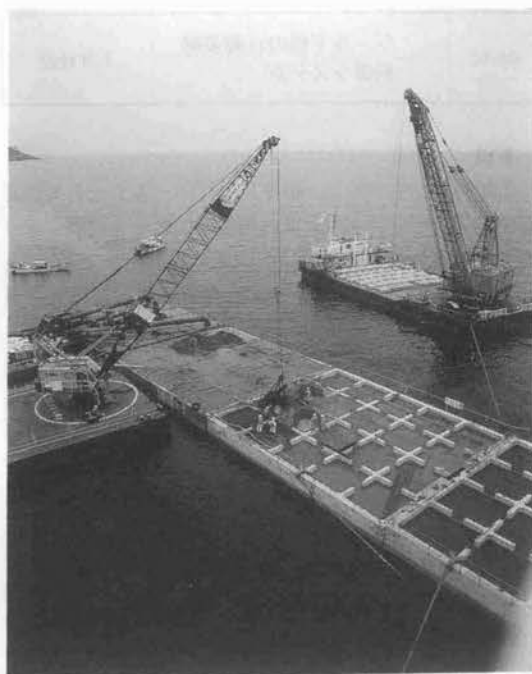
写真-1 スラリー中詰工法施工状況
