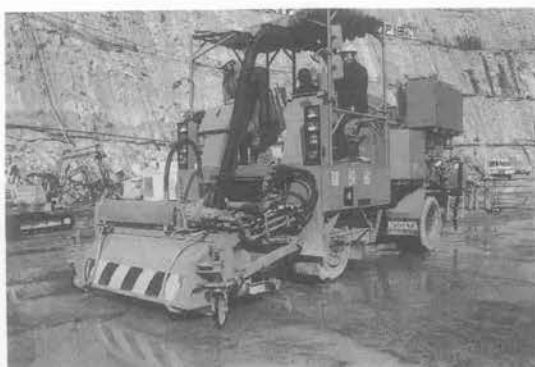
写真-5 作業中のグリーンカット機グラビア写真 No.10(共用)
