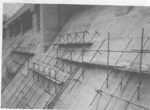
ダム水漏れ防止後の状況
