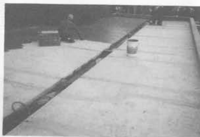
屋上防水改修
