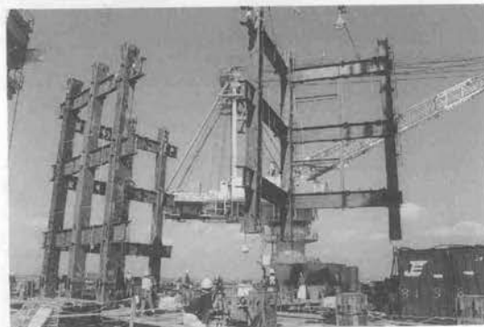
写真-3 完成ブロック建方中
