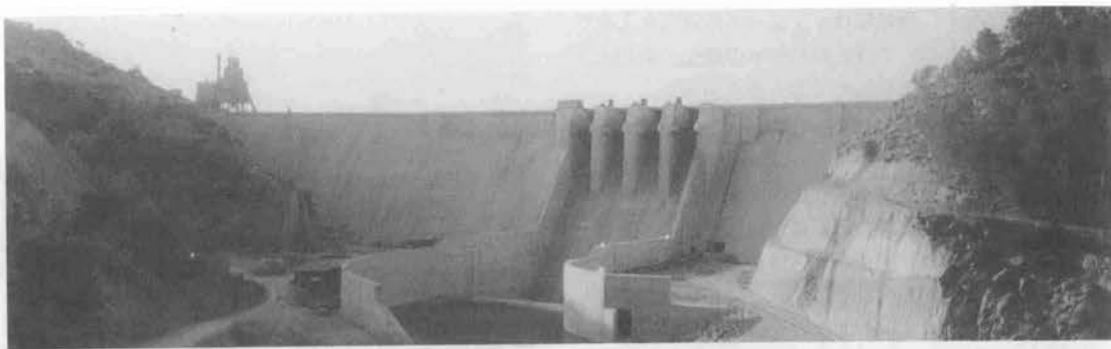
写真-1 完成間近のシェルファⅡダム全景
