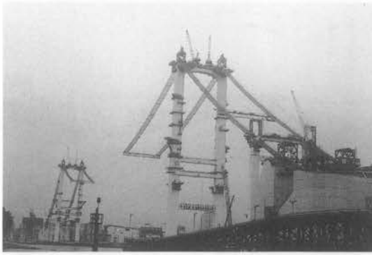
写真-3 キャットウォーク架設中
