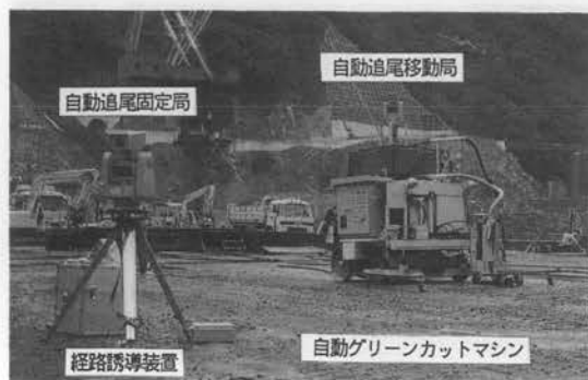
写真-3 自動グリーンカットシステム現場実験状況
