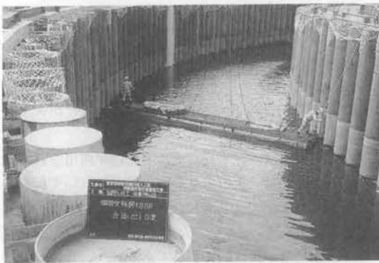
写真—4 鋼管矢板打設状況
