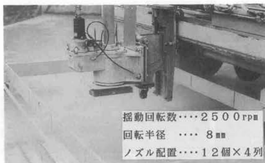
写真-2 ノズルヘッド高圧水噴射状況
