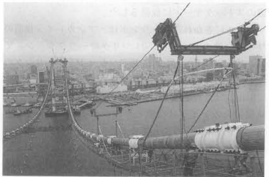
写真—11 ハンガ架設
