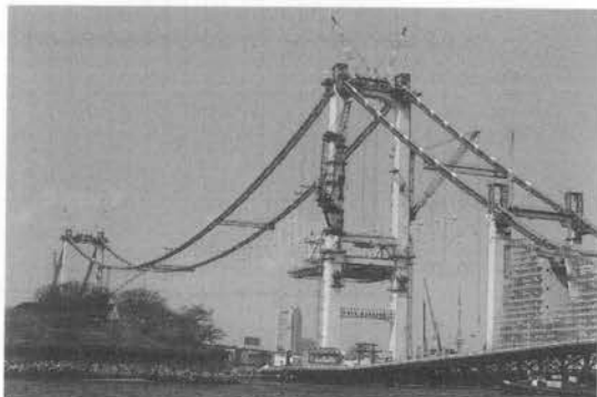
写真-1 ケーブル架設全景
