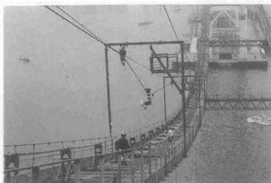
写真-5 ストランド引出し
