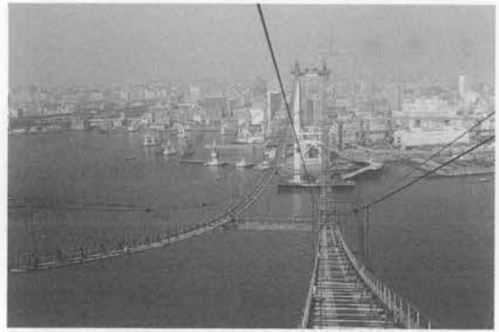
写真-4 キャットウォーク完成
