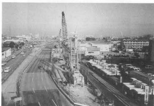
写真-12 オールケーシング掘削機稼働状況
