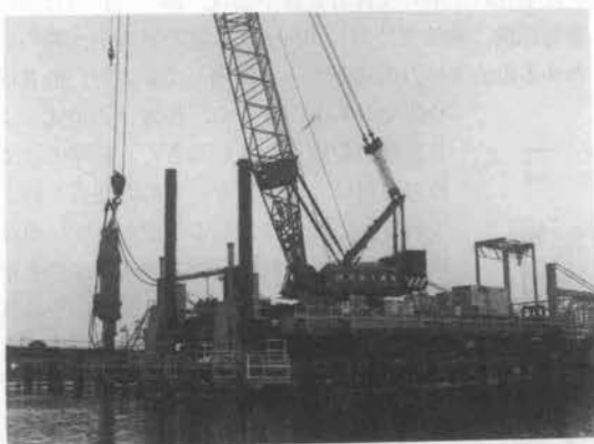
写真-3 冠水時のSTEP工法による施工
