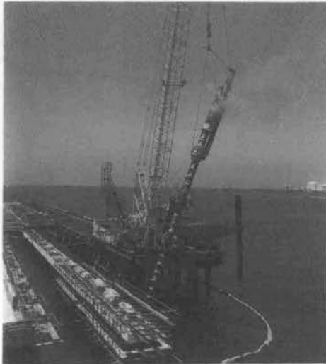
写真一2 STEP 工法全景 (千葉製鉄所)
