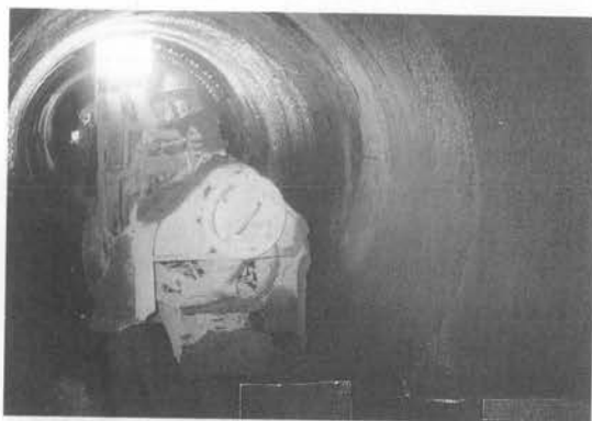
写真—33 小断面ロータリ吹付機
