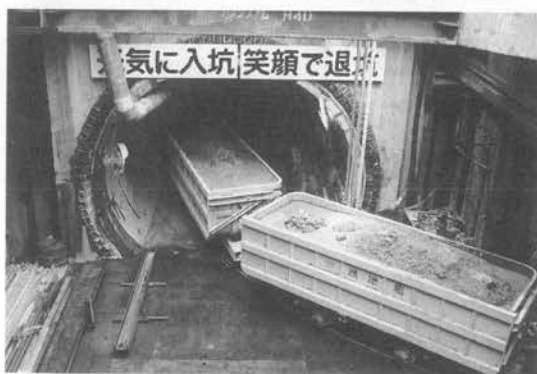
写真-2 急曲線用土砂運搬車使用状況 (泉大津シールド工事)
