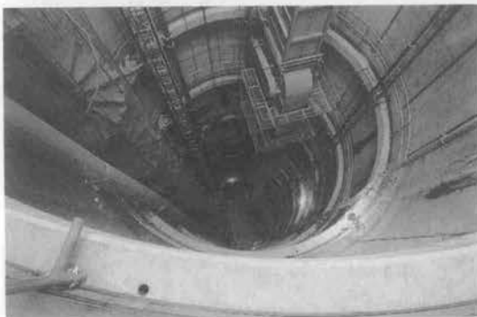
写真—22 立坑上からみた中間駆動装置
