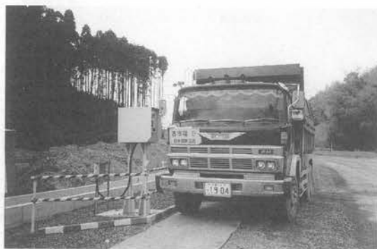
写真-3 車輛管理システム (運行状況)
