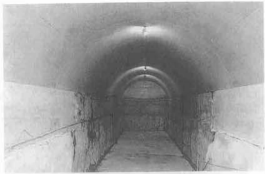
写真-3 トンネル工事完了
