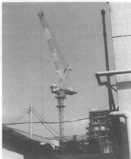
写真—7 KC-120型クライミングクレーン
