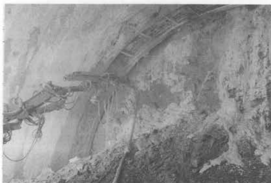
写真-6 吹付状況 (A現場)
