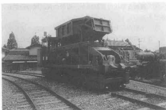
写真—5 コンクリート運搬車全景
