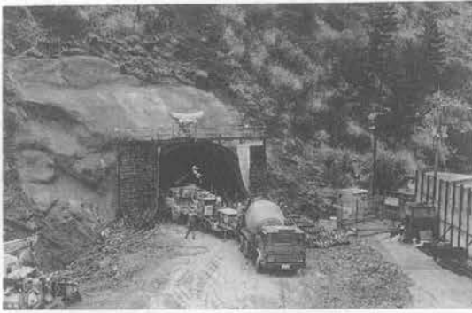
写真-2 上半施工状況
