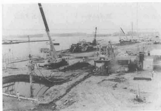
写真-1 水中埋立状況
