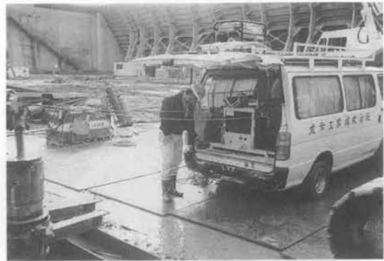
写真—15 計測状況
