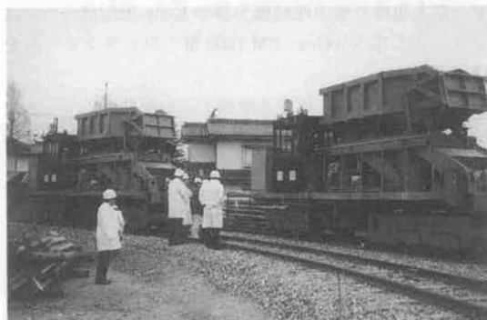
写真—6 コンクリート運搬2台工場試験
