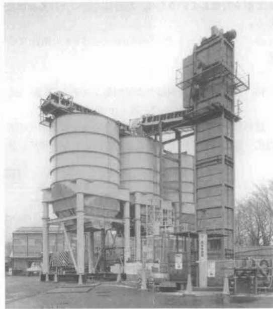
写真—23 地上部全景
