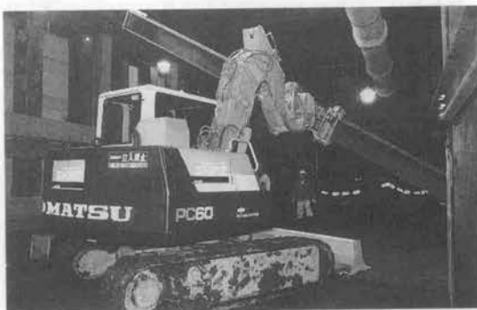
写真—10 山留鋼材ハンドリング装置
