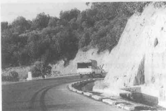
写真-3 改修の終わった舗装道路(排水側溝も仕上がっている)
