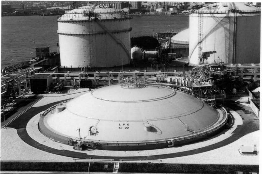
⇨ 屋根を取付け, 内外設備工事を行って完成(写真は既存のLPG地下タンク)
