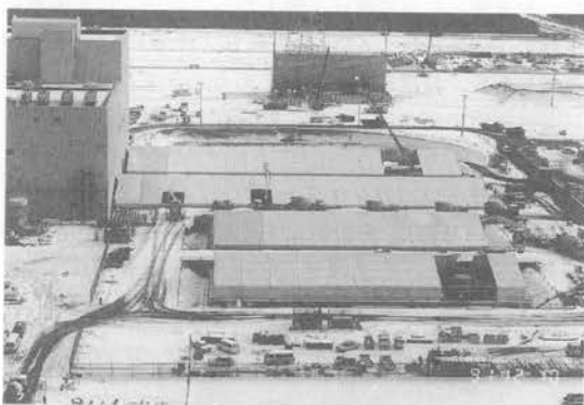
写真-58 全天候型仮設テント
