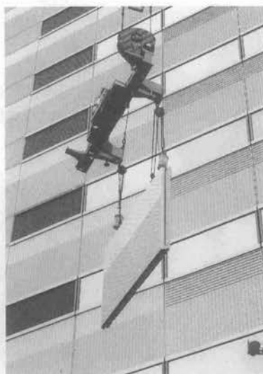
写真-50 「ノンクル」を使った PC 板の揚重作業
