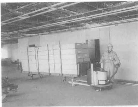
写真-54 けん引車によるけん引
