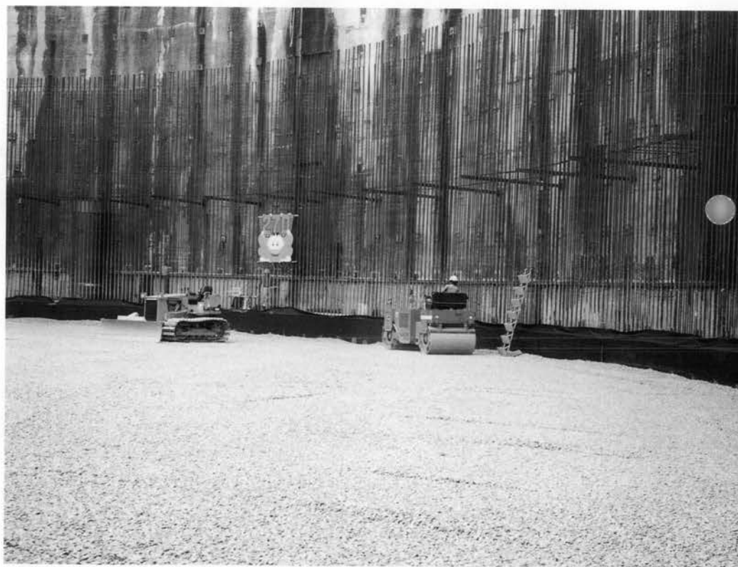
⇨ 底部排水碎石層の敷き固め
