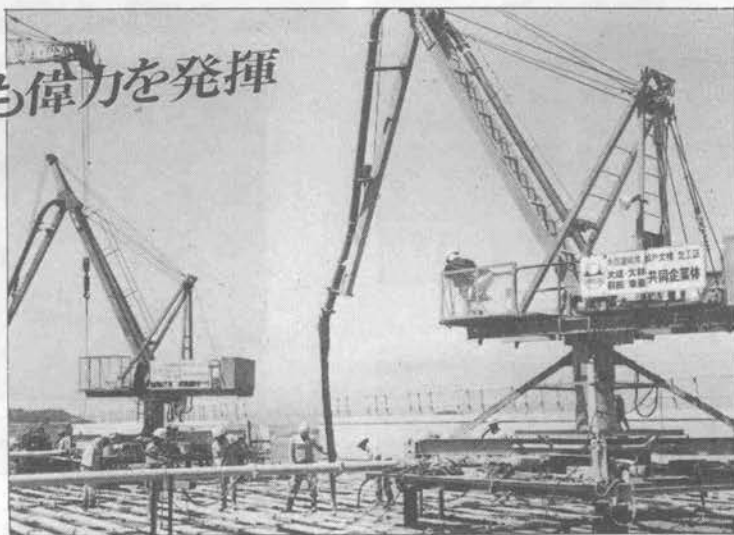
(本四架橋現場設置例)
