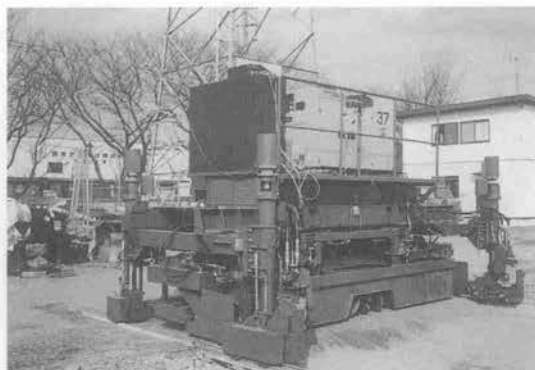
写真-42 セメントコンクリート薄層オーバーレイ施工機械
