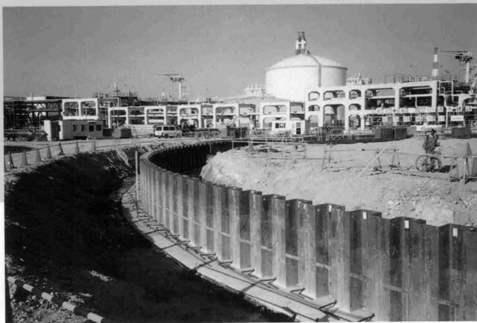
⇩ 鋼矢板の打設
