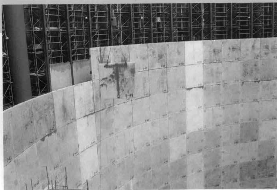
⇨ プレキャスト型枠(セグメント)の組立て
