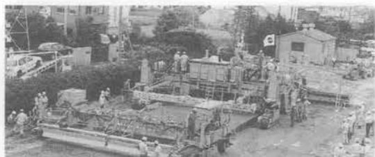
写真-41 施工状況
