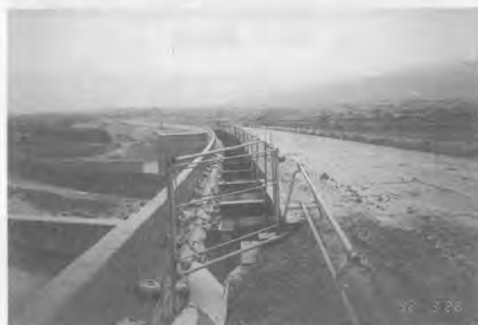
写真-7 仮設覆工を行った表川橋
