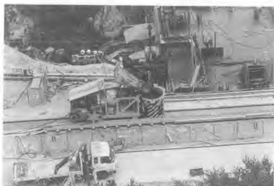
写真-3 トランスファカーによる積込み
