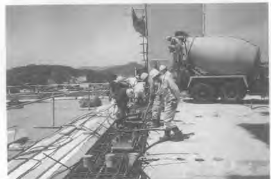
写真-1 接合部コンクリート打設
