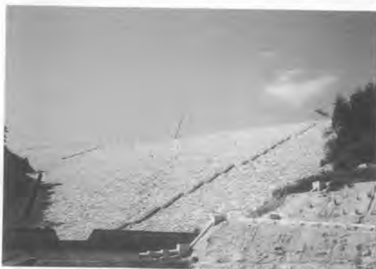
写真-3 のり面長が最大270mにも及ぶリップラップ工
