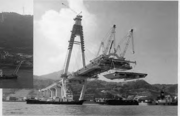
♡ 鋼桁直下つり架設
