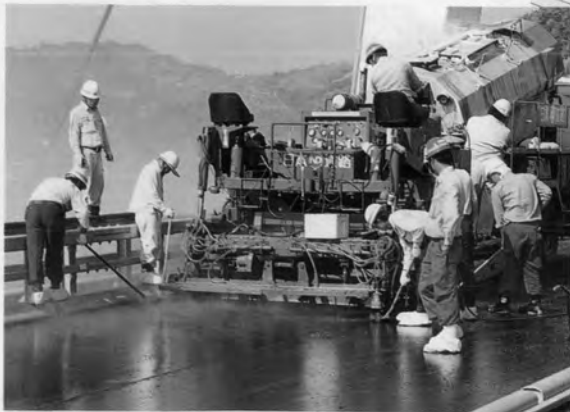
⇨ 橋面舗装 (グースアスファルト舗設)
