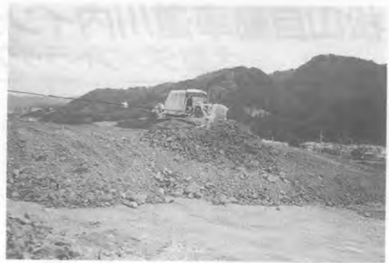
写真—4 盛土施工先端部
