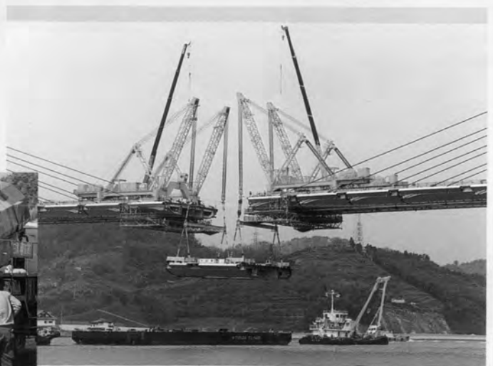
⇨ 閉合桁の架設
