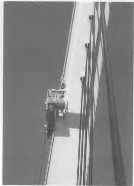
写真-6 塔作業車
