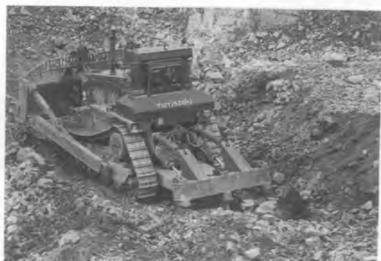
写真-4 切崩し作業を行う95t級リップラップブルドーザ
