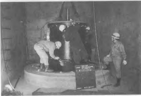
2. 主ポンプを水槽内へ
