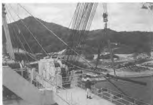
写真-4 ケーブル架設
