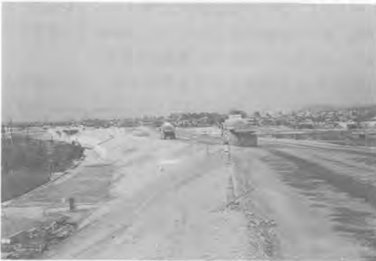
写真—3 盛土方向を望む
