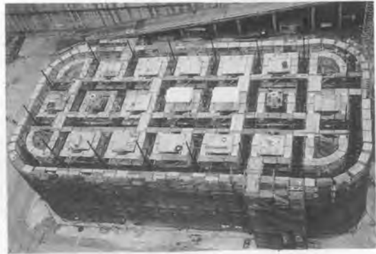
写真-6 製作中の9Pコンクリートケーソン
