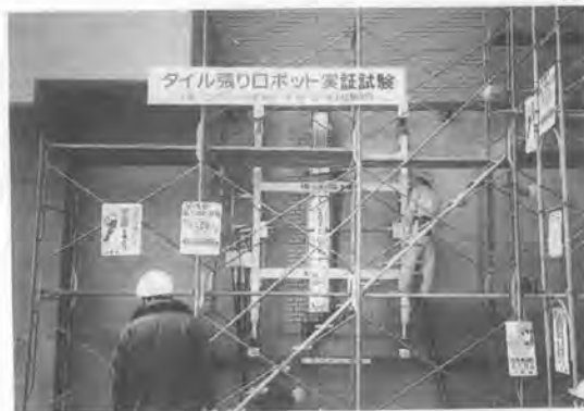
写真-1 現場試験施工状況
