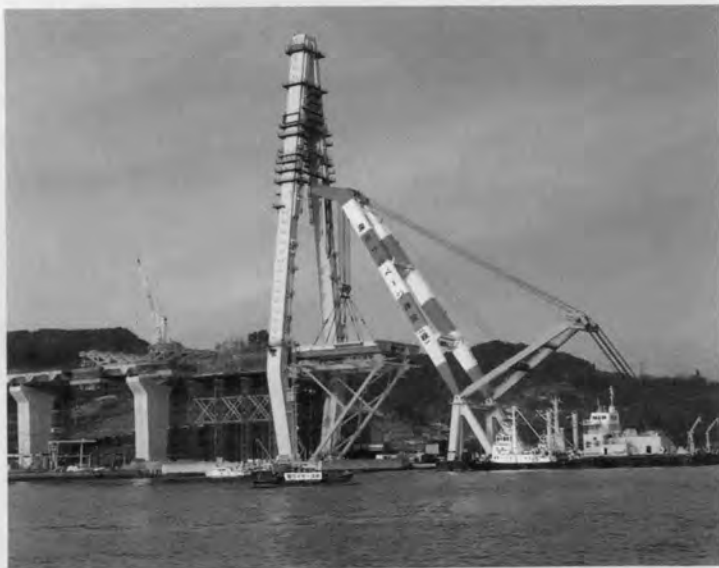
⇨ 接合桁の架設
