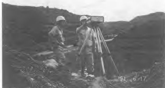
写真-1 測量用GPS受信機
