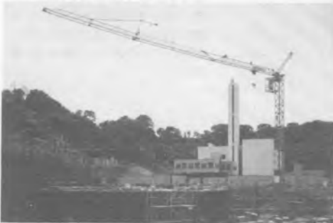
1.0t×35m(2.0t×20m) 最高自立：26m(ジブ水平時)
