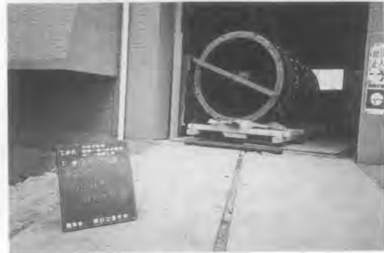
2. ポンプ本体コロ引
