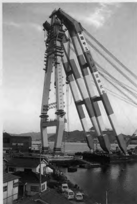
⇨ 塔大ブロックの架設
