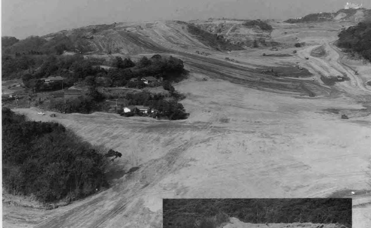
⇨ A地区施工状況
