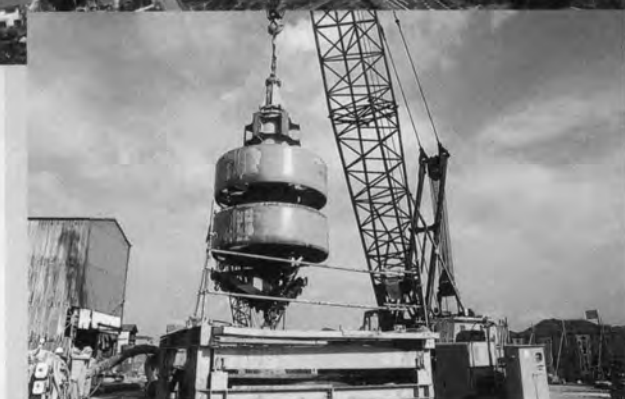
⇨ 塔基礎リバーパス杭の掘削
