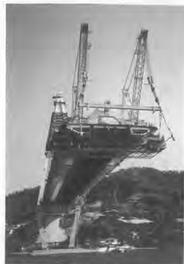
写真-2 桁架設用クレーンおよび移動防護工
