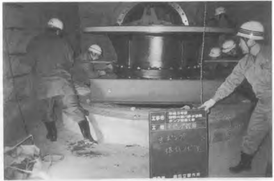
3. 主ポンプの仮止め
