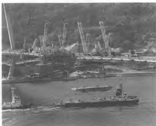
写真-3 桁直下つり架設
