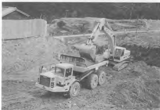
写真-10 油圧ショベルによる積込み
