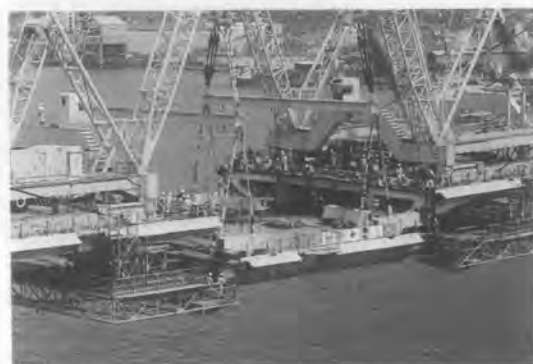
写真-5 閉合桁架設
