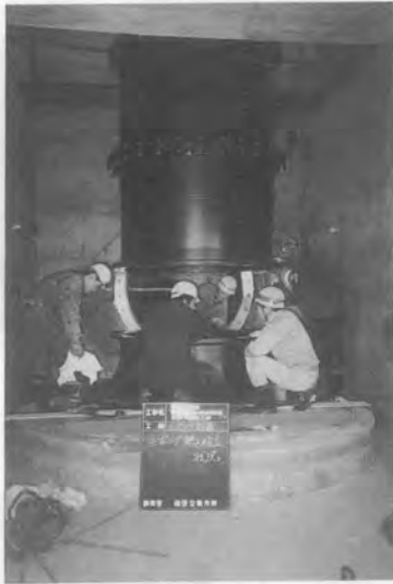
1. 吸込ベルと主ポンプ本体の接続
