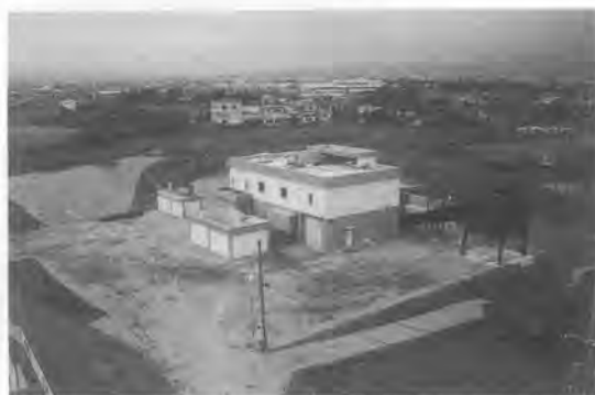
写真—2 本機場全景写真
