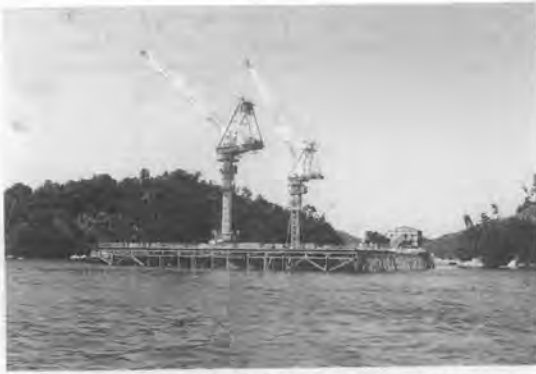
写真-4 水中コンクリート打設準備中の4A
