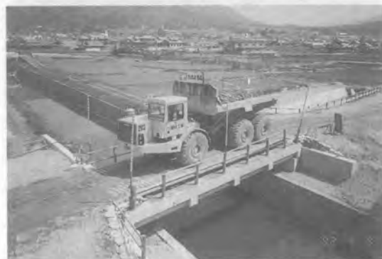
写真-6 宝泉川側道橋を渡るアーティキュレートダンプ
