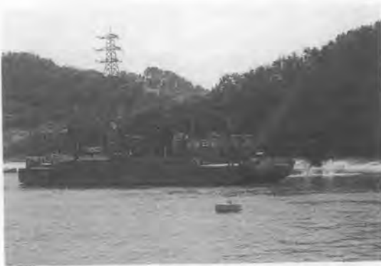
写真-5 9Pの海底掘削状況
