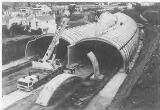
上部部材の組合せ方により、馬蹄形、楕円形など特殊なリングを作ることができる。
