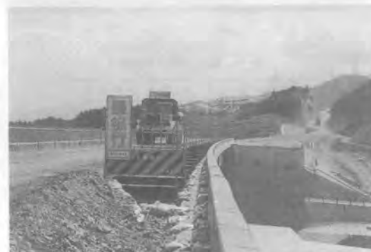
写真-8 表川橋を渡るアーティキュレートダンプ
