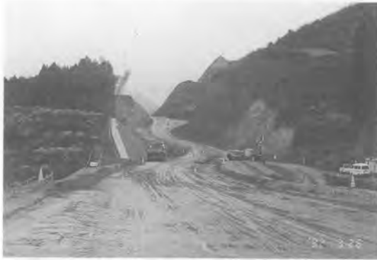
写真—2 切土施工部分
