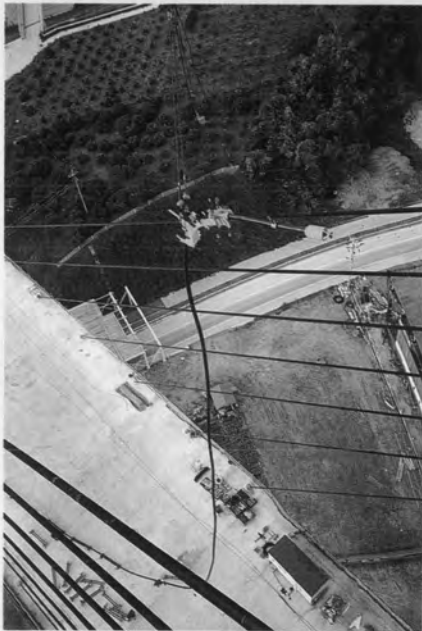
⇨ ケーブルの架設
