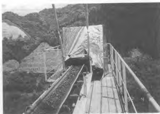
写真-3 暗室取付状況
