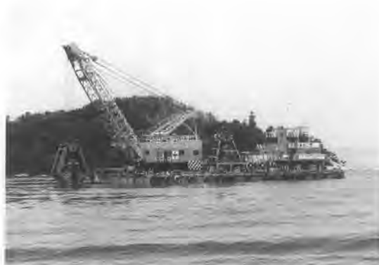
写真-3 3Pの海底掘削状況
