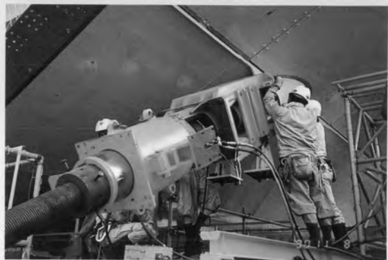
⇨ ケーブル張力導入
