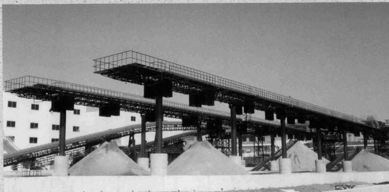
♣ 改良土ヤード(東京都建設残土再利用センター)
