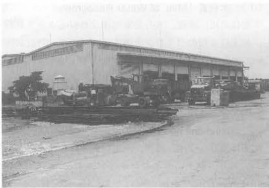
写真—5 アジア開発銀行、クウェート資金等により施工された Dau Ting 灌漑プロジェクト用機械整備工場。建物・内部ともほとんど日本製。
