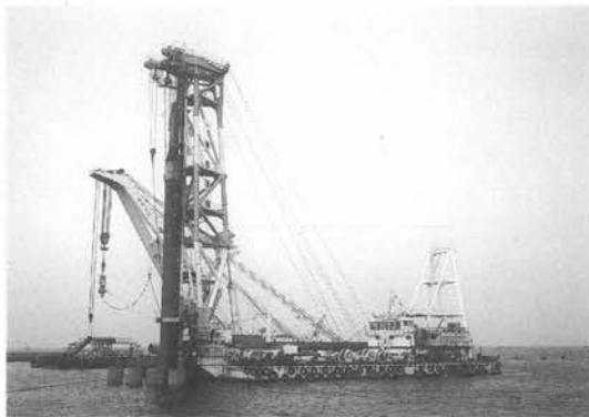
写真-1 1次打設状況
