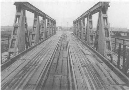
写真—6 サイゴン郊外の鉄道・道路併用橋。トラスの両外側に歩行者・自転車用橋が併設されている。鉄道の便数が少ないので大きい橋は、ほとんどこの方式。いつもすごい雑踏だが、一方通行の切替えの先頭を走ったため写真では、無人(?)となった。
