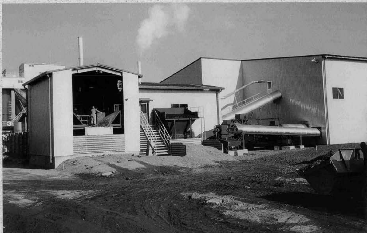
♣ アスファルト塊破碎プラント(日本舗道)
