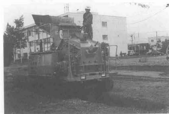
建築解体工事廃棄物用解体ガラリサイクル車
