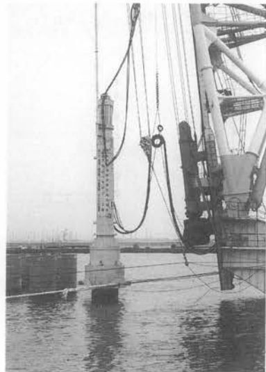
写真-2 2次打設状況
