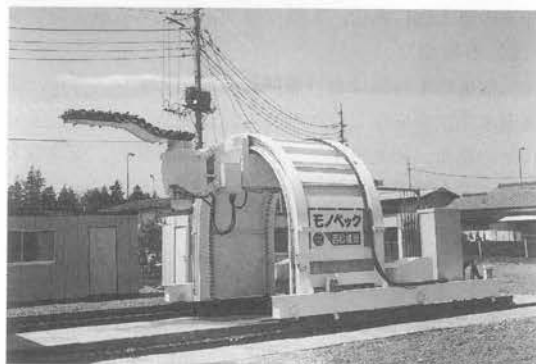
写真-1 モノバック掘削機
