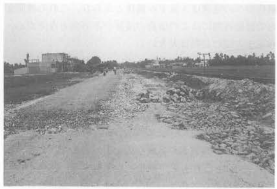
写真—7 幹線道路の補修現場。現場は、日曜日はどこでも全面的に休み。突然訪問しても出てきて親切に説明して下さった所長もあった。写真はオーバーレイ工事。大きな陥没部にグリ石を入れ、バラス、砂の順に。後はローラ、アスファルトスプレー、再びローラで終る。
