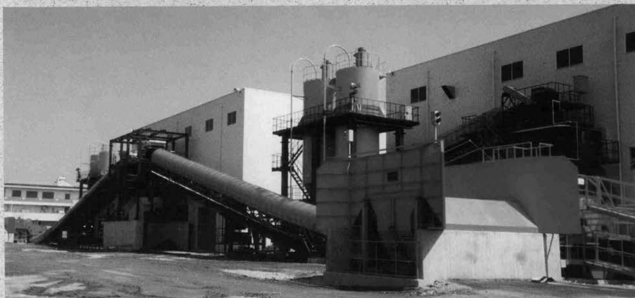
♣ 土質改良プラント(東京都建設残土再利用センター)
