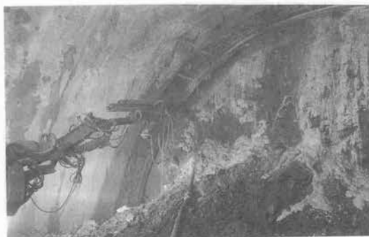
写真-1 管理システムを用いた施工状況
