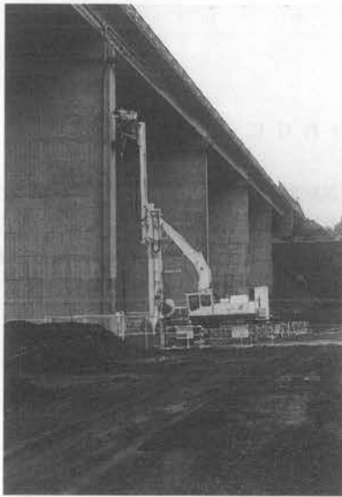
写真—1 橋脚用自動目荒し・はつり装置「コンクリートベッカー」
