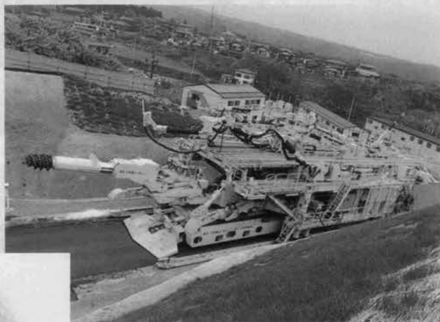
自由断面掘削機と⇨ ガントリージャンボ (里見トンネル)
