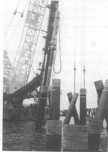
写真-1 施工状況
