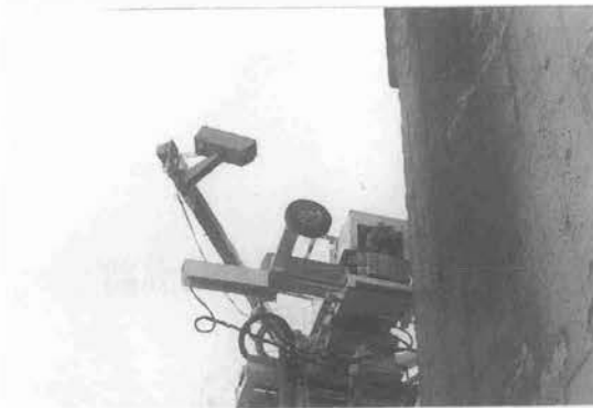
写真—4 ハンマユニット部前面とテレビカメラ
