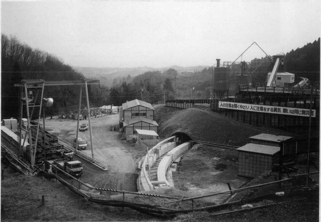
⇨ 秋間トンネル(東)坑口付近のカプセルルート (秋間トンネル(東)工区)
