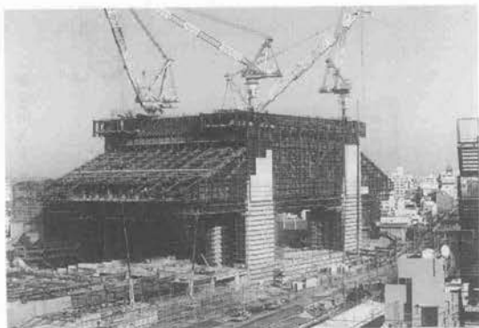
写真-1 鉄骨建方完了
