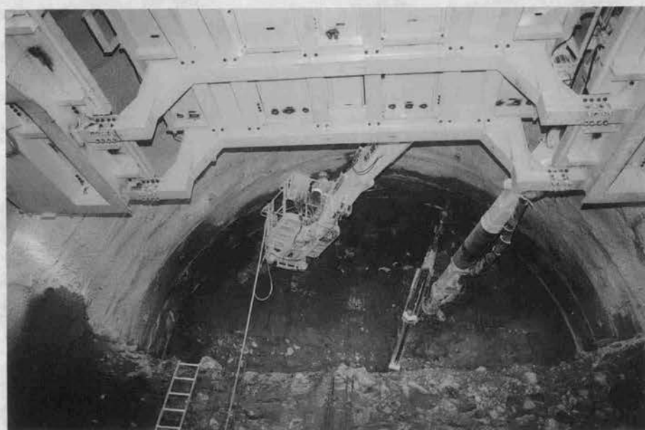
⇨ロックボルト削孔状況 (里見トンネル)
