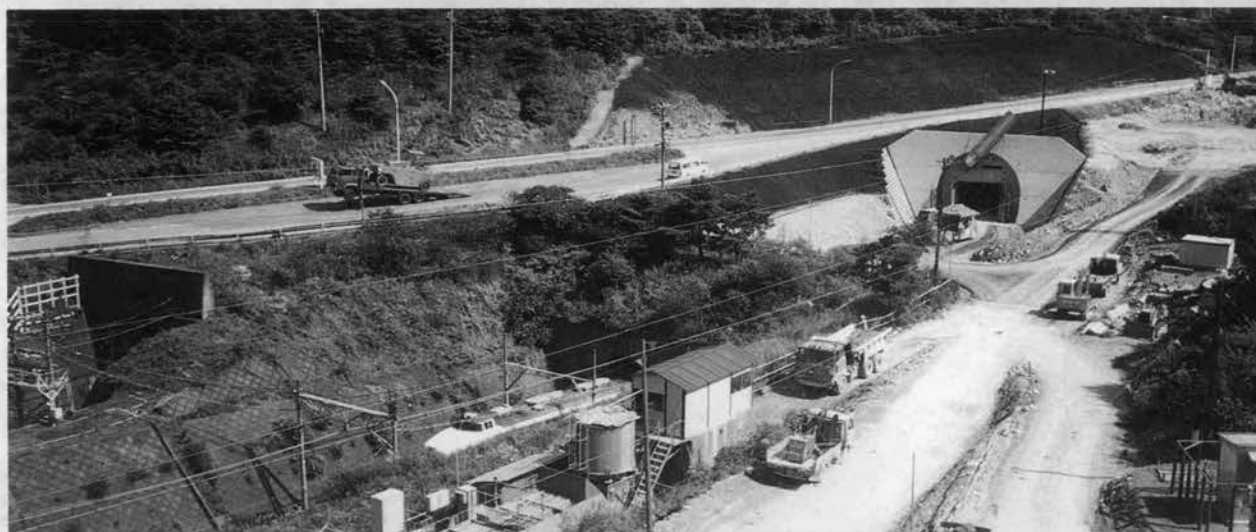
⇨ 信越本線に近接した坑口(碓氷峠トンネル(西)工区)
