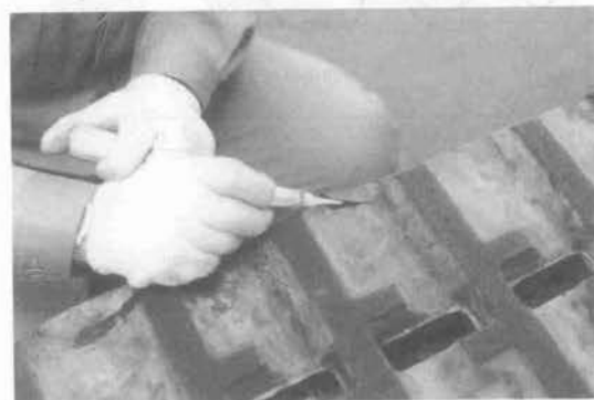
写真-8 瞬間接着剤塗布(端部)
