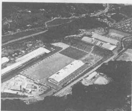
岸山工場全景
