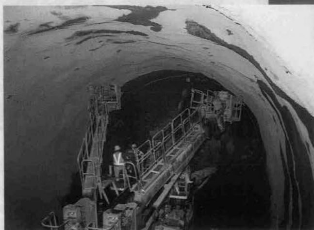
⇨ 3ブーム油圧ジャンボJTH3RS-135 による削孔状況(碓氷峠トンネル(東)工区)
