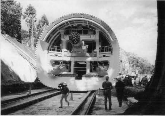
⇨ 掘削覆工併進機械前面 (秋間トンネル(東)工区)
