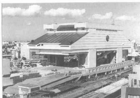
写真-4 完成間近の全景
