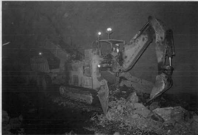
シャブローダ KL31(S)⇨ によるずり搬出状況 (碓氷峠トンネル(東)工区)
