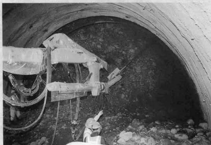
⇨コンクリート吹付機による吹付コンクリート 施工状況 (里見トンネル)
