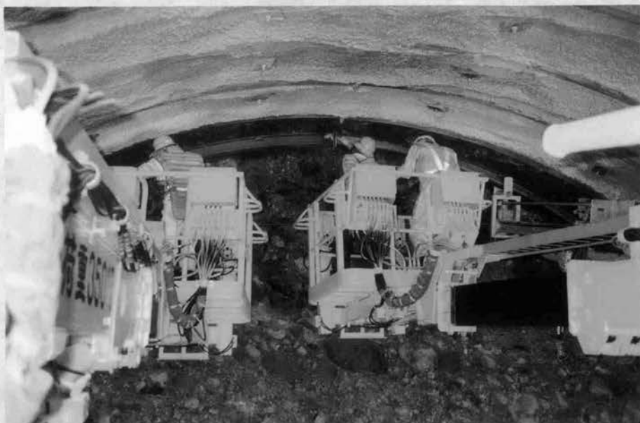
支保工建込状況 (里見トンネル)
