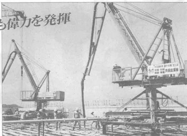
(本四架橋現場設置例)
