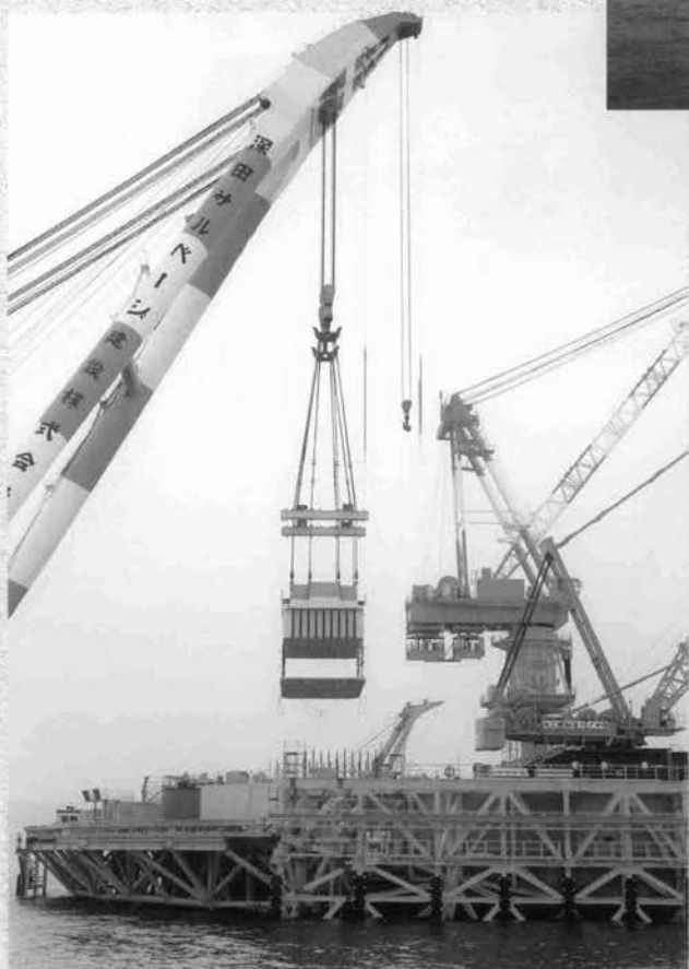
⇨ 底盤第1段ブロックの据付状況 (2,000トン級起重機船により連続して据付けた)
