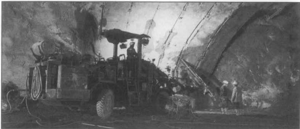
写真-1 Inntal トンネルにおける NATM 工法
