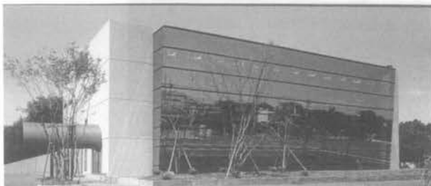
写真-2 本館（超省エネルギービル）
