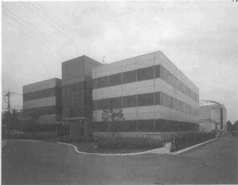
写真-1 技術研究所管理棟・免震・非免震のツインビル（右棟は免震構造、中央・左棟は非免震）
