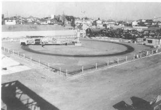
写真—2 円形走路試験路
