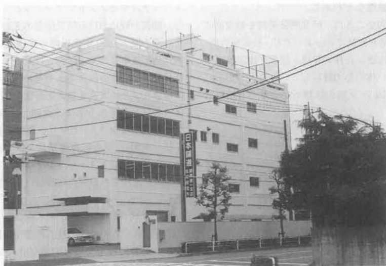
写真—1 日本舗道技術研究所
