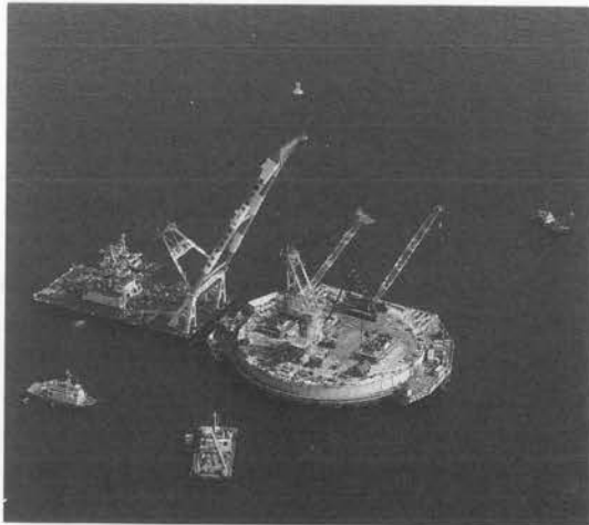
写真-2 仮設備および主塔第一段ブロックの据付状況
