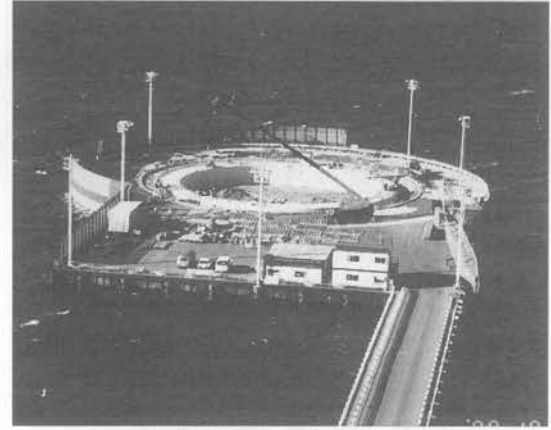
写真-6 石炭灰埋立法（室蘭白鳥大橋）
