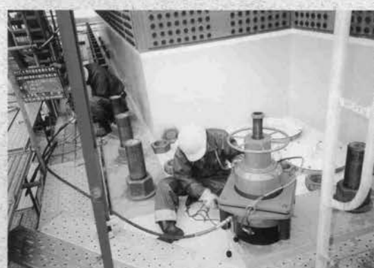
⇨ アンカーボルトの軸力導入状況 (油圧ジャッキにより120本のアンカーボルトに 1本当り530tの軸力を導入した)
