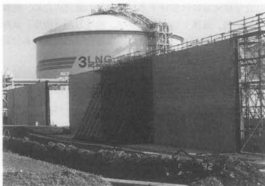
写真一六 超高流動コンクリート LNG タンク防液堤
