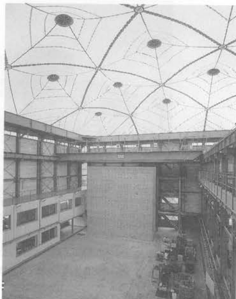
写真—2 膜構造大型構造物実験棟・反力壁
