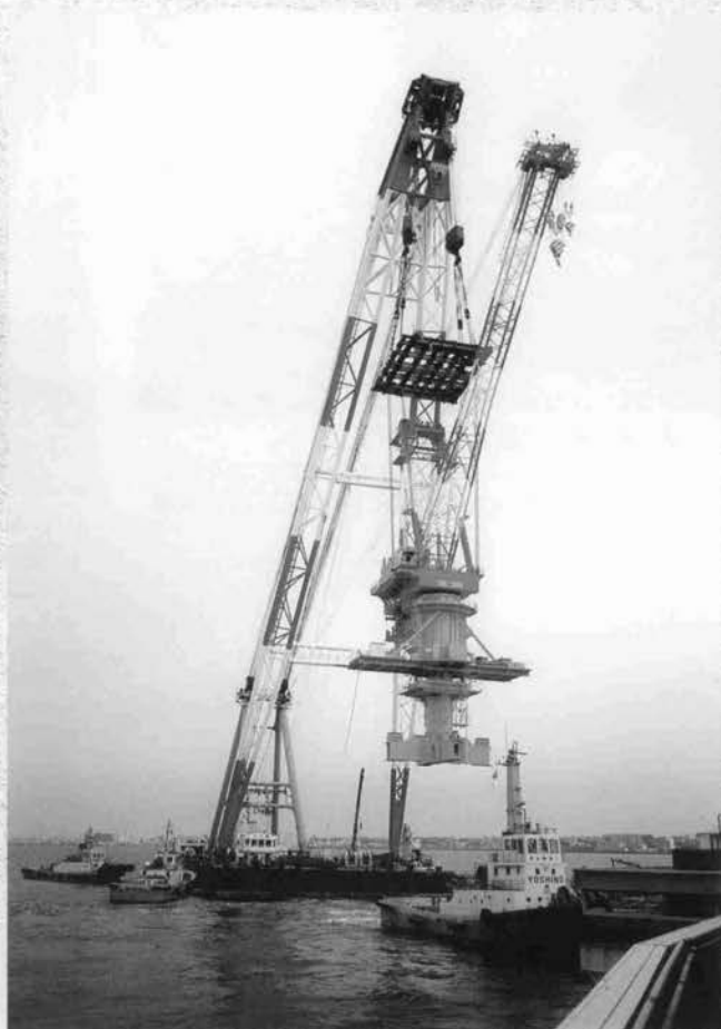
⇨ 架設クレーンの据付状況 (工場岸壁で組立て、試運転の後、2,000 トン級の起重機船で運搬、据付けた)
