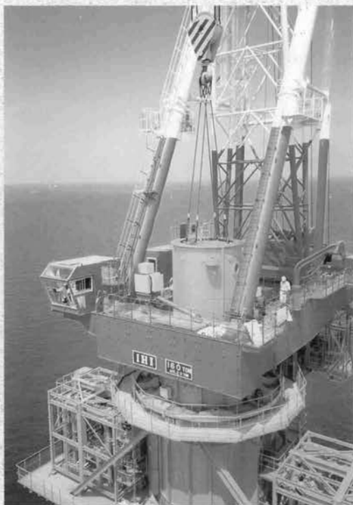
⇨ フライミング中の架設クレーン (クレーン自身でポストを継ぎ足した)
