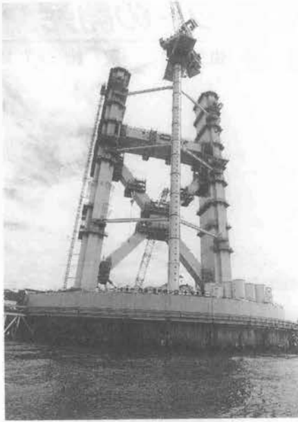
写真—3 主塔架設状況
