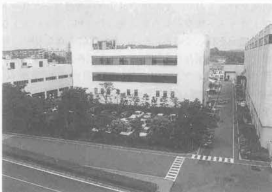
写真-4 土質岩石実験棟
