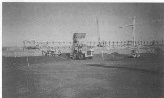
写真-7 鉄鉱石敷込, 転圧
