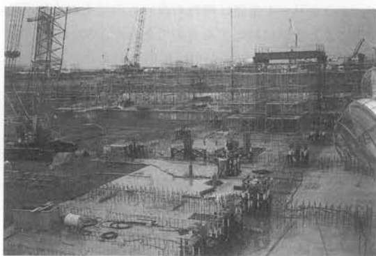
写真-8 基礎耐圧版コンクリート打ち, アンカーフレームセット
