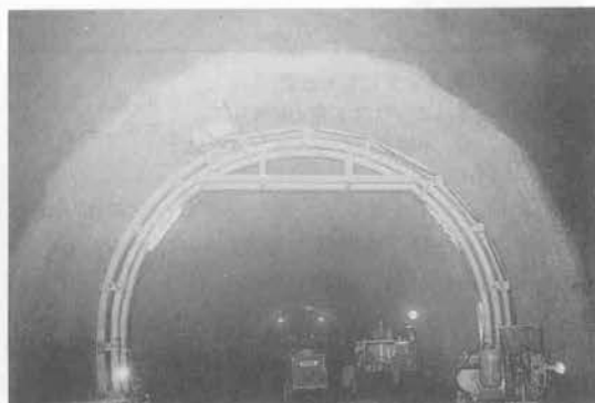
写真-1 防水膜施工状況
