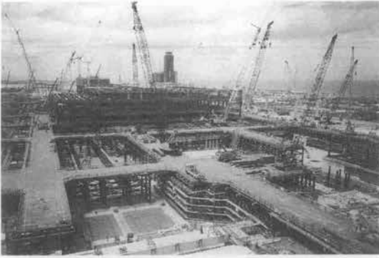
写真-9 工事近況 (本館)
