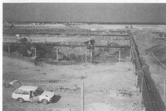
写真-5 掘削工事
