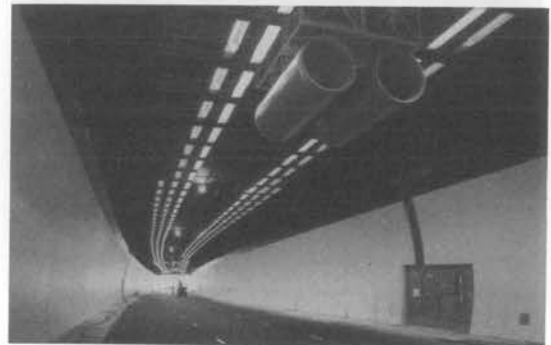
写真-1 高圧ブローによる換気の実施例
