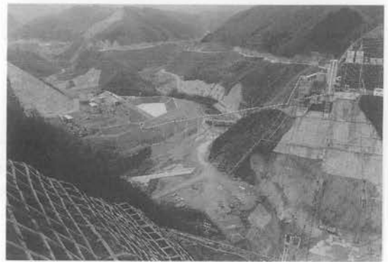
写真—3 仮設備全景
