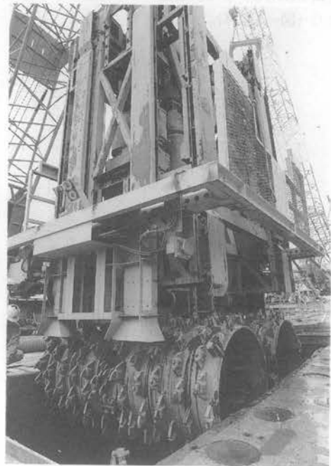
写真-2 掘削機全景
