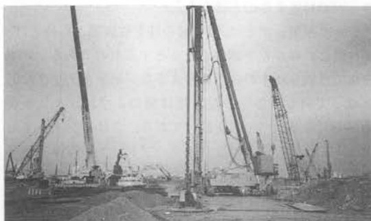
写真-4 止水壁工事
